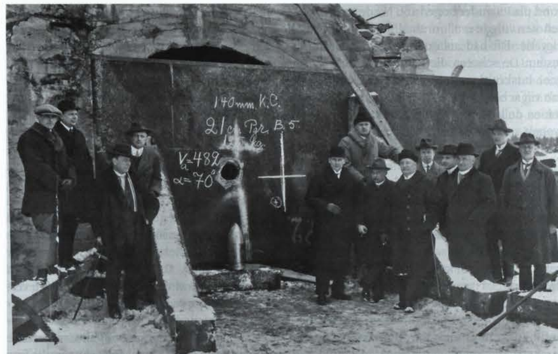
Afb. 1. 1082, in februari 1926 was een Nederlandse artilleriemissie onder leiding van de kapitein-ter-zee J.J.M. Baart als gast bij de beproeving van een pantsergranaat van 21 cm voor de Zweedse marine, die een 14 cm pantserplaat van Krupp doorboorde. Bij de schietkuil staan de Schiesplatzvorsteher (vierde figuur van links, leunend tegen de steun van de plaat), en aan de rechterzijde vooraan de artilleriedirecteur (met bolhoed), daarnaast kolonel Baart, rechts van hem de 'disponent' (algemeen directeur) Holm van Bofors. Achter de steun en met de handen in de zakken de directeur van de Artillerie Inrichtingen aan de Hembrug ir. Van Dam, rechts van hem de directeur van de kruisfabriek te Muiden ir. D. de Kreuk, en achter beide laatsten de luitenant-ter-zee 1e klasse A.G. Vromans.
