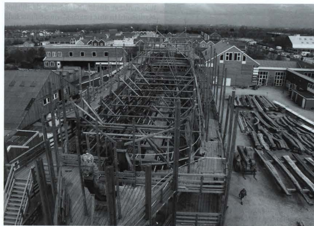
Afb. 4. Bouw van de replica van De Zeven Provinciën, het vlaggenschip van admiraal De Ruyter, op de Bataviawerf te Lelystad. Foto: Bataviawerf te Lelystad.
