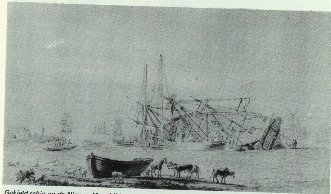
Gekield schip op de Nieuwe Maas bij het eiland Feijenoord. Geheel rechts de mond van de Rotterdamse Leuvenhaven met de Witte Poort. Het schip, een oorlogsfregat, wordt met een kiellichter scheefgetrokken. Links op de wal ziet men een vuur en pekketels. (Gewassen tekening, Maritiem Museum "Prins Hendrik", Rotterdam, P 1083).
