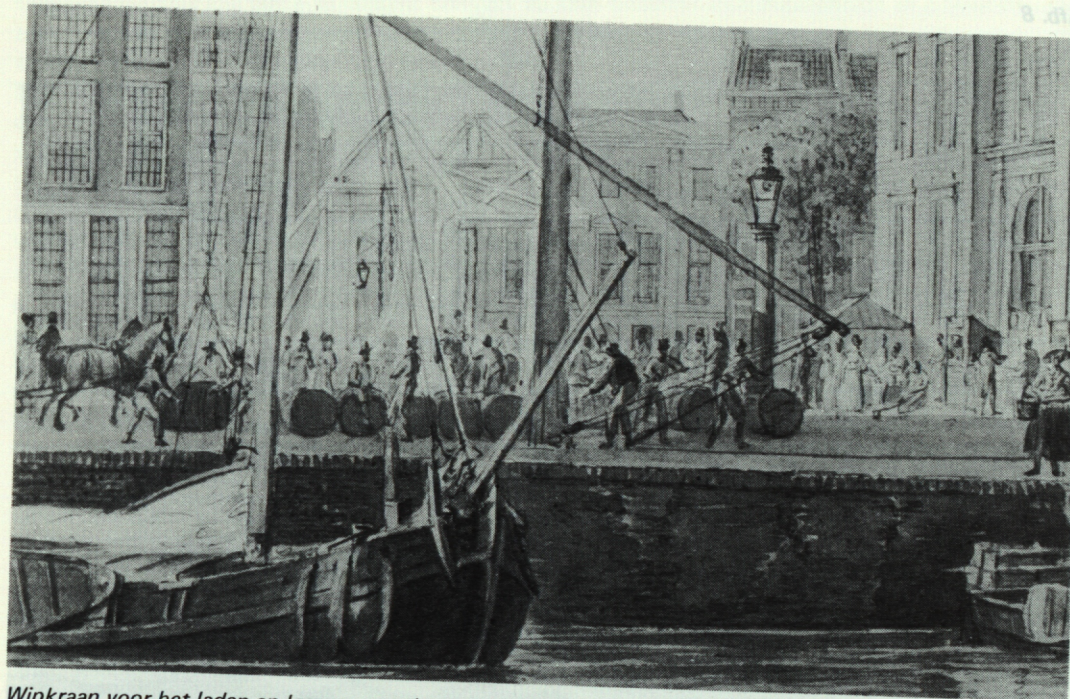
Wipkraan voor het laden en lossen van schepen aan de Kolk. Rechts een gedeelte van de Beurs, op de achtergrond de Blaak. (Detail van een aquarel, Gemeentearchief Rotterdam, XIV 13).
