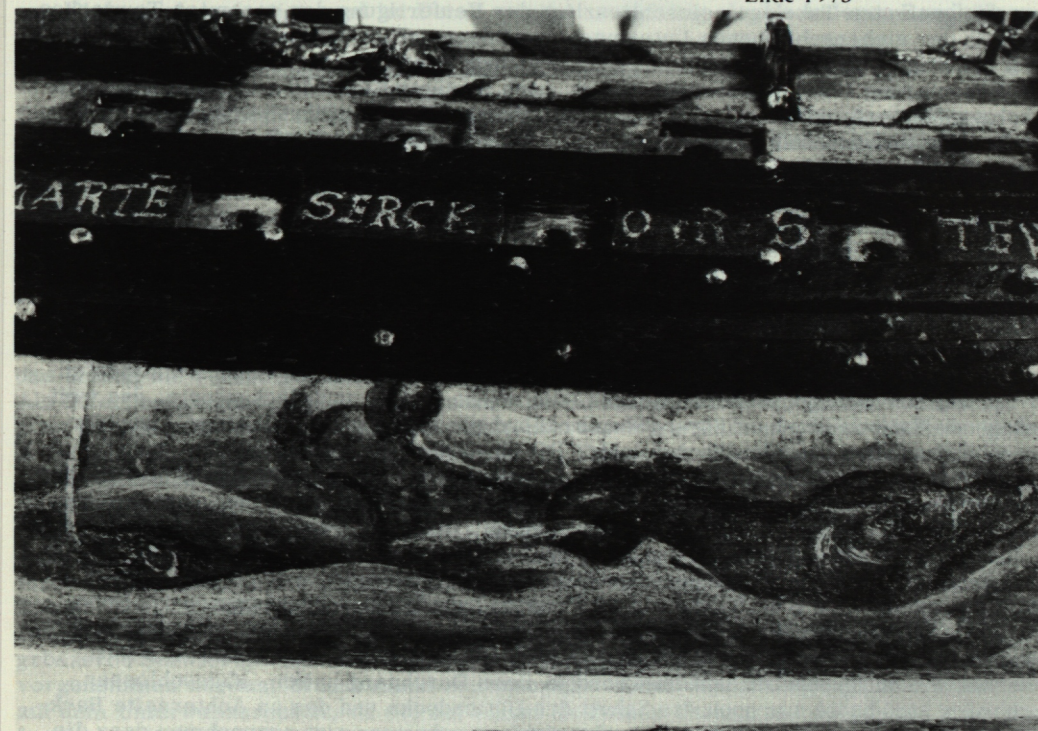
Modell 'Lübeck, 1617': Teil des Unterwasserschiffes mit Bemalung und Schriftband, Steuerbord mittschiffs: nach der Restaurierung, Ende 1973
