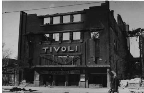
Puinresten van de Tivoli schouwburg op 1 juni 1940, enkele weken na het bombardement. De reclamebanier met Suikerfreule hangt nog. Collectie Stadsarchief Rotterdam.
