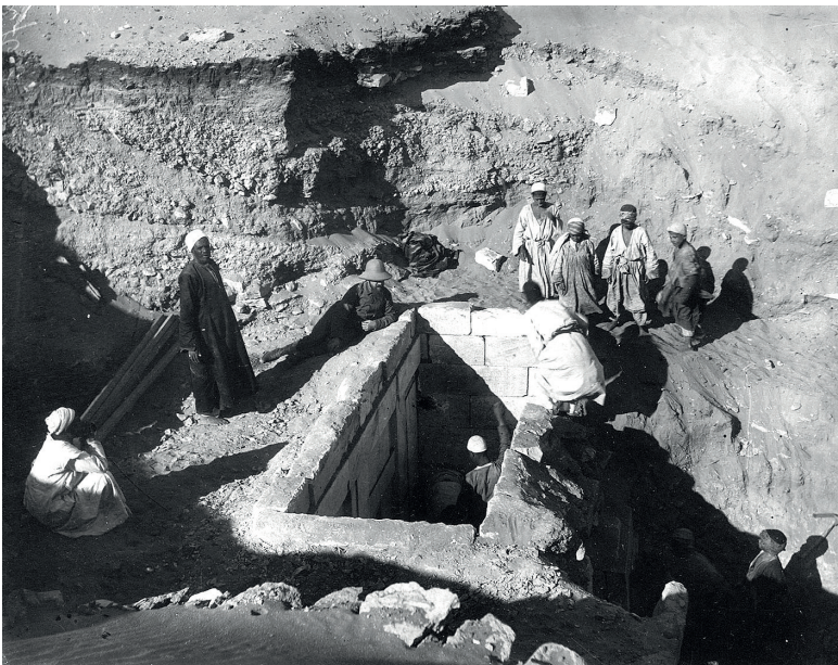
Fig. 5. Jean Capart, accoudé à l'angle nord-ouest de la chapelle funéraire de Nefertitenef, et un autre homme debout à gauche (le reis ?) observent les progrès du déblaiement du monument.
