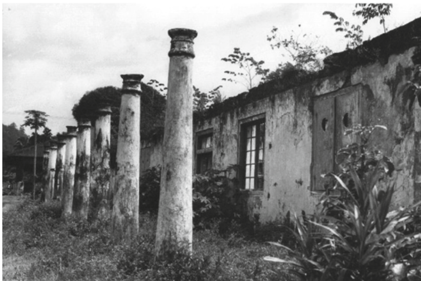
Afbeelding 15. Overblijfselen van de voorgalerij van het Compagnies hospitaal te Neira. 226
