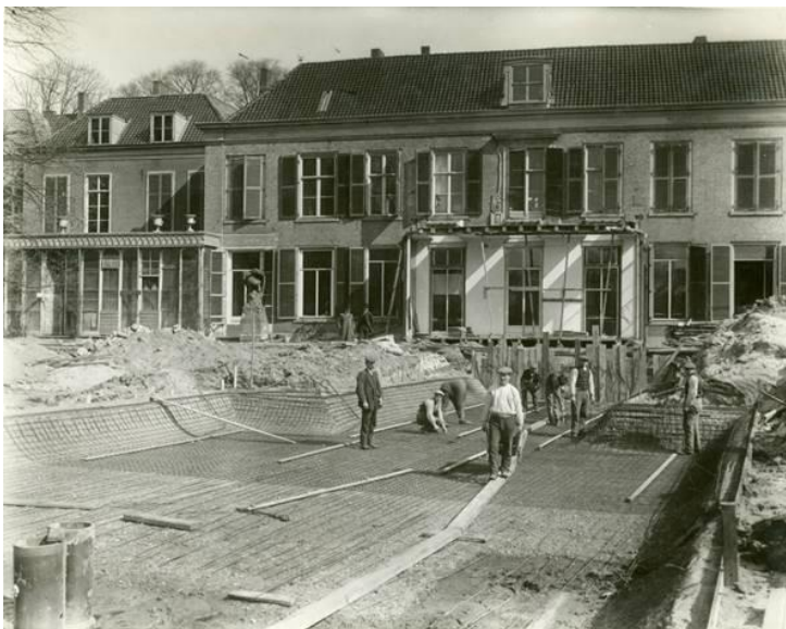
179 (l) en 180 (r). Betonvlechten voor aanleg van de vijver ten noorden van het Vredespaleis. Links op de achtergrond (zie ook detail rechts) de adelaar naast de gesloopte neogotische aanbouw van paleis Buitenrust, ca. 1912. Collectie en foto GADH, inv. nr. 062995.
