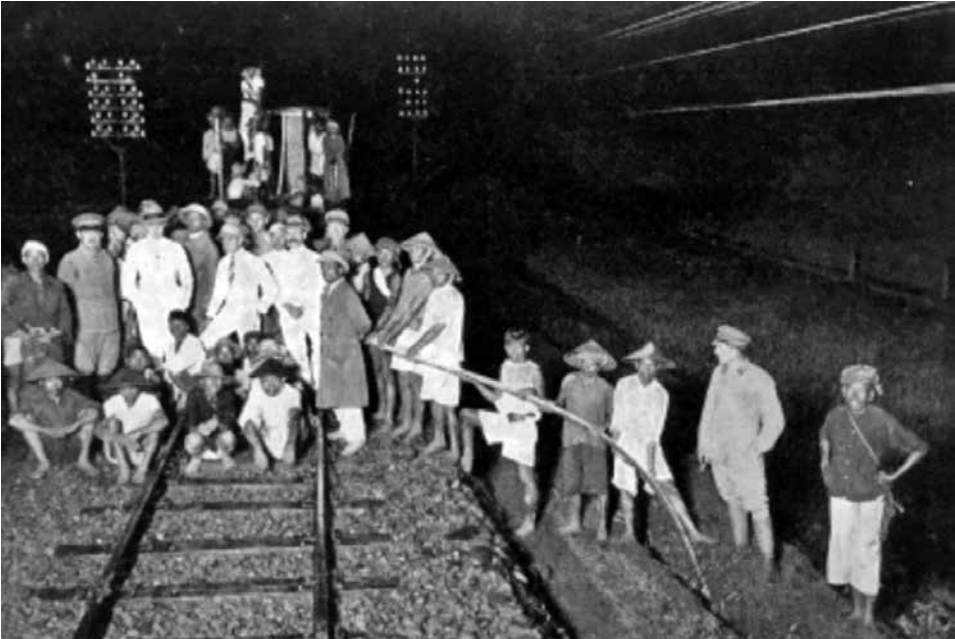
Nachtelijke kabellegging tusschen Bandoeng en radioontvangststation te Rantja-Ekek, uit: Jaarverslag Indische Post, 1929.
