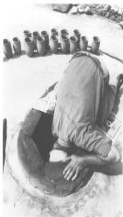
Τοποθέτηση από πάνω των τελευταίων στρώσεων στον κεραμικό κλίβανο. Εργαστήριο στον Άγιο Στέφανο, 1978.
