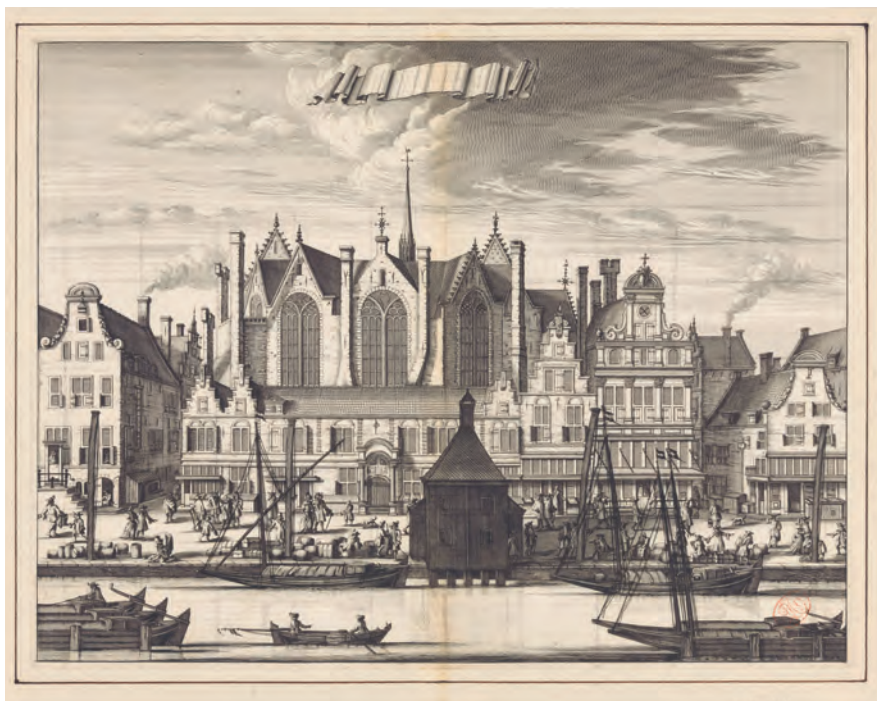
3.14 Anoniem, 'De Heylige Steede en de Nieuwe-Zyds-Kapel, 1694. Het huidige Rokin 84-72 met het zich op de Nieuwezijds Kapel. In één van deze huizen was rond 1700 de winkel van de familie Audrouin gevestigd. De huizen zijn inderdaad als winkels uitgerust, met onderluiken die als uitstalluiken gebruikt kunnen worden, en houten puilen om de koopwaar te beschermen tegen het weer. Ets, 262 x 341 mm. Rijksmuseum, inv.nr. RP-P-AO-23-33.
