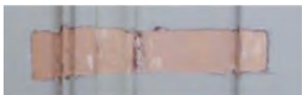
5.21 Kleurtrappen met de eerste, roze afwerklaag op kozijn en deur in de kleine zijkamer. Foto: Bert Jonker.
