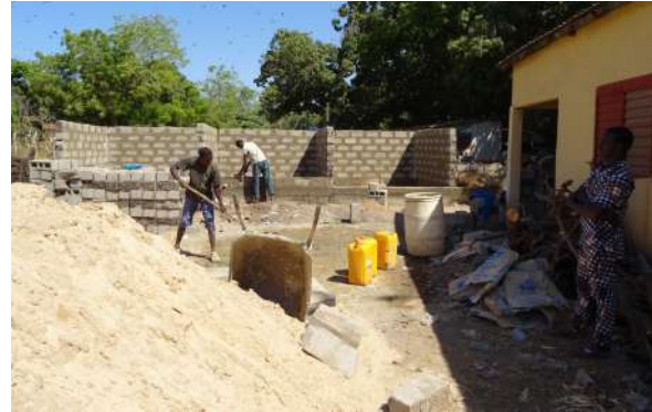
Photo 8 : Construction de logement sur la parcelle offerte par la mairie
