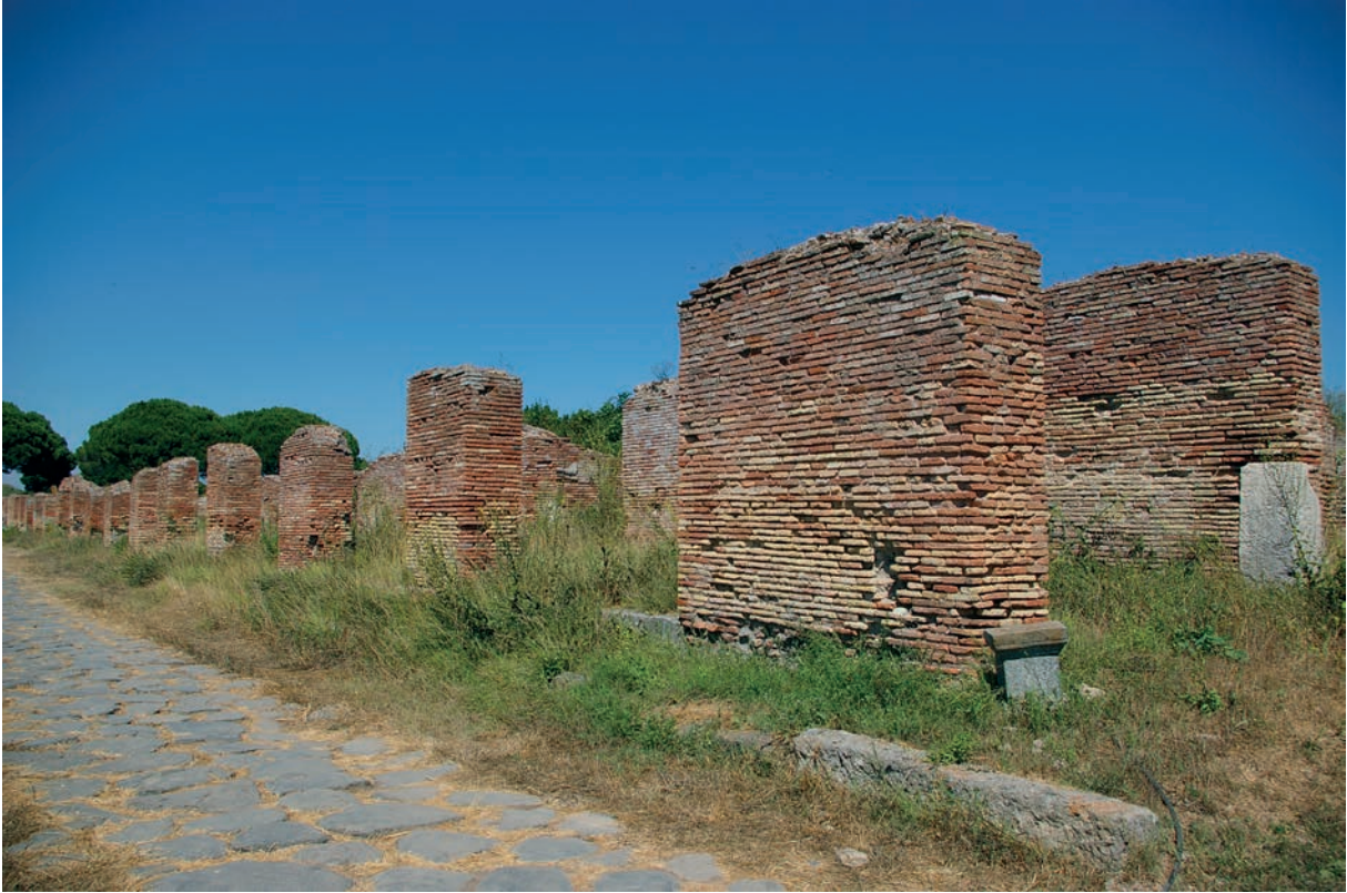
Fig. 6. Caseggiato della Fontana con Lucerna (IV, VII, 1-3) with portico in front of it.
