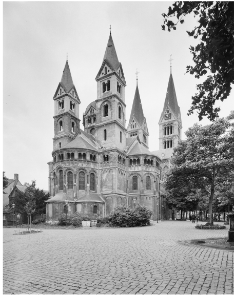
Afb. 4: De klaverbladvormige oostpartij van de munsterkerk in Roermond (foto Th. Heijns, 2001. Amersfoort, Rijksdienst voor het Cultureel Erfgoed 349932).
