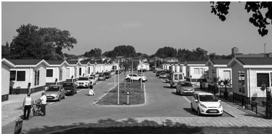
Afb. 18 Woonwagencentrum Molenhof in Rijswijk, na de renovatie in 2014. Door de bredere opzet, meer ruimte tussen de wagens en de aanleg van een straat met een middenberm en aan weerszijden parkeerhavens en een trottoir, kreeg het woonwagencentrum meer het karakter van een gewone woonwijk. Foto: René Verleg.
