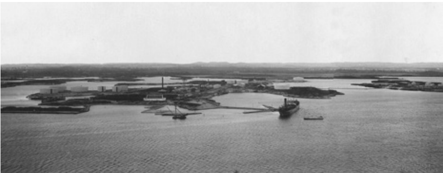
De eerste fase van de olieraffinaderij op het schiereiland van de voormalige plantage Asiento in het Schottegat, ca. 1919 (Coll. NMVW).
