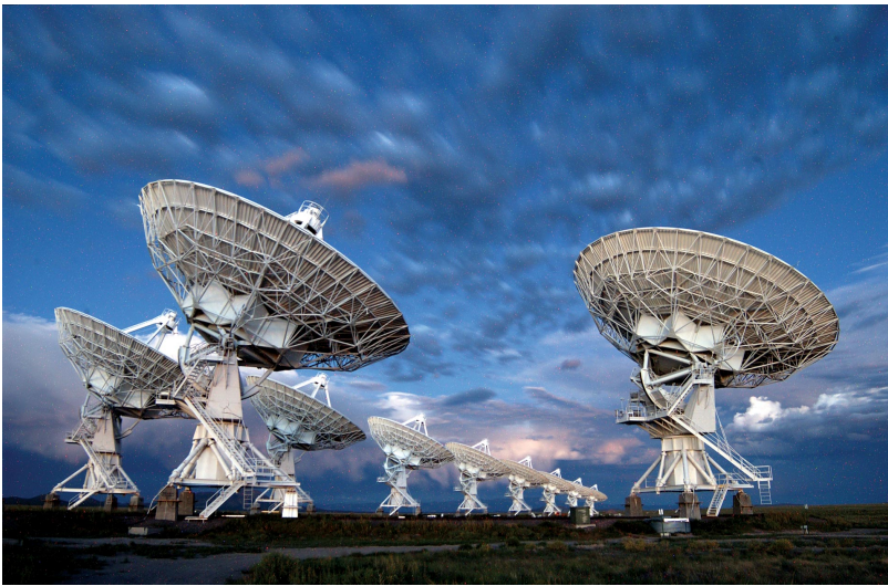
Figure 4: De Karl G. Jansky Very Large Array (VLA), oorspronkelijk gebouwd in the de jaren '70 van de 20ste eeuw in de Verenigde Staten, is de meest productive (én iconische) radiotelescoop ter wereld. Hoewel het wolkendek hangende boven de telescoop elke optische waarnemingen zou verhinderen, is dit geen probleem voor een radiotelescoop. Bron: National Radio Astronomy Observatory.
