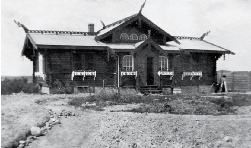
De Noorse blokhut in Dahlem waar Van 't Hoff zijn laatste onderzoeken aan planten-enzymen uitvoerde.
