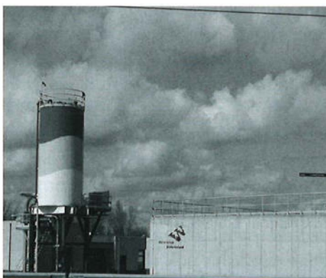
Een waterzuiveringsinstallatie van het waterschap 'Rivierenland'.
