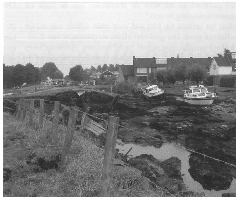
Na een hittegolf in augustus 2003, brak de veenkade van de dijk bij Wilnis vanwege uitdroging. Het Utrechtse dorp kwam deels onderwater te staan.
