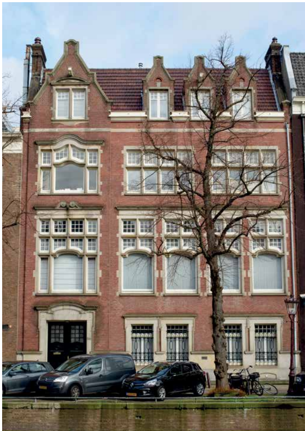
19. A. Salm, bankgebouw voor de firma's Van Loon & Co en Hope en Co, Keizersgracht 579-581, Amsterdam, 1899 (fotograaf: M. van Woerden).
