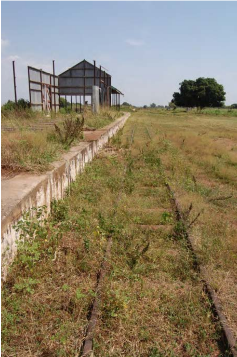
Foto 4 Het treinstation in Mukura
