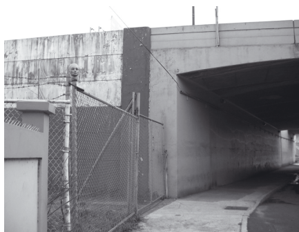
Puente de la calle Canals
