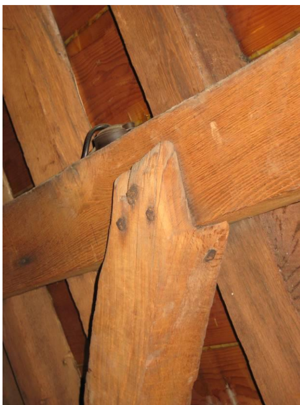
Derde spantconstructie, windschoor gelipt om gording
