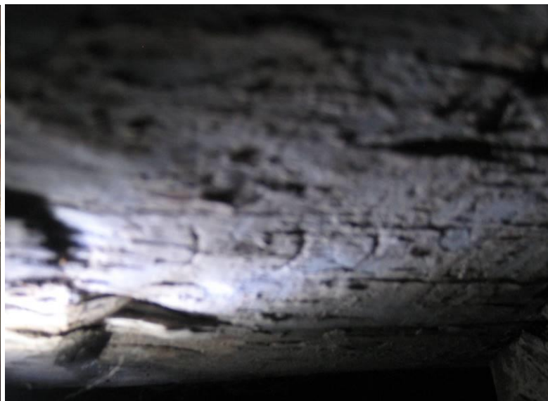
Dekbalk met telmerk ))) en aftekenlijnen
