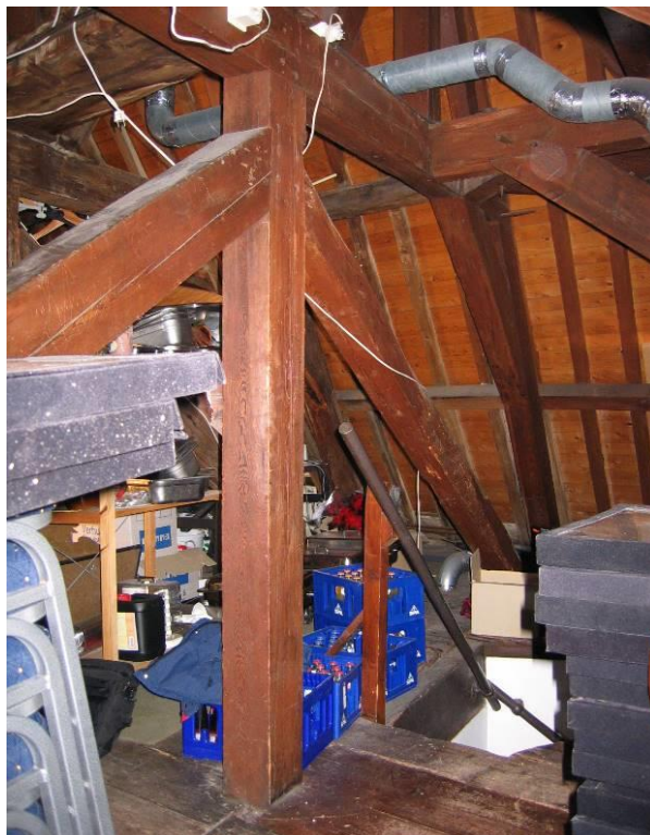
Overzicht onderste spantconstructie met hangwerk
