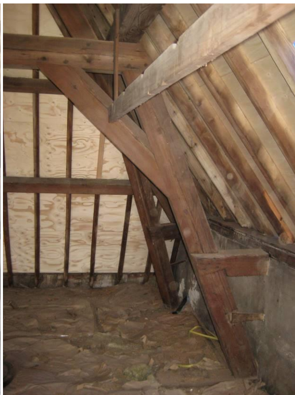
Overzicht onderste spantconstructie
