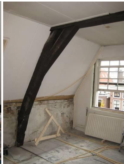
Onderste spantconstructie
