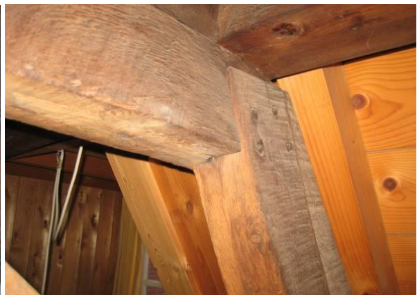
Middelste spant met halfhouts verbinding
