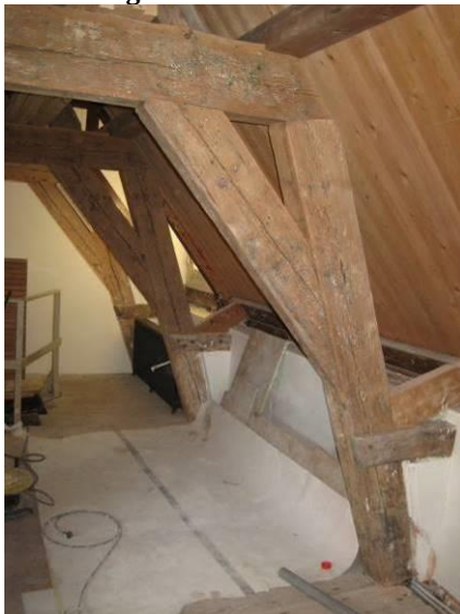
Onderste spantconstructie
