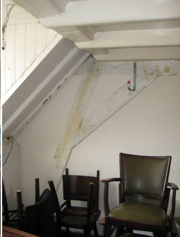
Spantconstructie onderste spant
