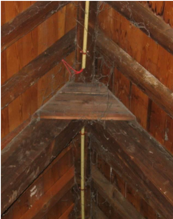
Nokconstructie met schetsplaat
