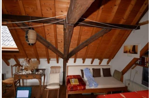
Constructie spant en windschoren
