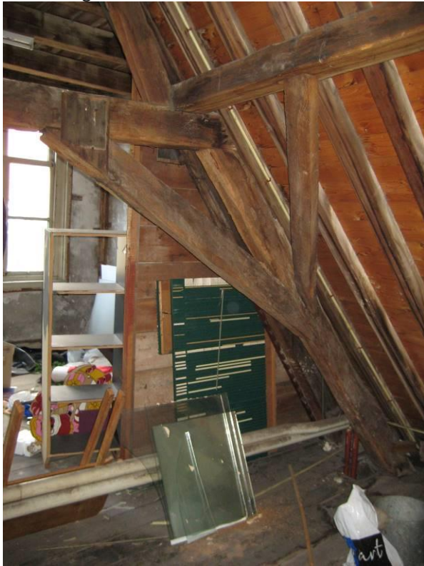
Spantconstructie onderste spant
