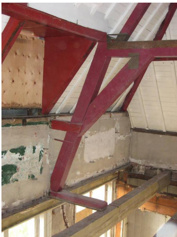
Spantconstructie onderste spant
