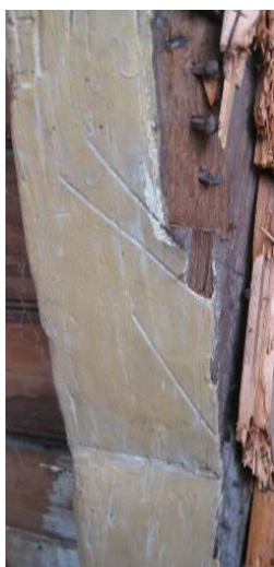
Doorgezaagd handelsmerk II, spant rechtsvoor
