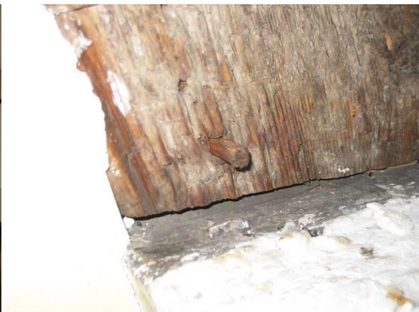
Spantbeen onderste spant met wigje
