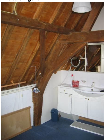
Spantconstructie
