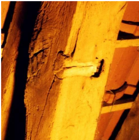
Spantbeen met vlotplug
