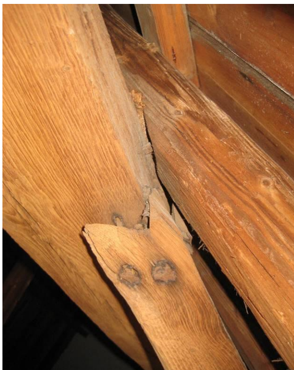
Fliering met gelipte windschoor en vernagelde spoor
