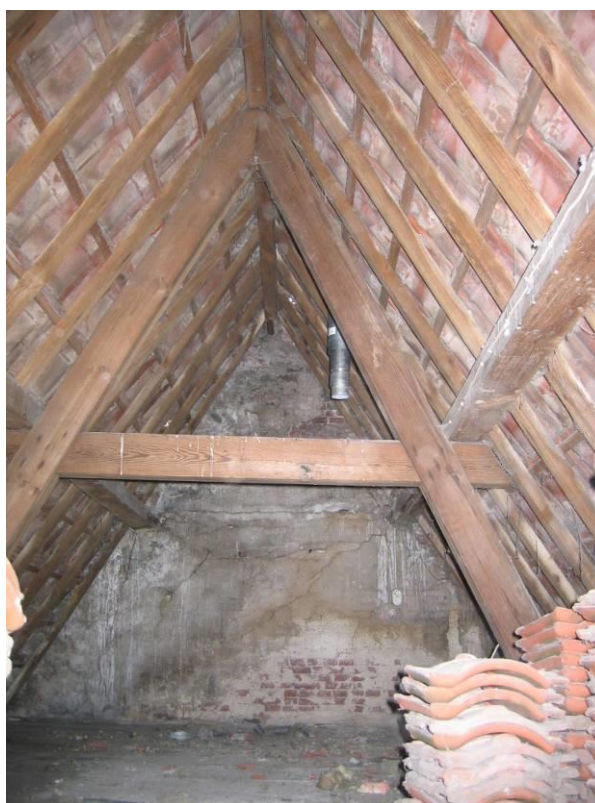
Overzicht spantconstructie achterzijde
