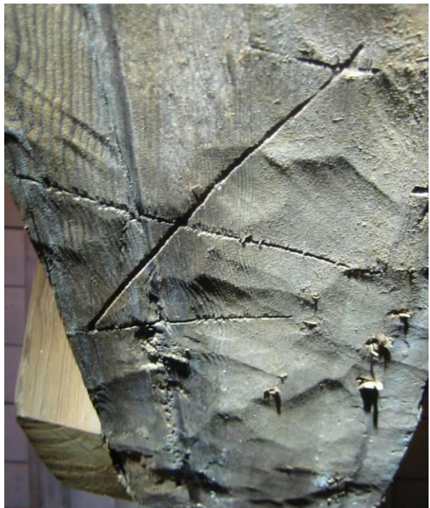
Haksuren en 'handelsmerk' op onderzijde dekbalk
