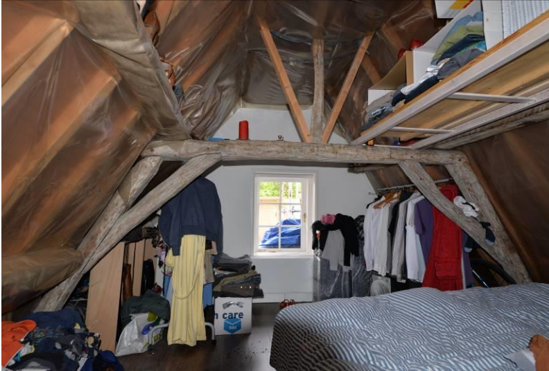
Onderste spantconstructie
