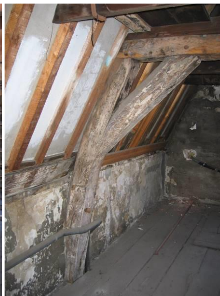
Onderste spantconstructie
