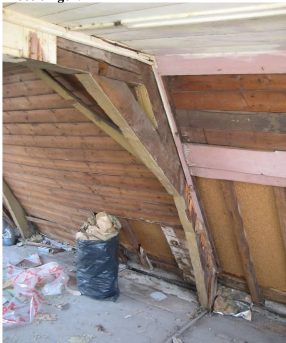
Onderste spantconstructie
