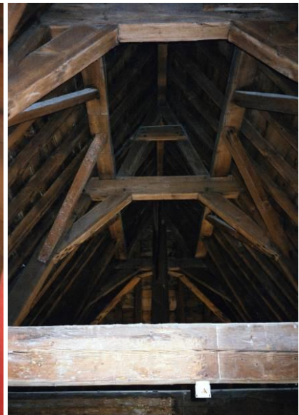
Standaard bovenste spantconstructie
