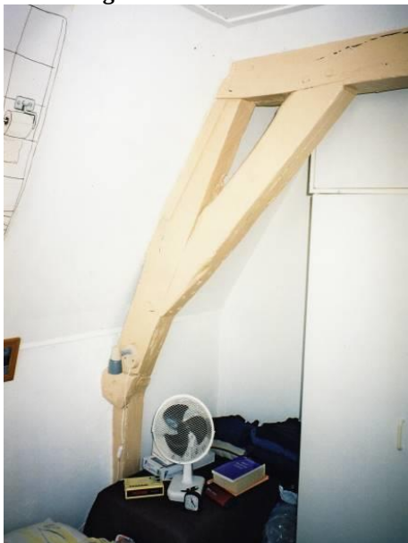
Onderste spantconstructie
