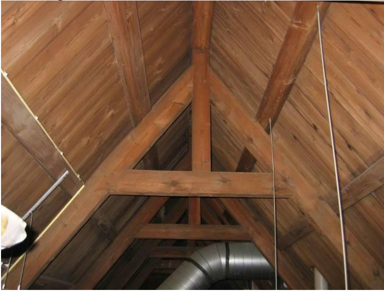
Overzicht spantconstructie
