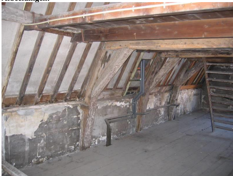
Onderste spantconstructie
