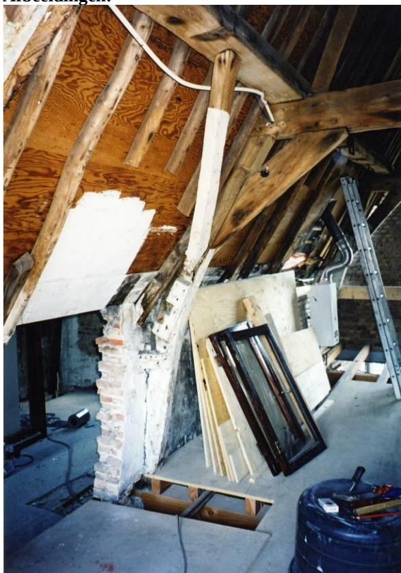
Onderste spantconstructie
