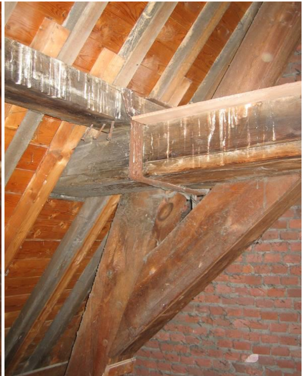
Keulse goot parallel aan spant
