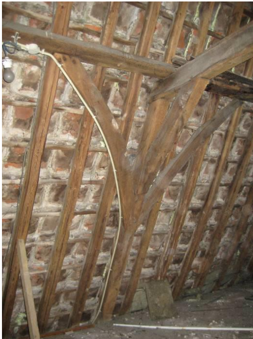
Spantconstructie bovenste spant
