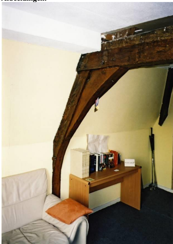
Onderste spantconstructie
