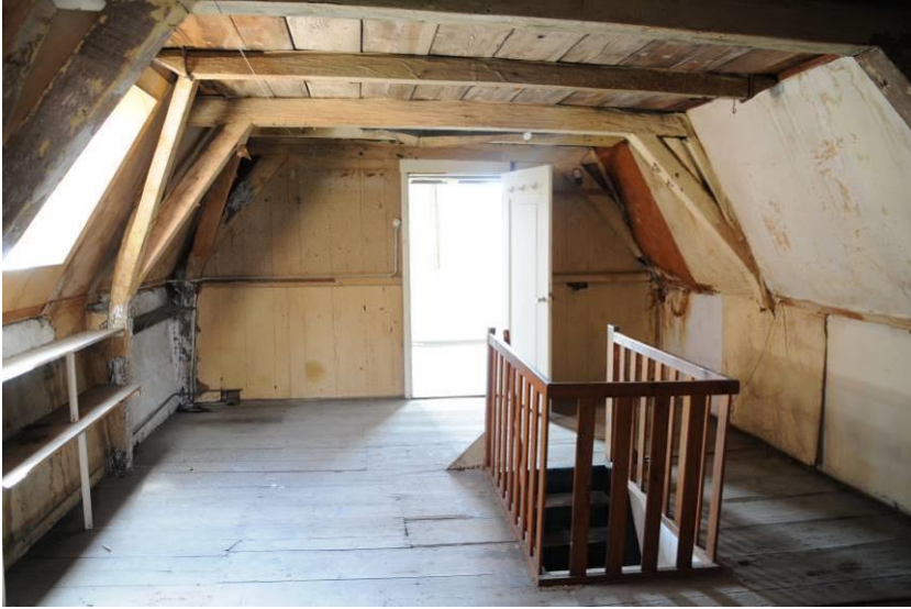
Spantconstructie zolder
