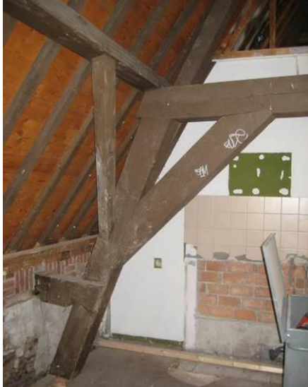
Spantconstructie onderste spant, links
