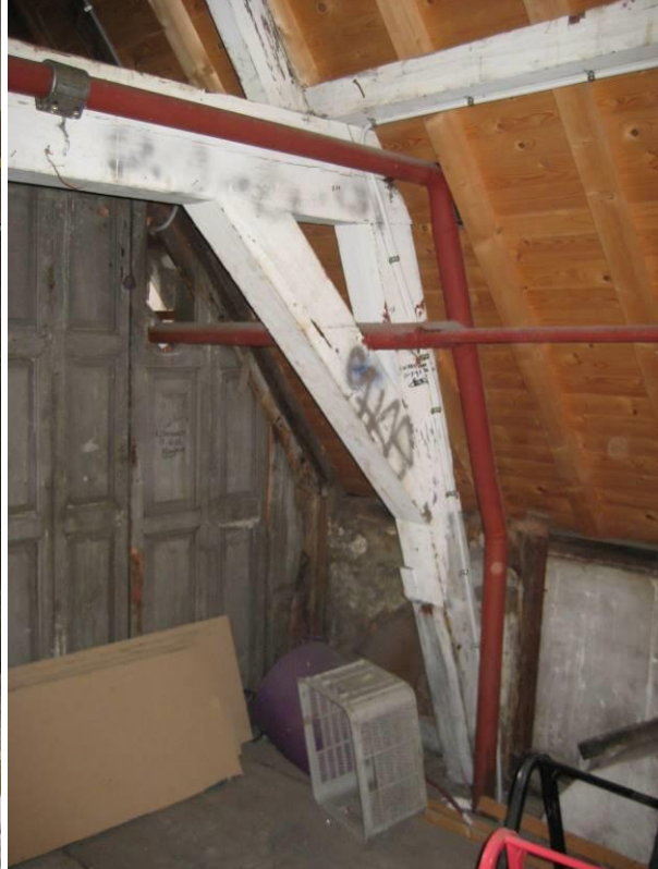
Overzicht onderste spantconstructie
