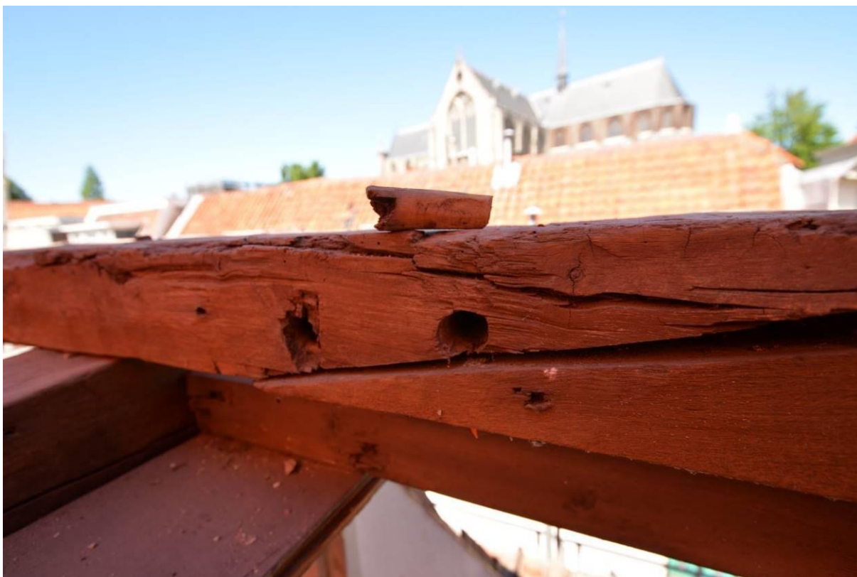
Fliering met vlotgaten en losse vlotplug
