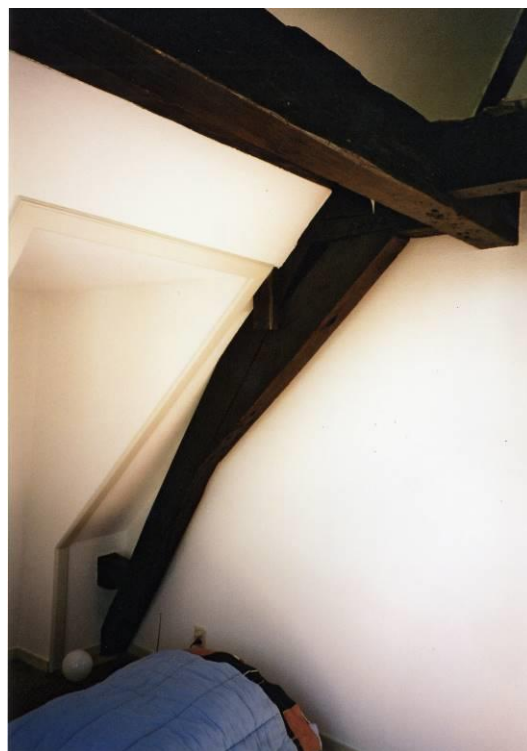
Overzicht onderste spantconstructie achter
