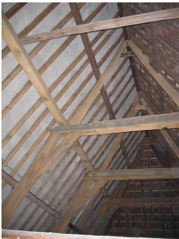
Tweede en bovenste spantconstructie
