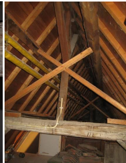
Tweede (bovenste) spantconstructie
