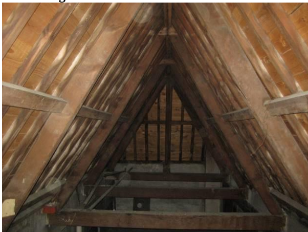
Overzicht spantconstructie
