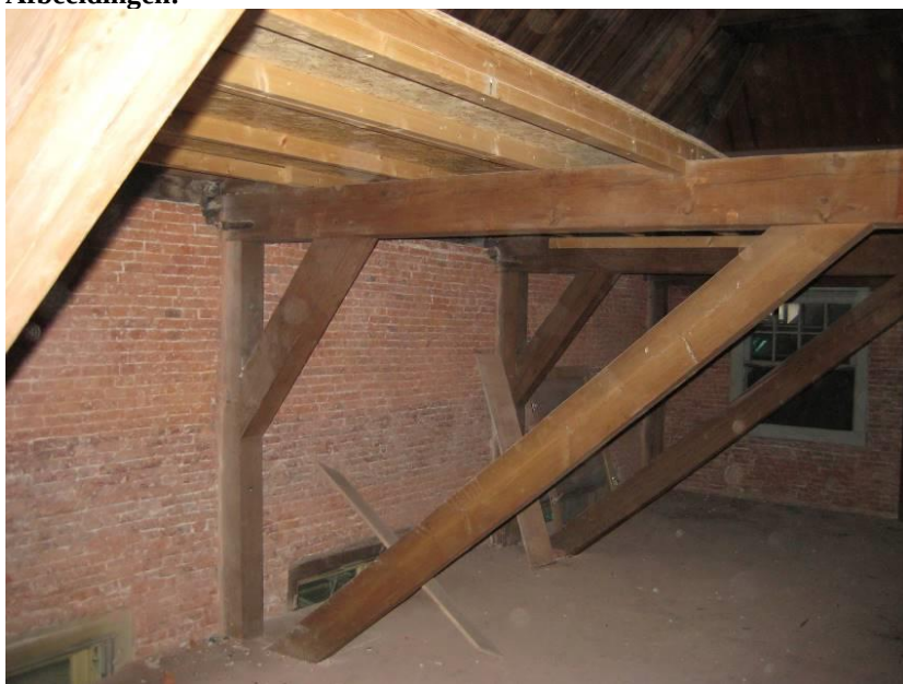
Overzicht onderste spantconstructie
