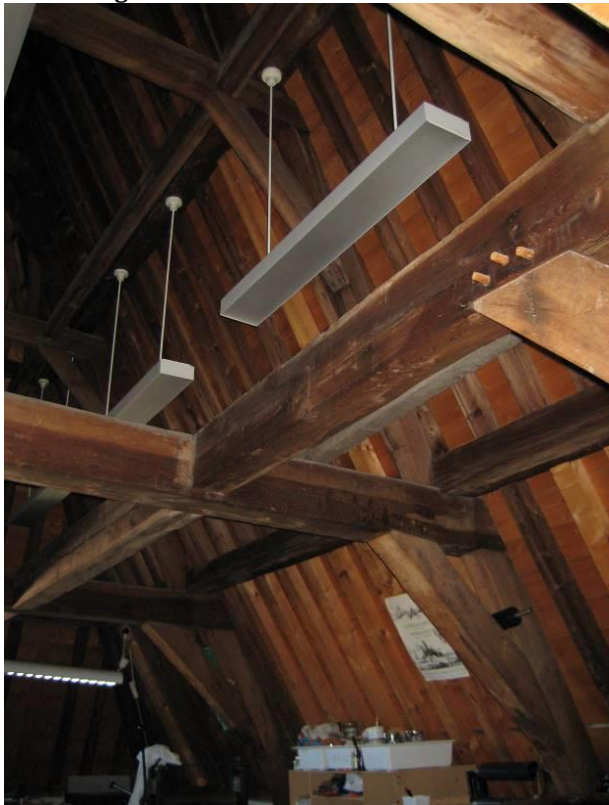
Onderste spantconstructie
