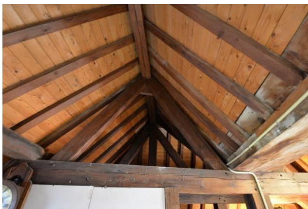
Overzicht bovenste spantconstructie
