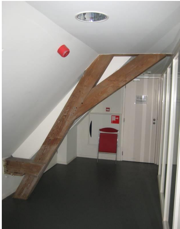
Overzicht onderste spantconstructie, achter
