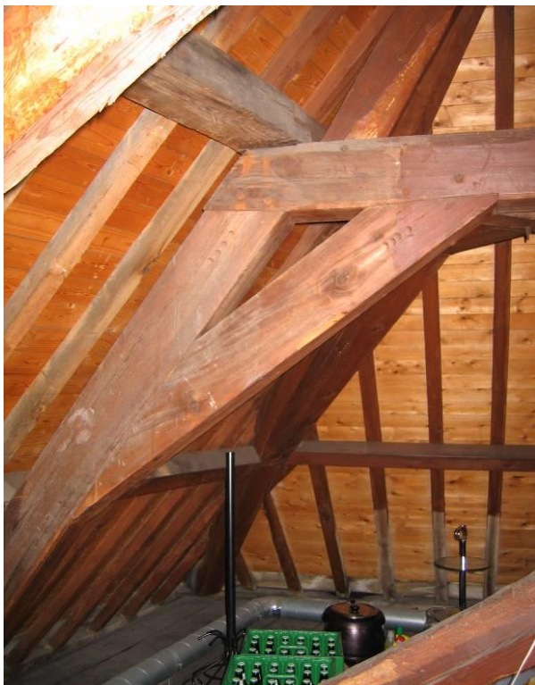
Overzicht onderste spantconstructie
