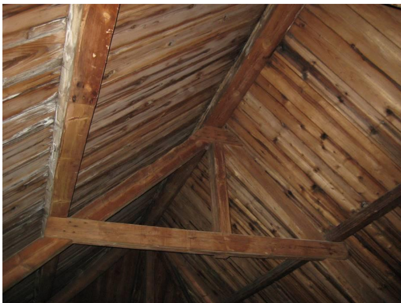
Overzicht bovenste spantconstructie
