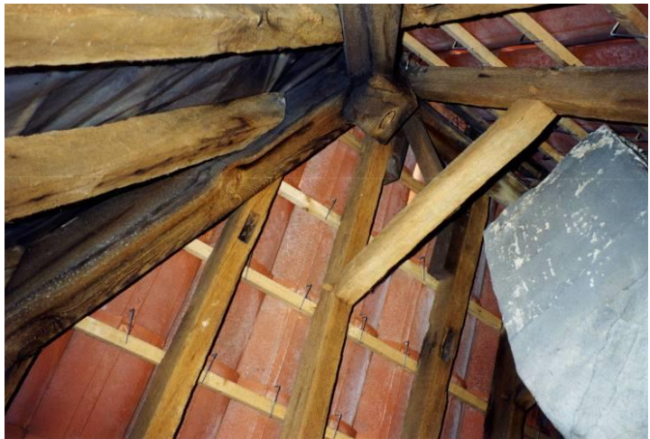
Sporen, haanhout en toegevoegde makelaar met hoekkepers
