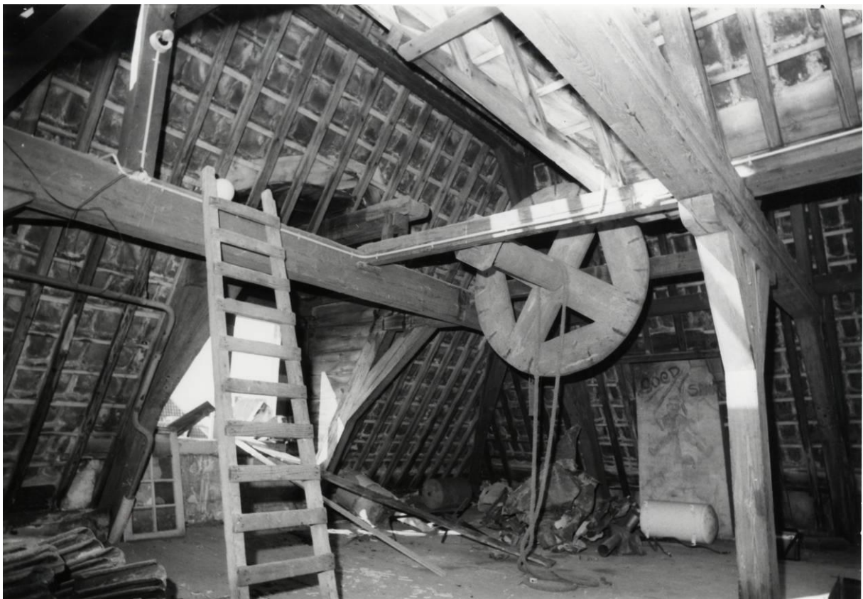
Overzicht spantconstructie met variant met makelaar
