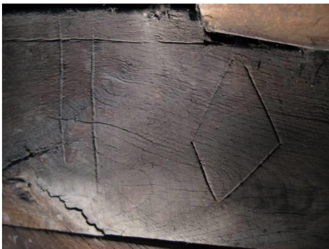
Telmerk II met visje als richtingsteken en een kraslijn
