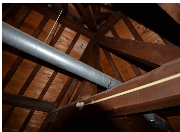
Overzicht bovenste spant met variant met makelaar
