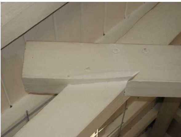
Spantbalk en spantbeen bovenste spant
