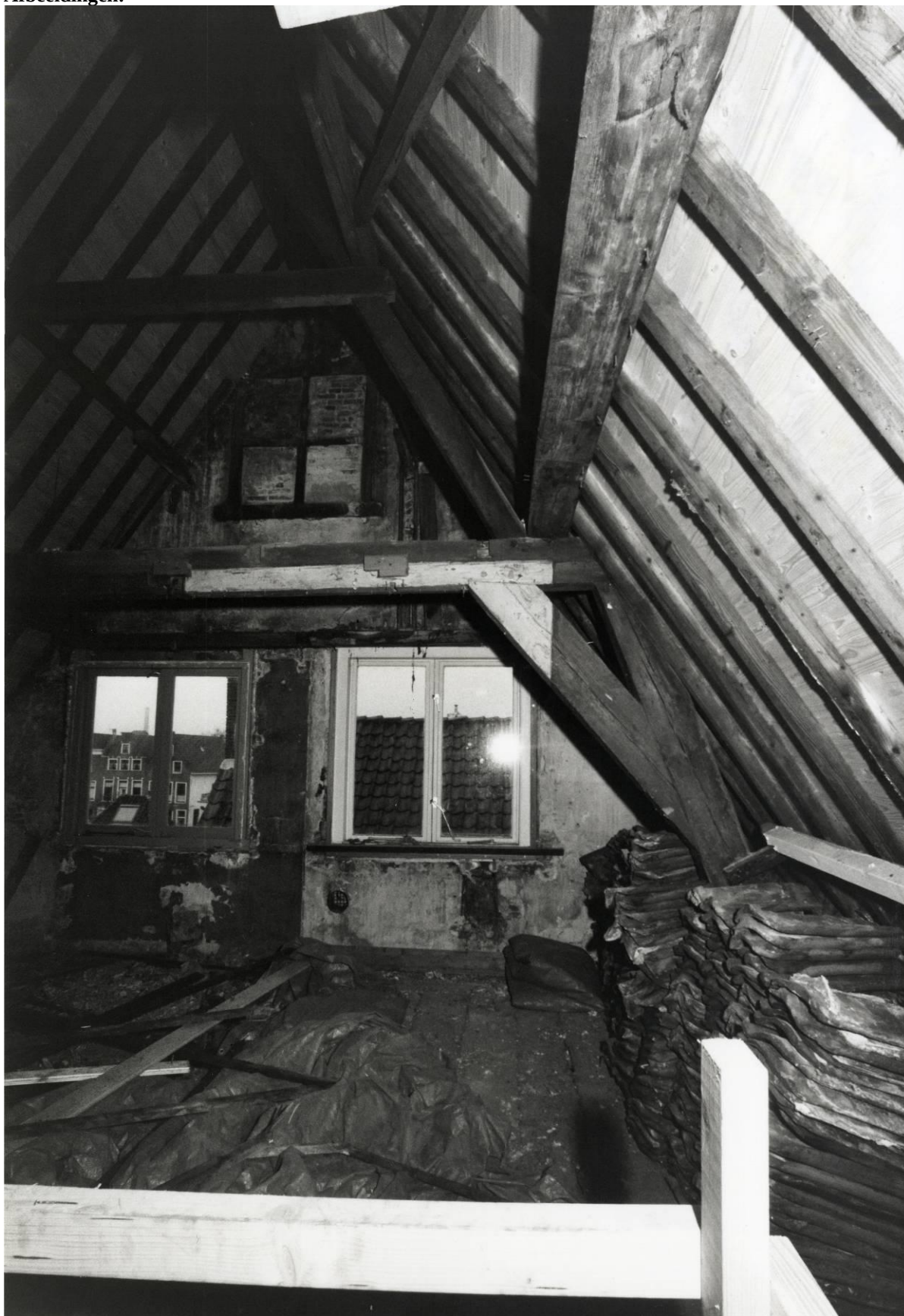
Onderste spantconstructie
