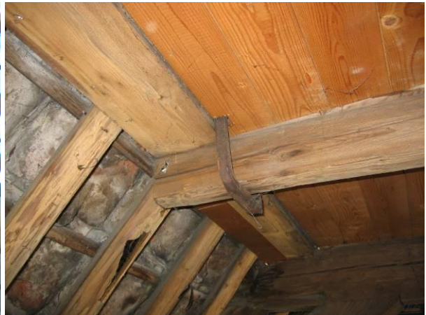
Hangbalk in smeedijzeren strop
