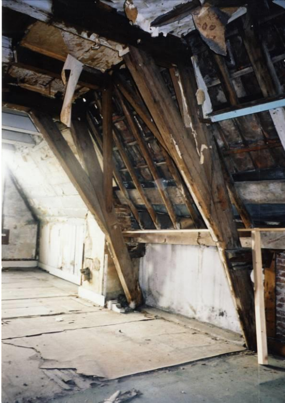
Onderste spantconstructie
