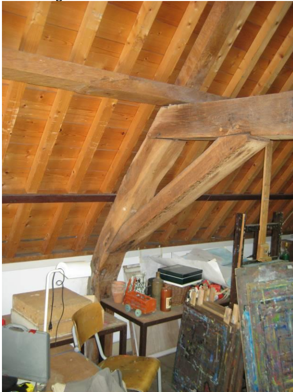
Onderste spantconstructie
