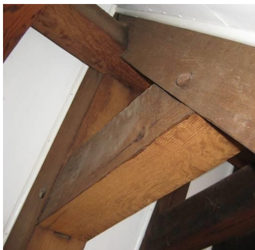
Overzicht nok constructie
