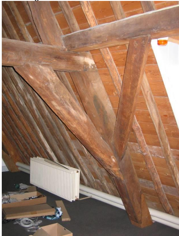
Onderste spantconstructie
