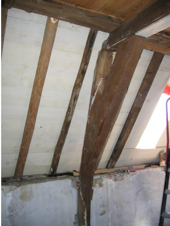
Onderste spantconstructie
