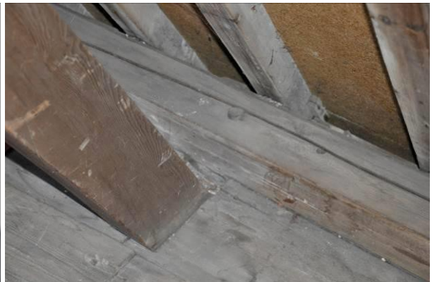
Spantbeen bovenste spant en vernagelde fliering
