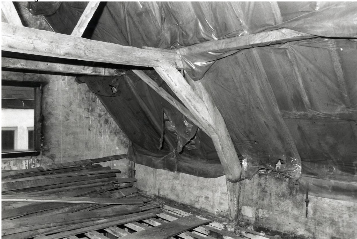
Spantconstructie
