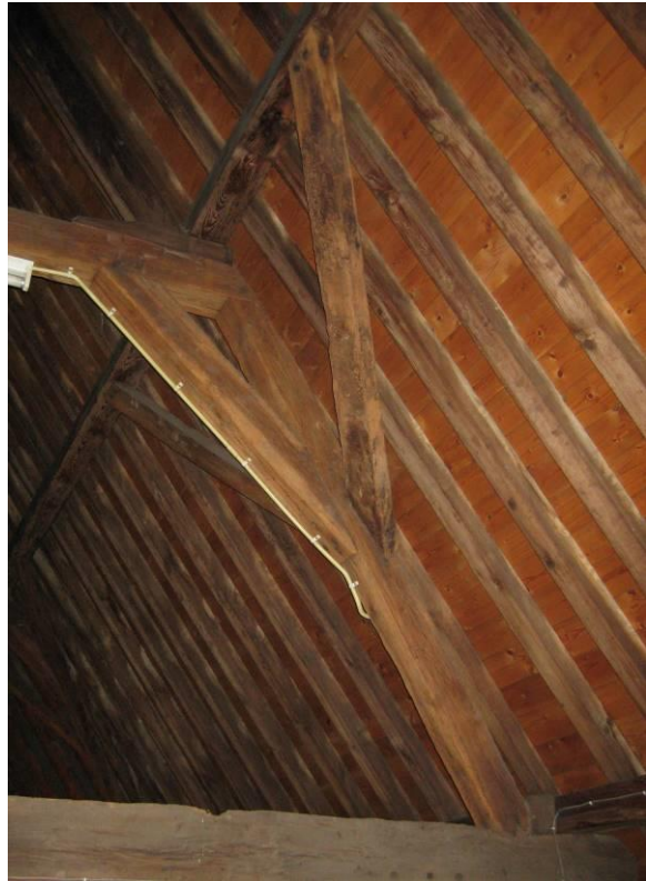
Spantconstructie bovenste spant
