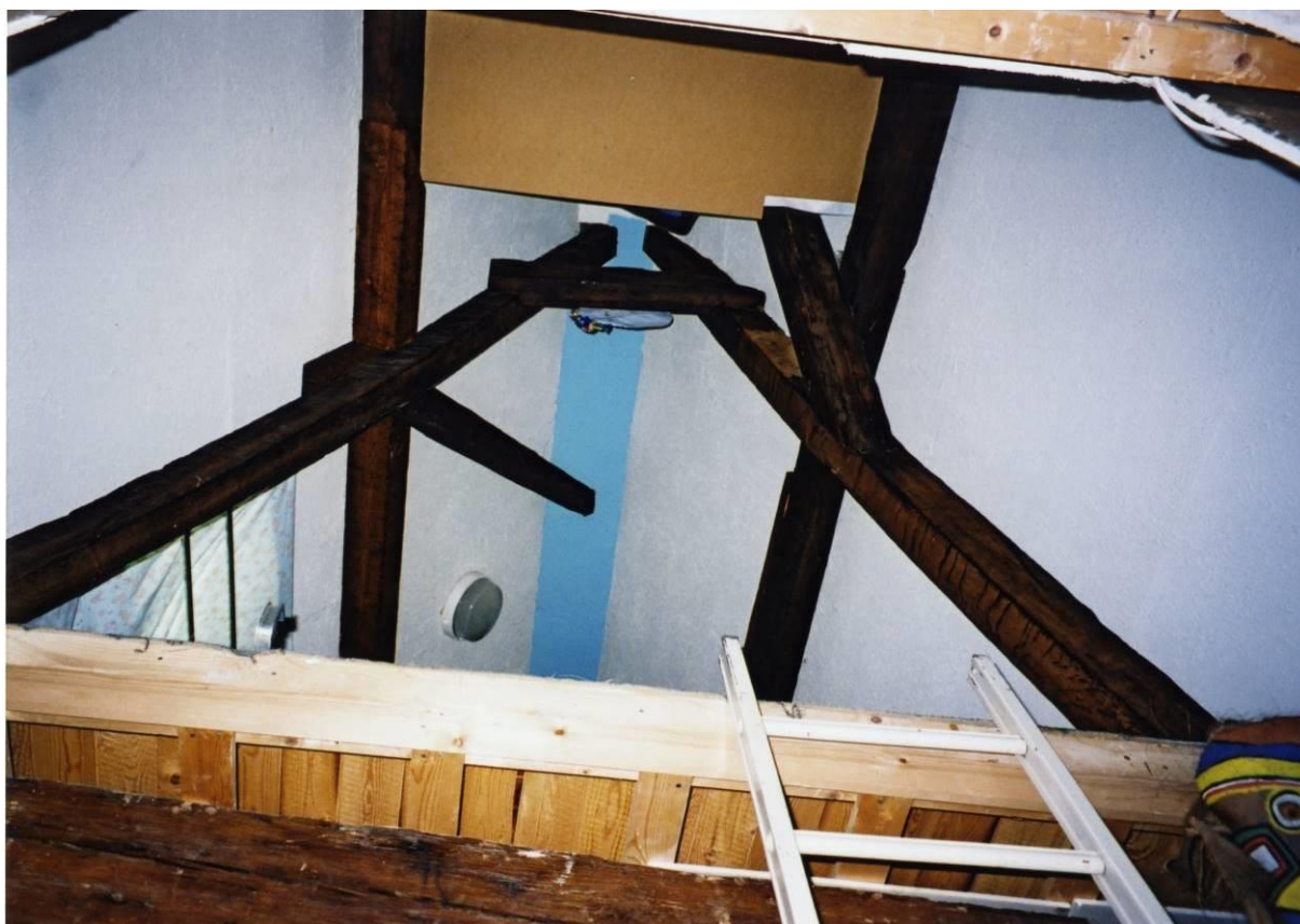
Tweede en bovenste spantconstructie
