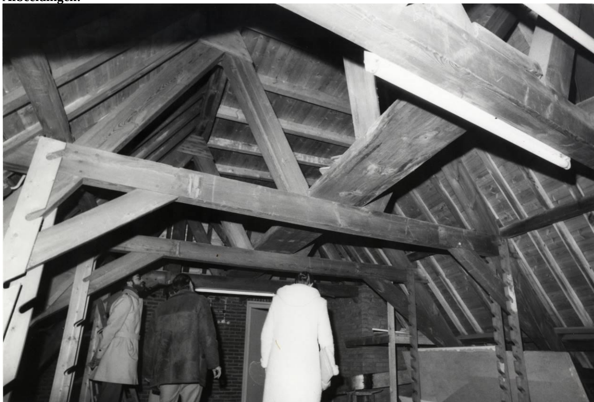
Overzicht spantconstructie
