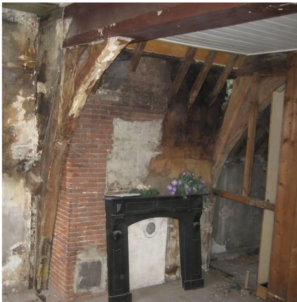
Spantconstructie onderste spant
