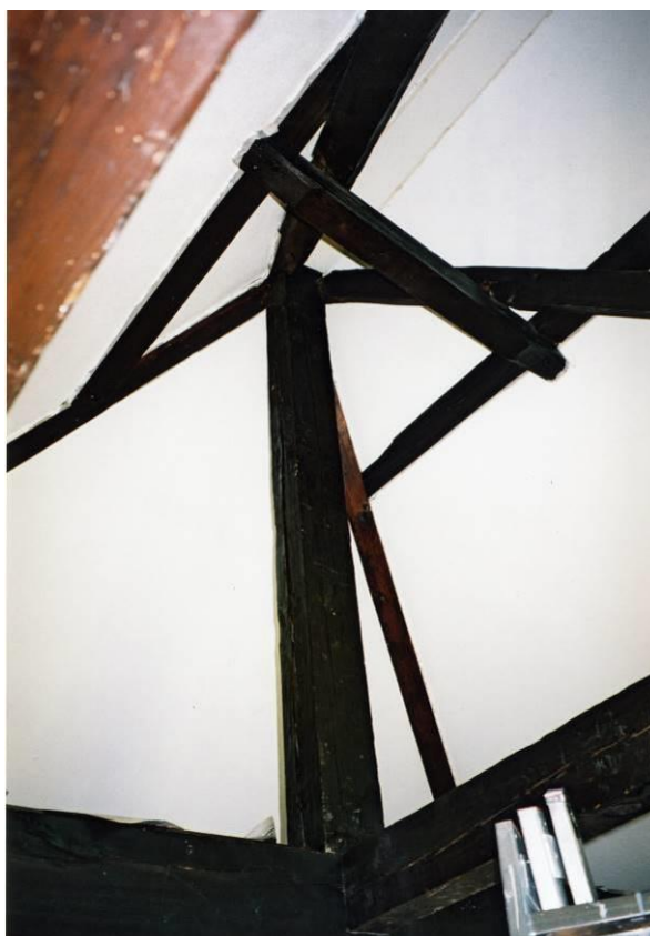
Overzicht bovenste spantconstructie
