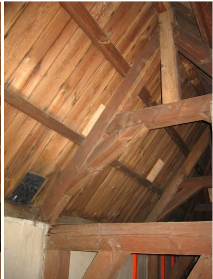
Spantconstructie met extra korbeel
