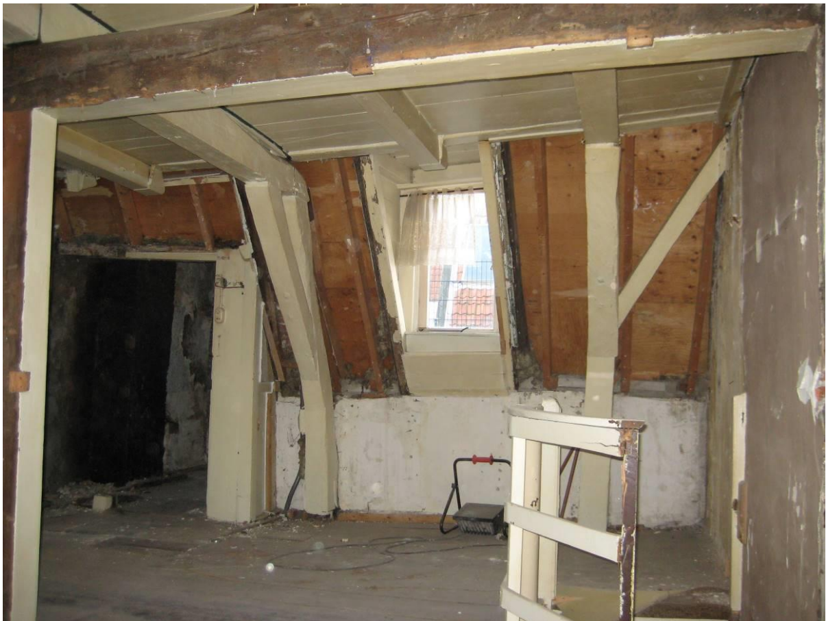
17 de -eeuwse spantconstructie met 18 de -eeuwse onderslagconstructie
