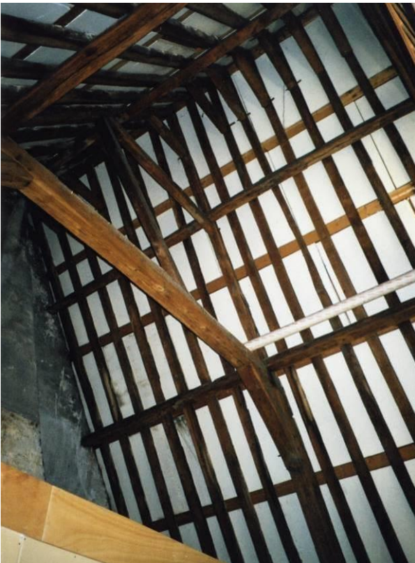
Tweede en bovenste spantconstructie
