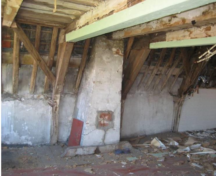
Onderste spantconstructie
