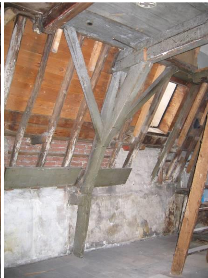
Onderste spantconstructie
