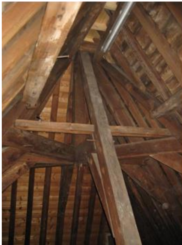
Onderste spantconstructie
