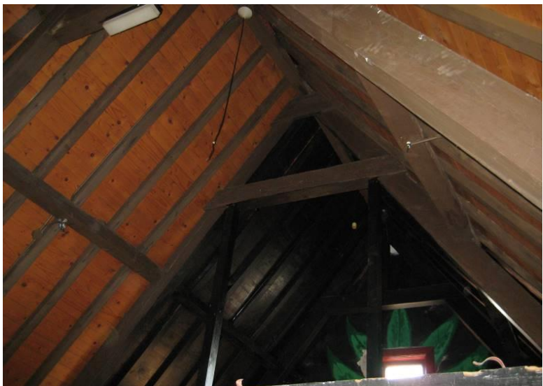
Spantconstructie bovenste spant, rechts
