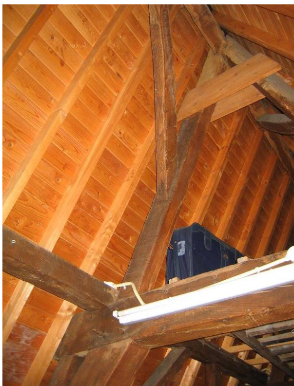
Bovenste spantconstructie
