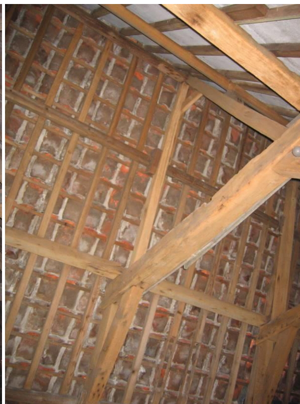
Tweede en bovenste spantconstructie
