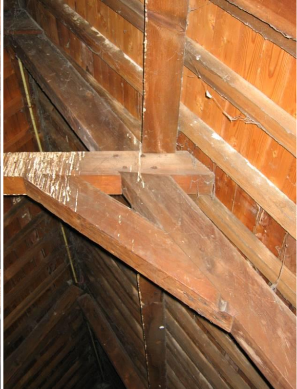
Bovenste spantconstructie met spantbeen met borst
