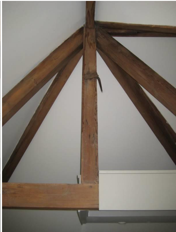
Overzicht bovenste spantconstructie met makelaar
