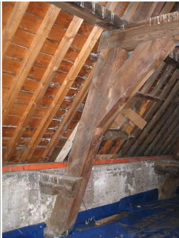
Detail onderste spantconstructie
