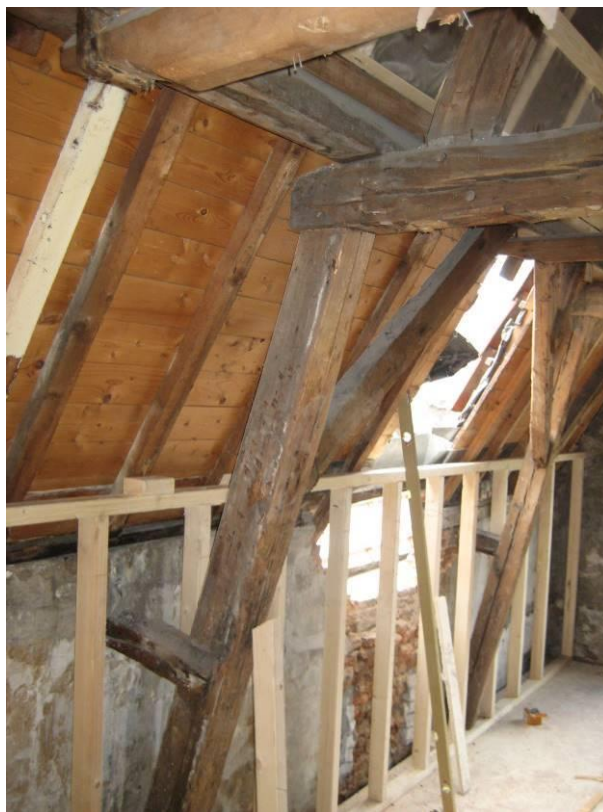
Onderste spantconstructie
