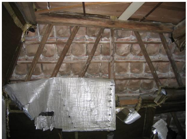
Voorste dakschild met schuin geplaatste daksporen
