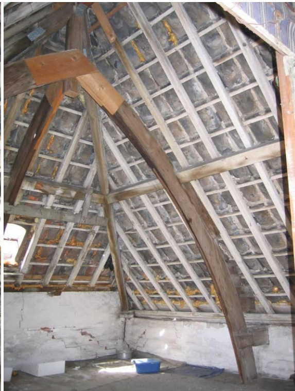
Spantconstructie
