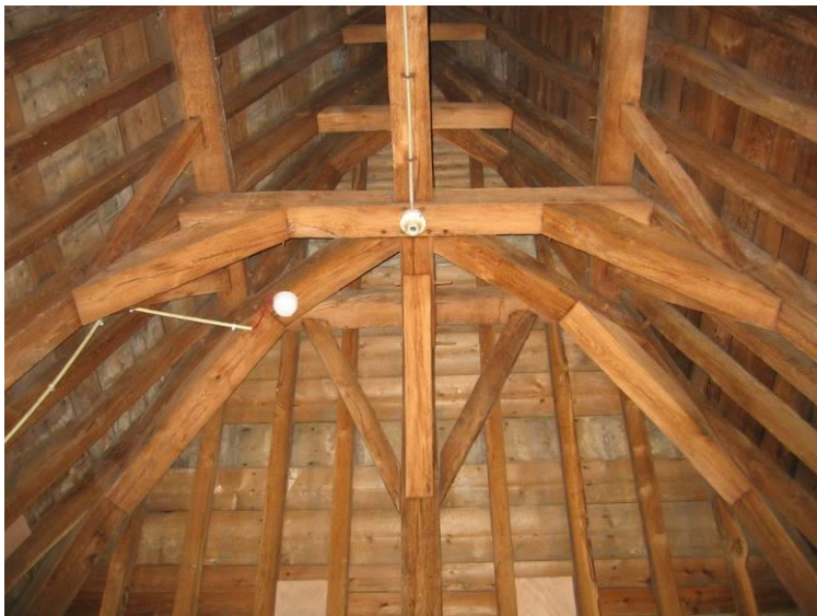
Overzicht constructie boven
