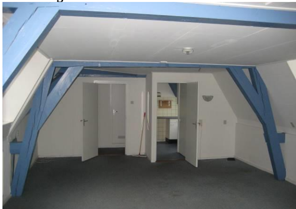
Onderste spantconstructie
