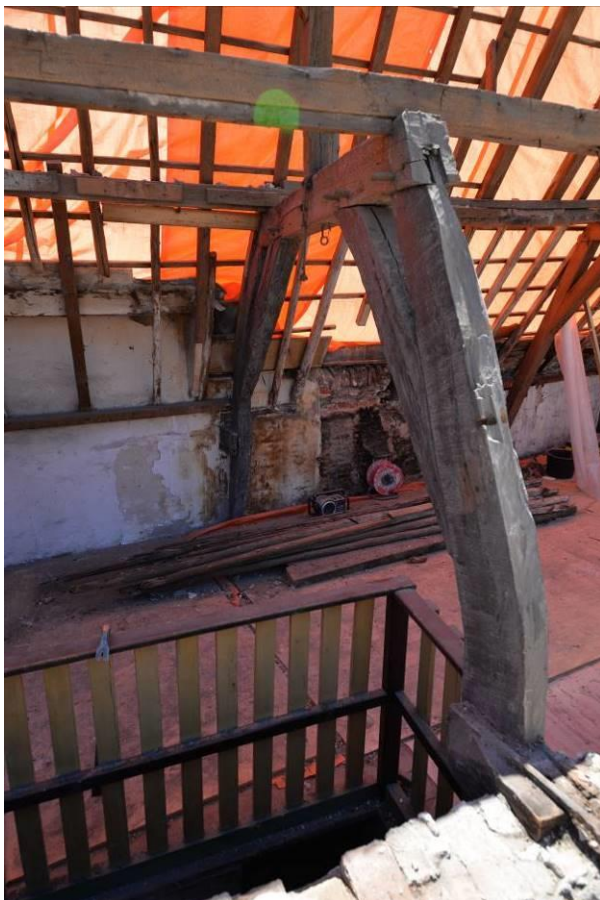
Onderste spantconstructie
