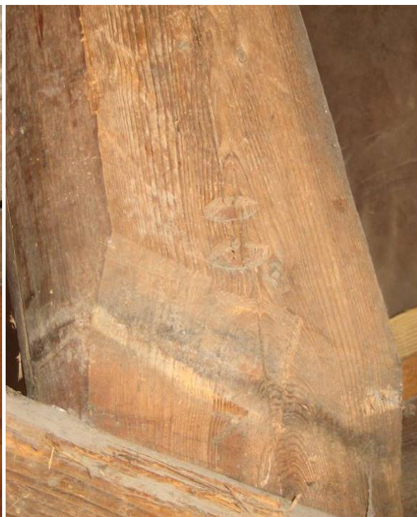
Gezaagde constructiezijde spantbeen met telmerk 00
