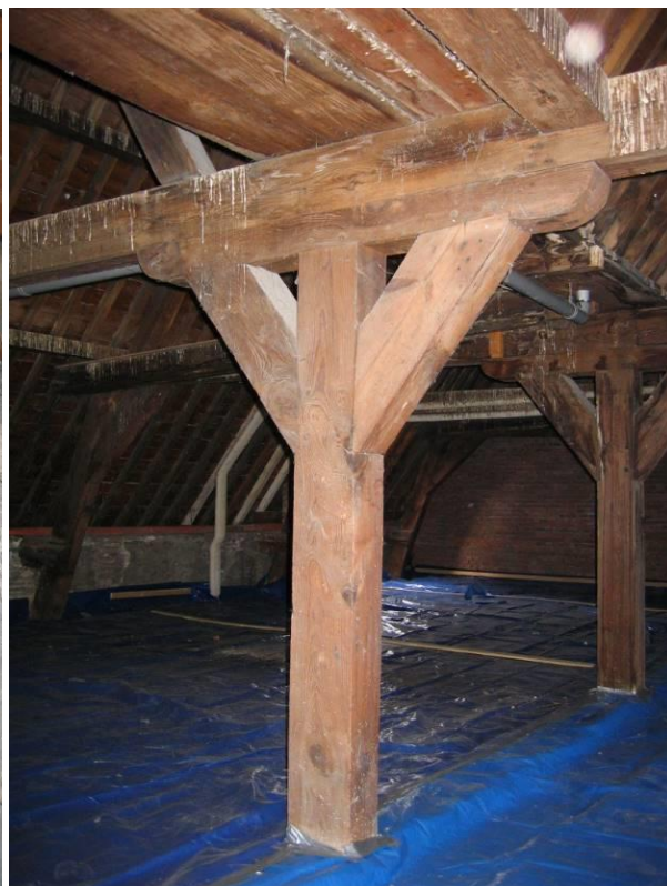
Overzicht onderslagconstructie
