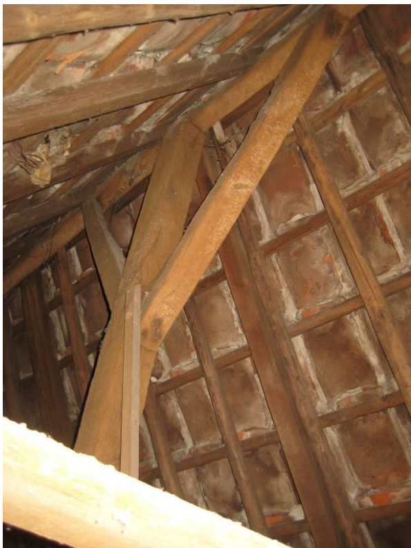
Tweede (bovenste) spantconstructie
