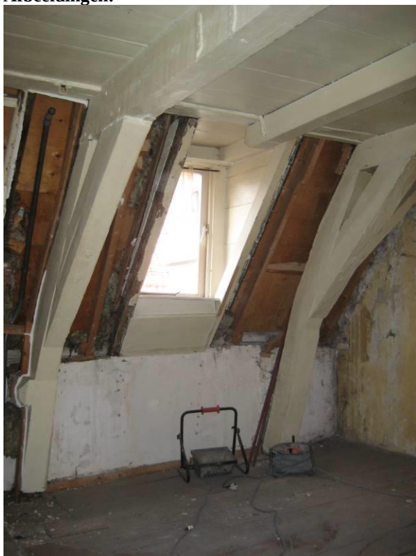
Onderste spantconstructie
