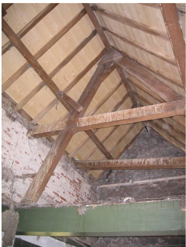
Spantconstructie voorzijde en Keulse goot
