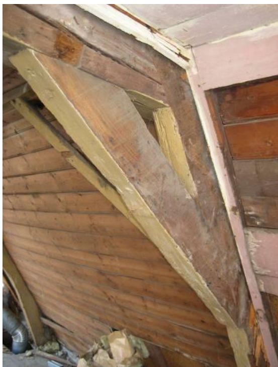
gelipt spantbeen en vernageld korbeel
