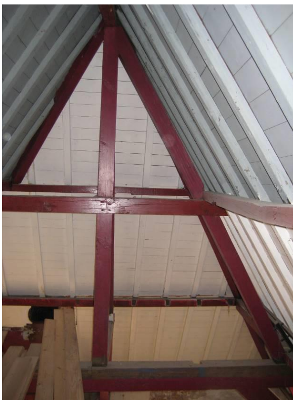
Spantconstructie bovenste spant
