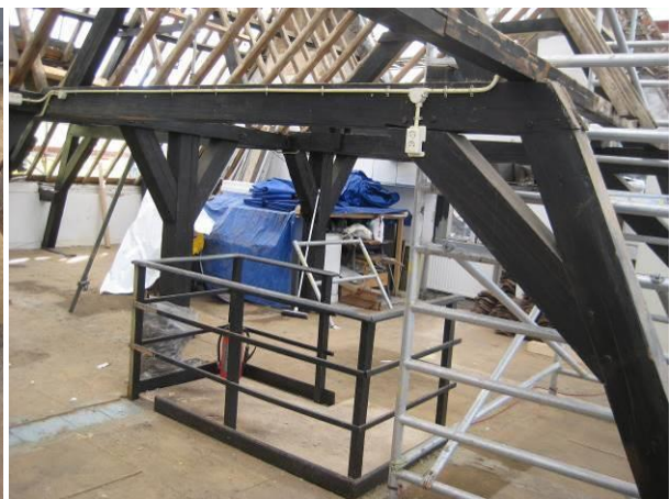
Overzicht spanten en onderslagconstructie
