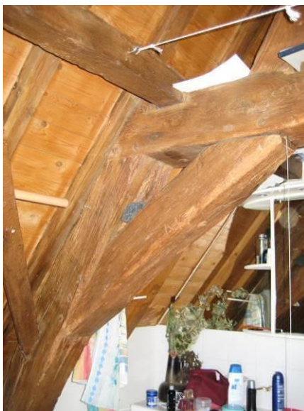
Spantconstructie
