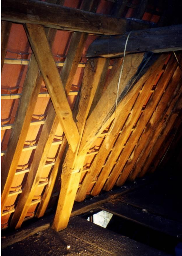
Overzicht bovenste spant
