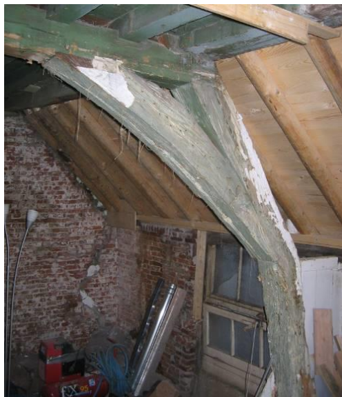
Spantconstructie
