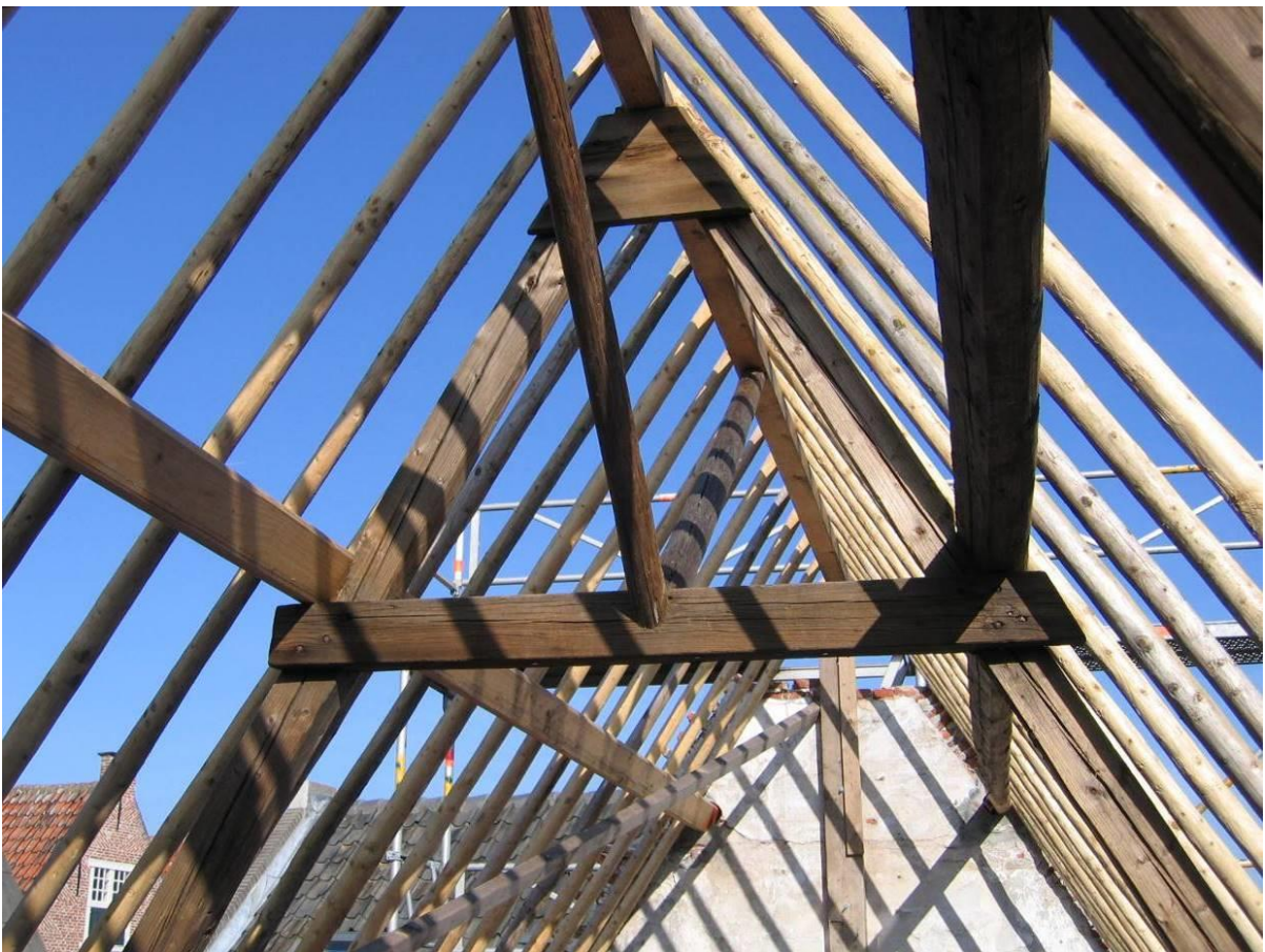
Bovenste spantconstructie
