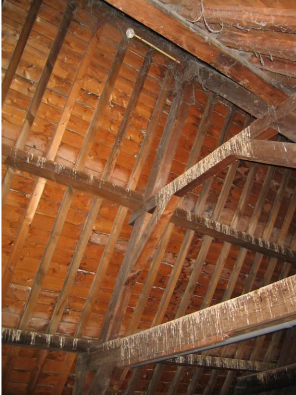
Overzicht bovenste spantconstructie
