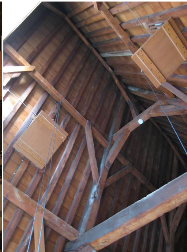
Derde (bovenste) spantconstructie
