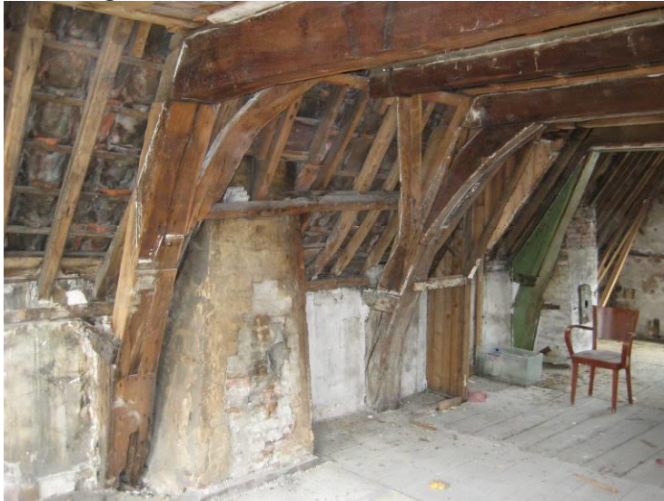
Onderste spantconstructie
