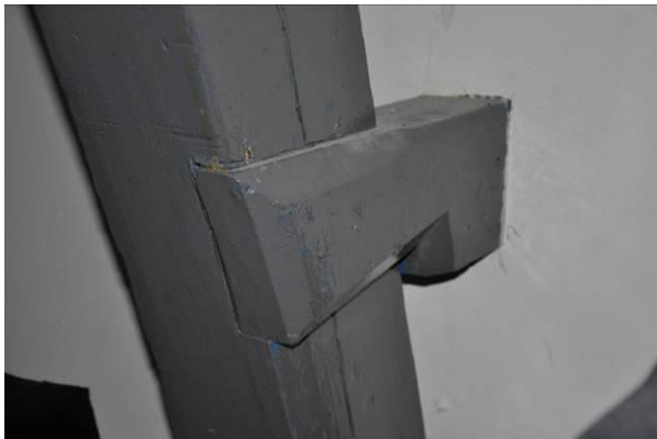
Blokkeel onderste spant
