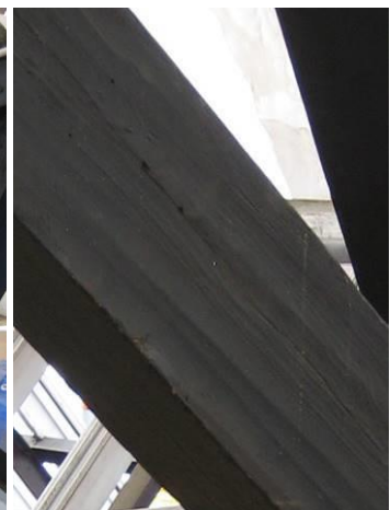
Bewerkingsporen gerfschaaf
