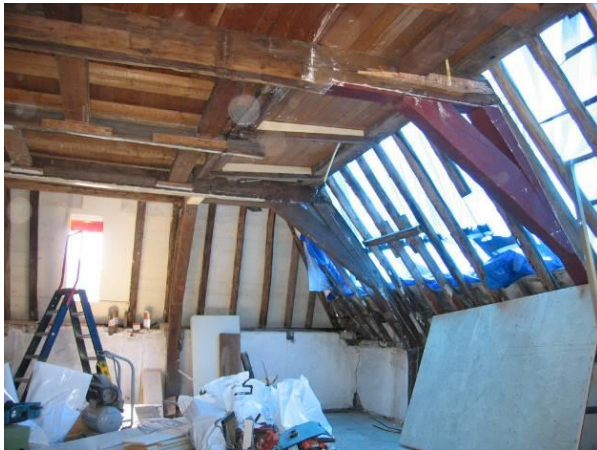
Onderste spantconstructie met zij- en voorschild
