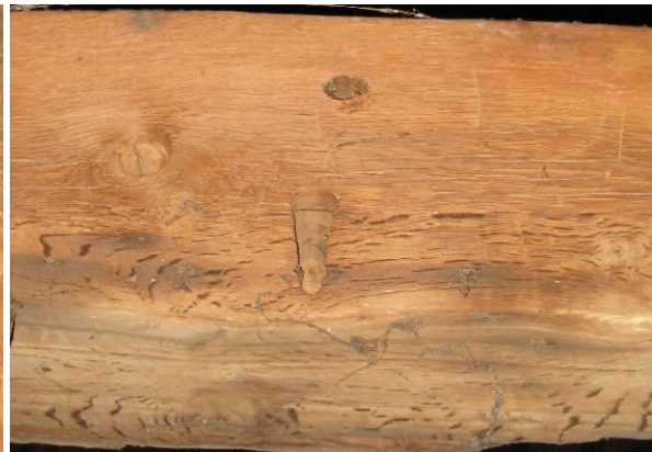
Vlotgaten in dekbalk
