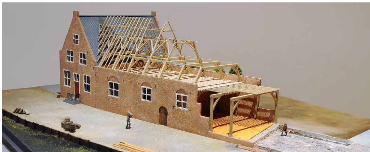
Maquette van de bouw van de midden 15 de -eeuwse Aalmarktvlleugel van het Catharinagasthuis. De maquette toont op basis van de archivalische, archeologische en bouwhistorische gegevens de verschillende bouwstadia, van de aanvoer van het materiaal tot het complete gebouw. 52
