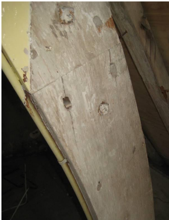
Verbinding met bouten en houten deuvels
