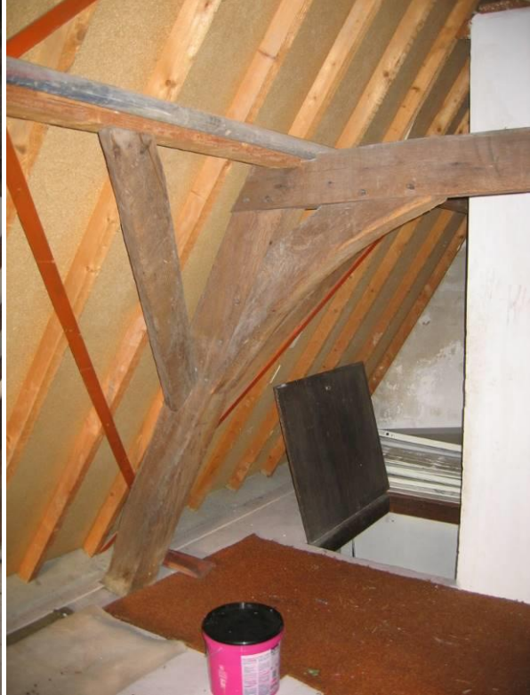
Spantconstructie bovenste spant
