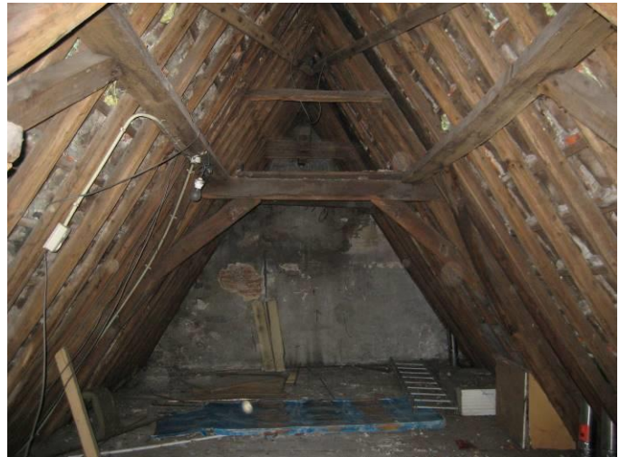
Overzicht bovenste spant
