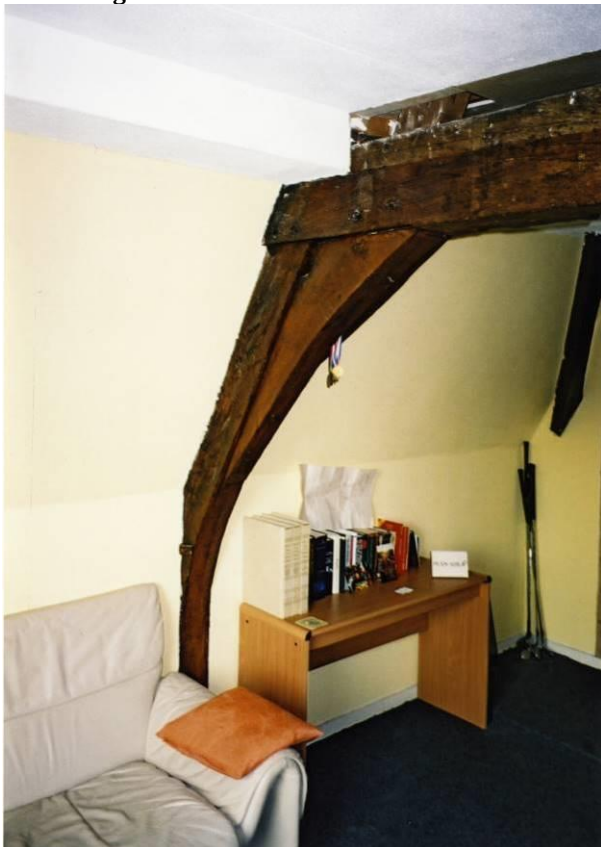
Onderste spantconstructie
