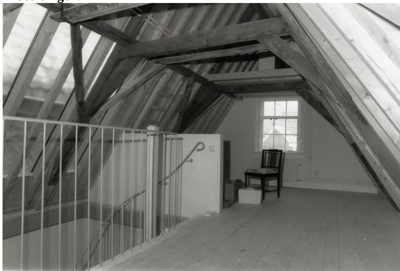
Overzicht spantconstructie
