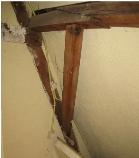
Bovenste spantconstructie
