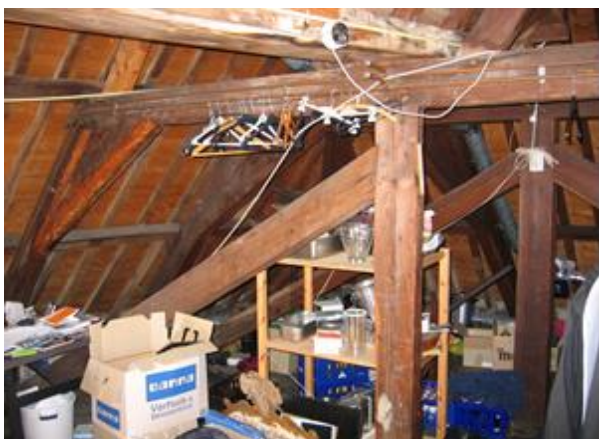
Overzicht onderste spantconstructie met hangwerk
