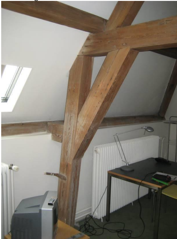
Overzicht onderste spantconstructie, voor
