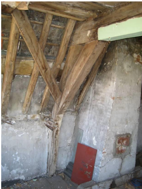
Onderste spantconstructie
