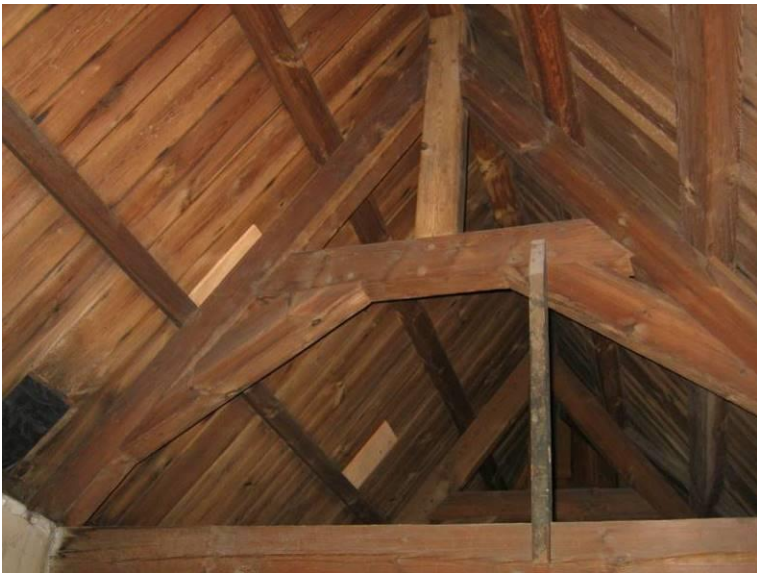
Overzicht spantconstructie met extra korbeels
