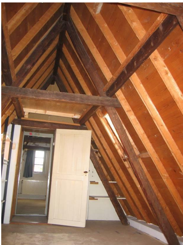
Bovenste spantconstructie
