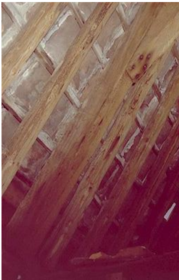
Sporen en bovenste spantconstructie
