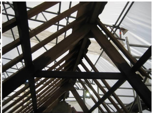
Spantconstructie bovenste spant achterzijde
