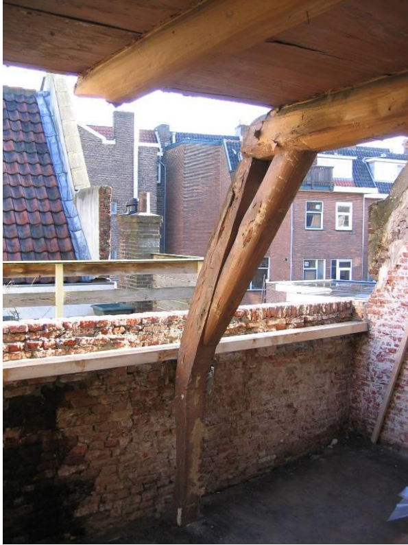
Onderste spantconstructie
