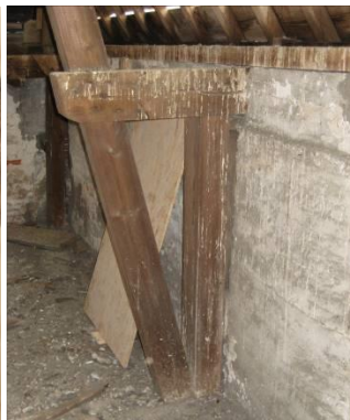
Borstwering met spant- en houtconstructie
