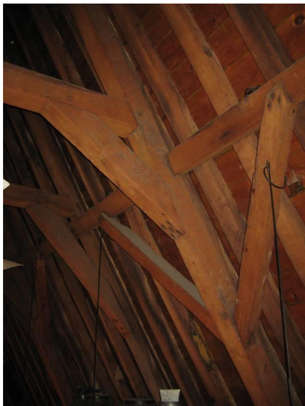
Derde (bovenste) spantconstructie
