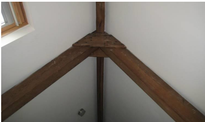
Overzicht bovenste spantconstructie
