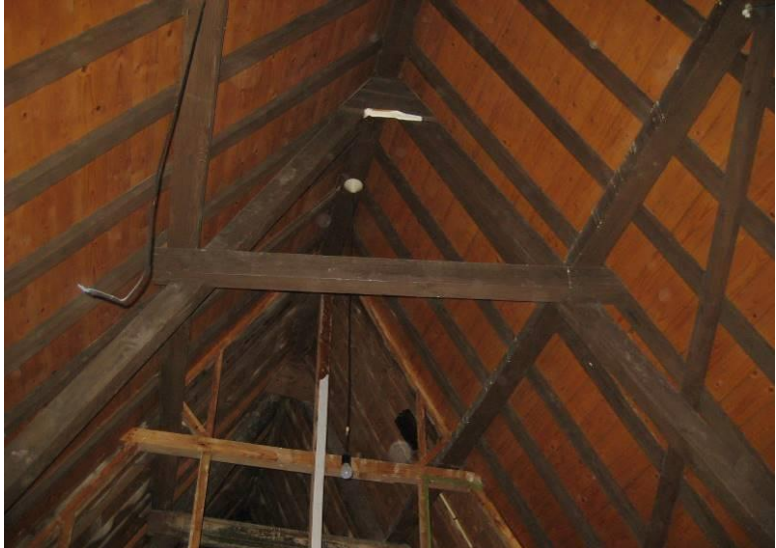
Spantconstructie bovenste spant, links
