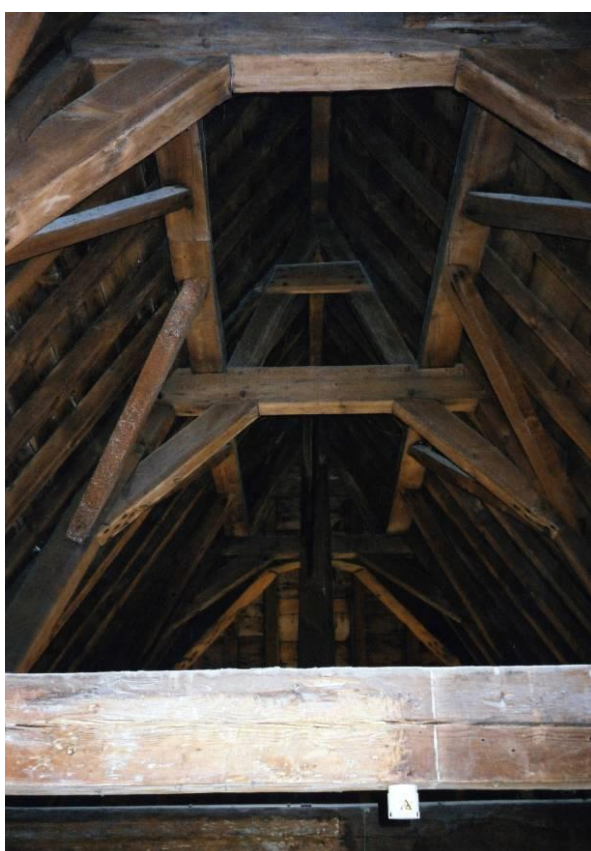
Bovenste spantconstructie
