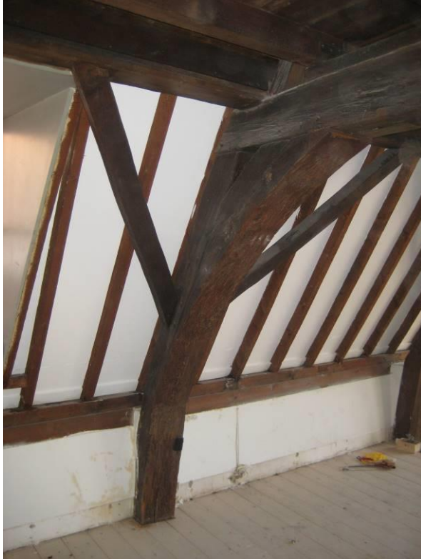
Spantconstructie onderste spant
