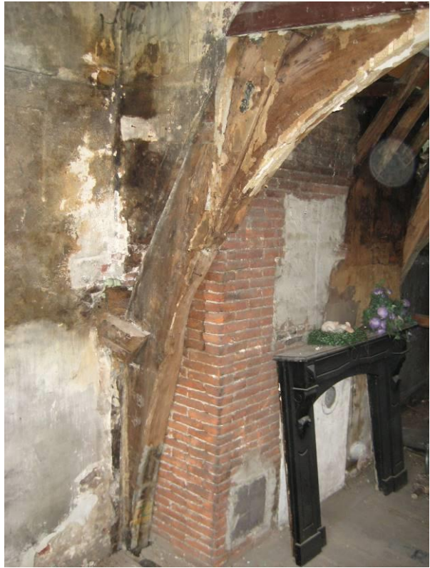
Spantconstructie onderste spant
