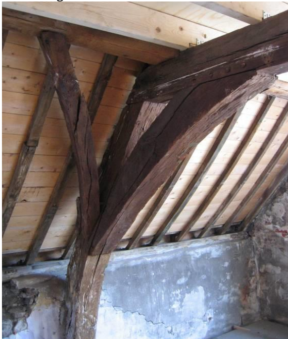
Constructie onderste spant
