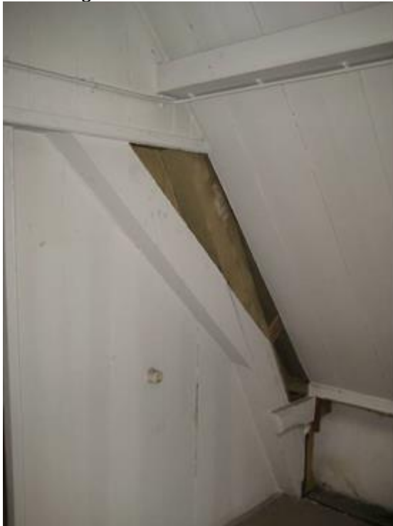
Onderste spantconstructie
