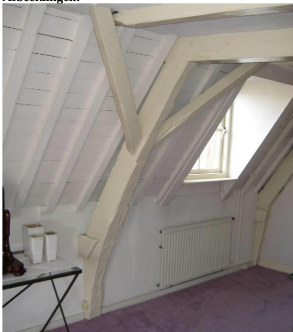
Onderste spantconstructie
