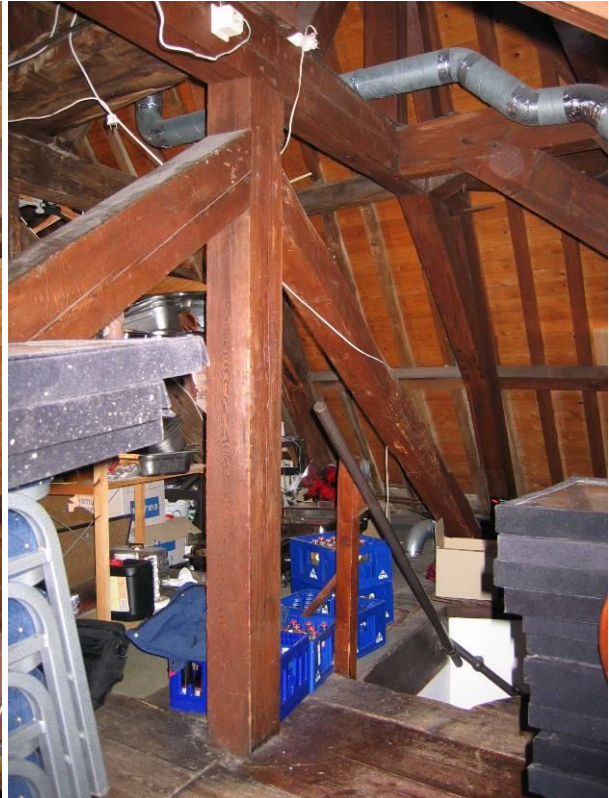
Overzicht onderste spantconstructie met hangwerk
