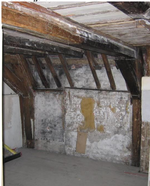
Spantconstructie
