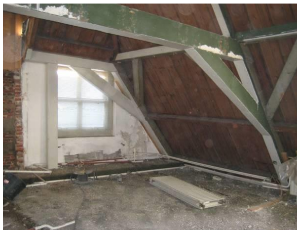
Overzicht onderste spantconstructie achter
