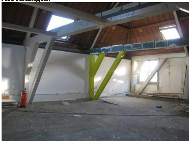
Overzicht onderste spantconstructie voor
