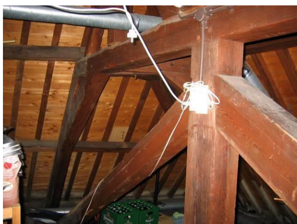
Overzicht onderste spantconstructie met hangwerk
