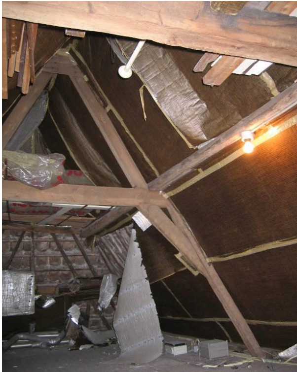
Tweede en bovenste spantconstructie
