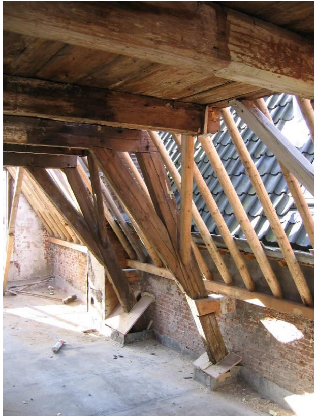
Onderste spantconstructie
