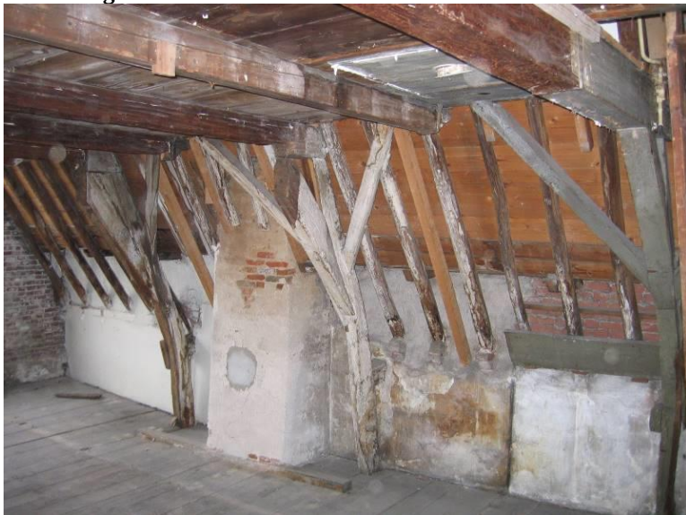
Onderste spantconstructie
