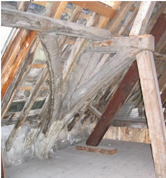
Constructie onderste spant
