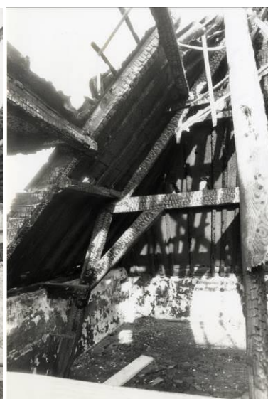
Overzicht halfspant na brand
