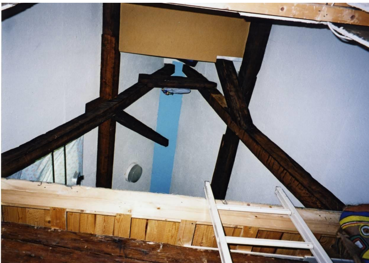
Tweede en bovenste spantconstructie
