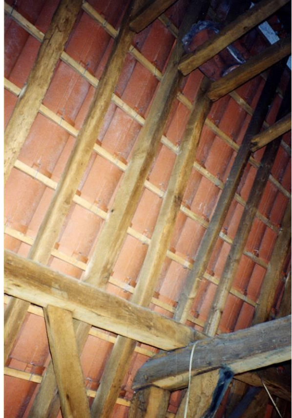
Bovenste spant en sporen
