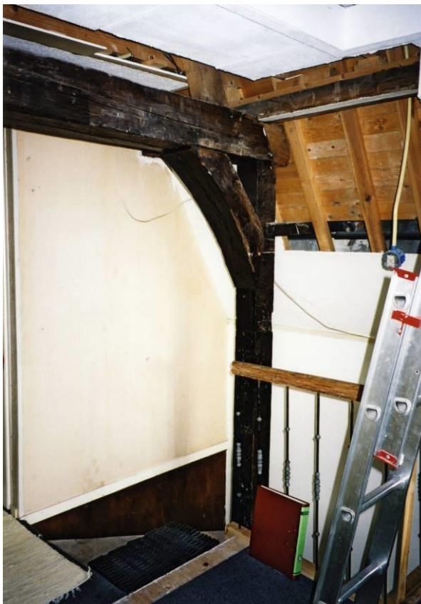
Onderste spantconstructie met verticale stijl/trapspil
