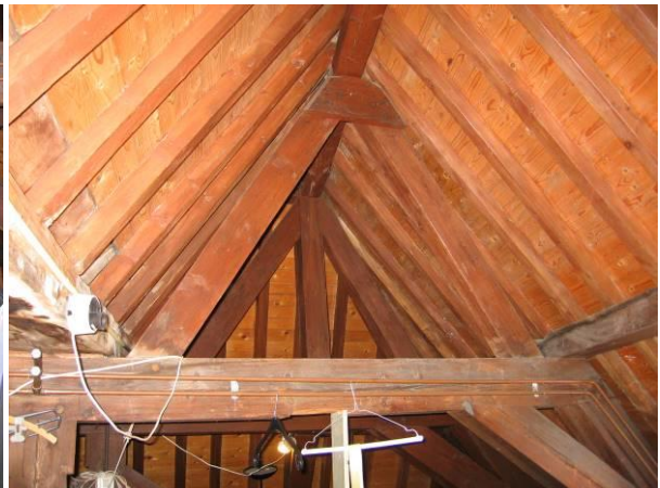
Overzicht bovenste spantconstructie
