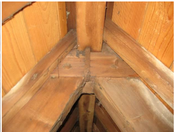
Nok met blok, ingelaten nokgording en gesmeed anker
