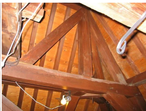
Overzicht bovenste spant met variant met makelaar
