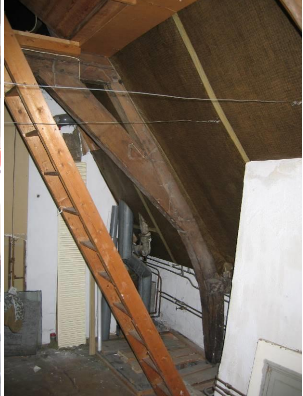
Onderste spantconstructie
