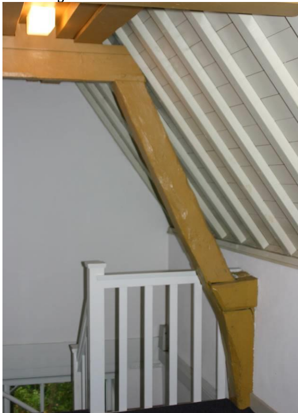
Onderste spantconstructie
