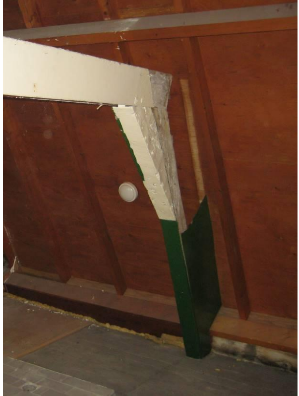
Bovenste spantconstructie met vernieuwde dekbalk
