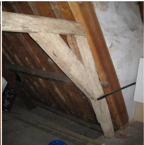
Spantconstructie bovenste spant
