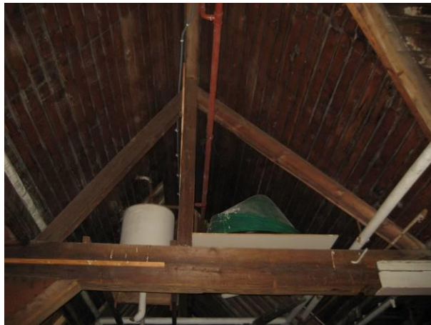
Overzicht bovenste spantconstructie
