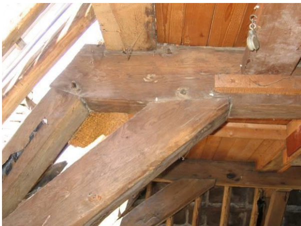
Onderste dekbalk met schuine aansluiting op spantbeen
