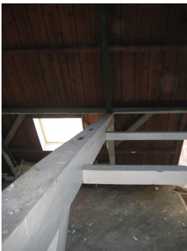
Pengaten van spantbenen nokspanten in dekbalk
