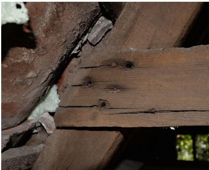
Spantbalk met voorgeboorde nagelgaten
