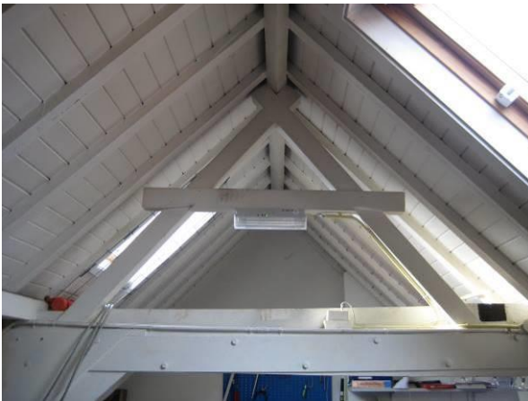
Spantconstructie bovenste spant
