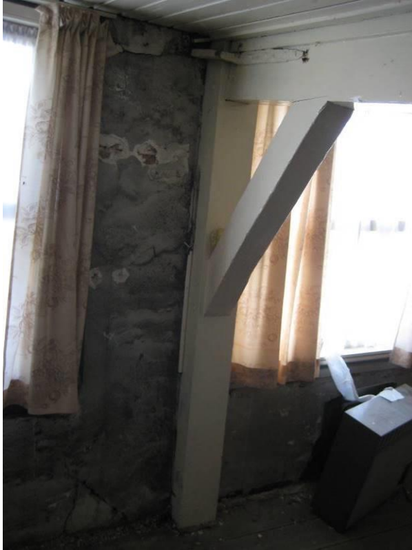
Overzicht houtconstructie tegen voorgevel
