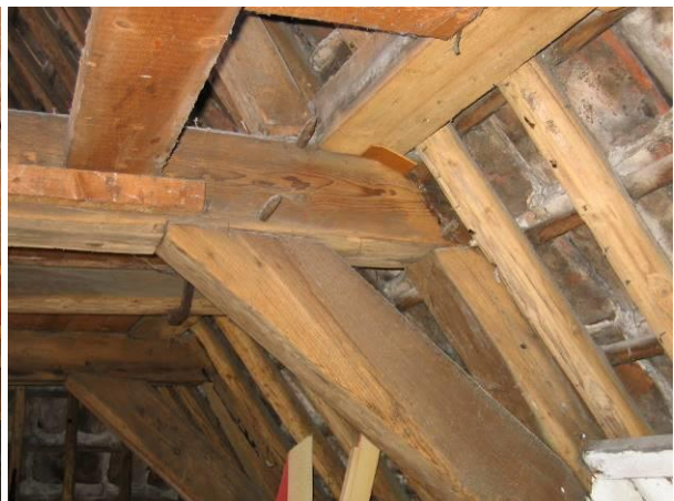
Zelfde dekbalk met vlakke aansluiting op spantbeen
