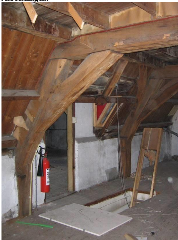
Spantconstructie onderste spant
