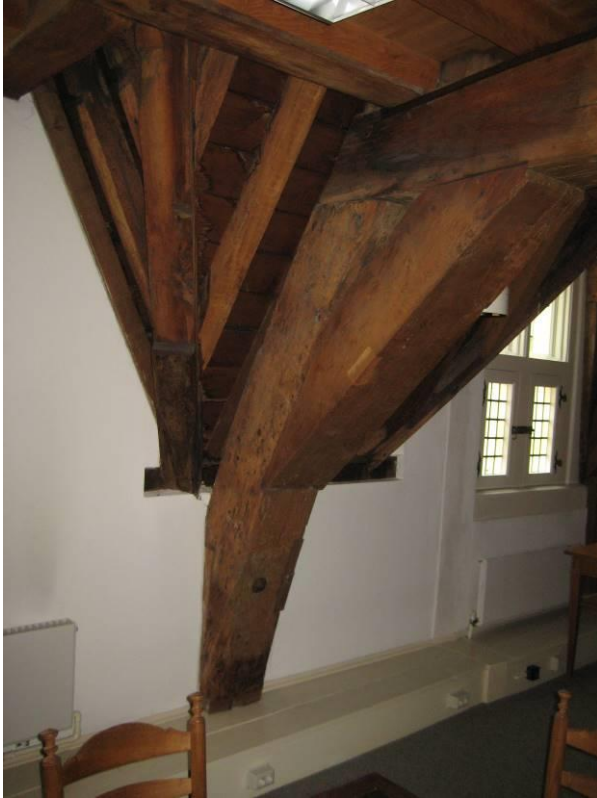
Onderste spantconstructie
