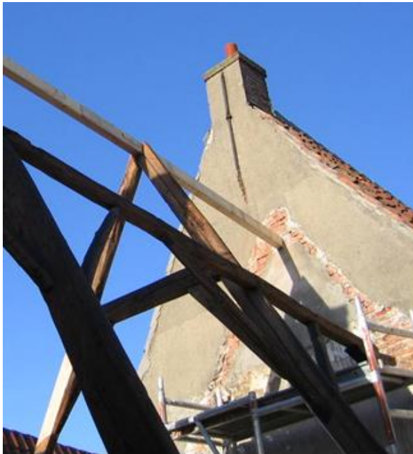
Bovenste spantconstructie
