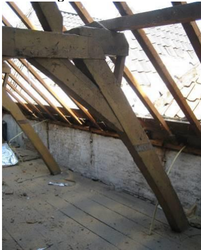
Onderste spantconstructie
