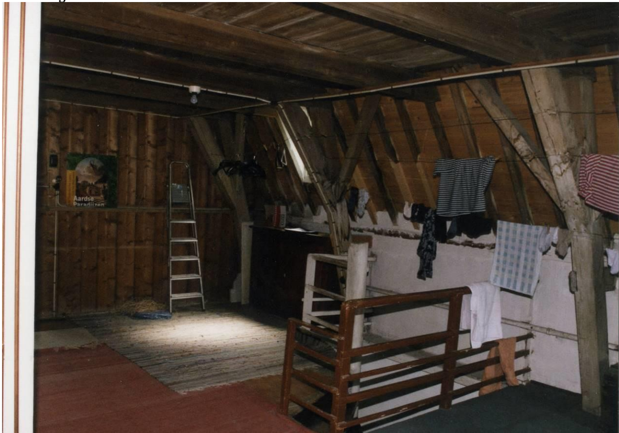
Onderste spantconstructie (M. Enderman)
