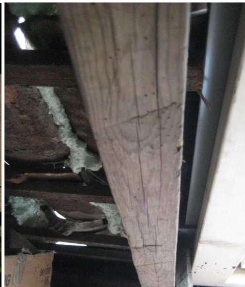
Spantbeen met haksporen
