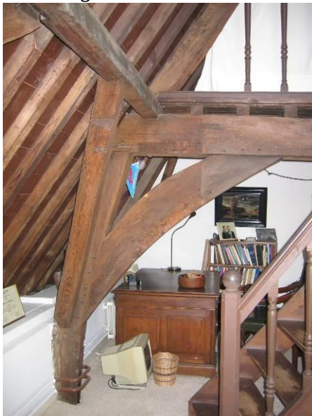
Constructie onderste spant
