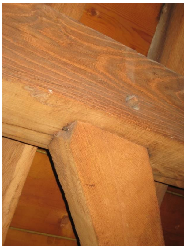
Tweede spantconstructie, windschoor gepend in fliering
