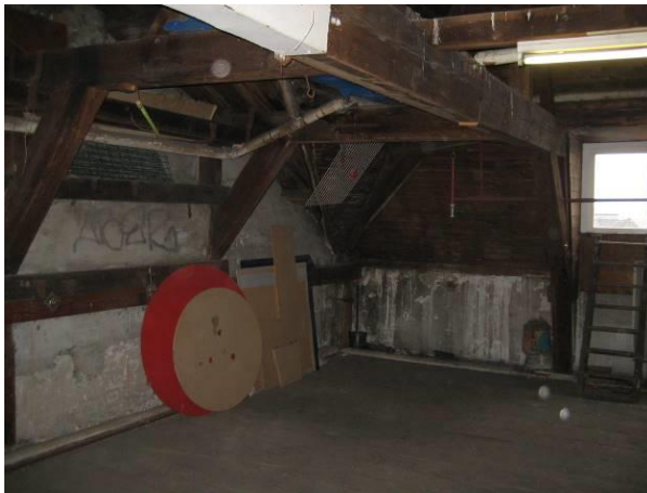
Overzicht halfspanten langs voorgevel
