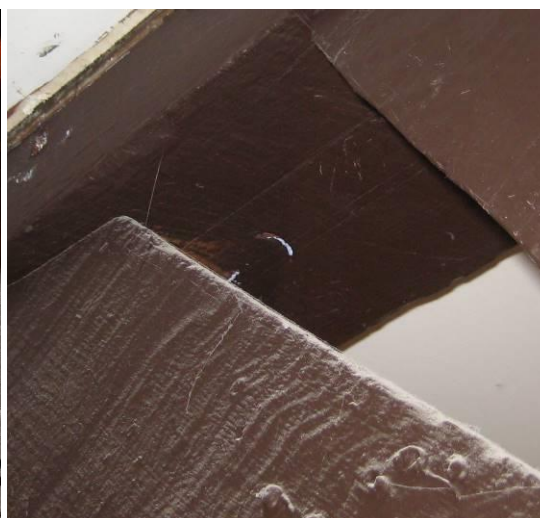
Spant met telmerk ), zaagsporen en aftekenlijnen
