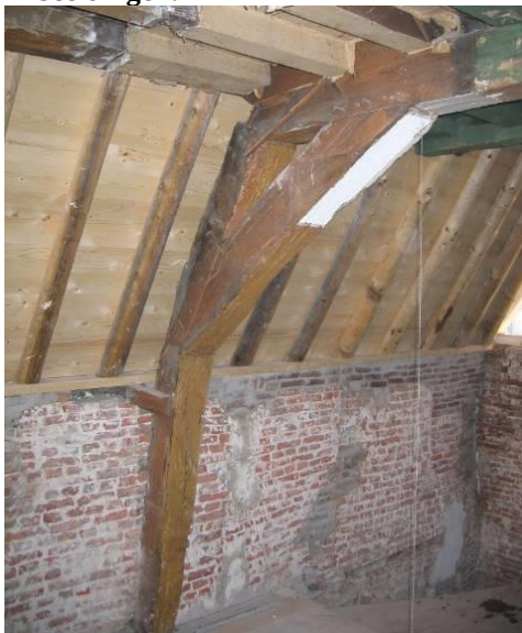
Spantconstructie
