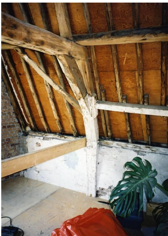
Onderste spantconstructie
