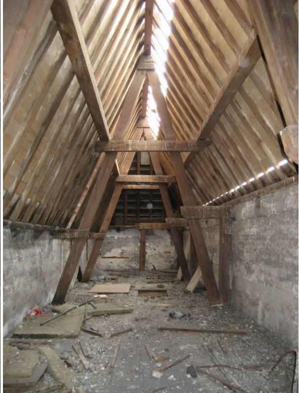
Overzicht spantconstructie
