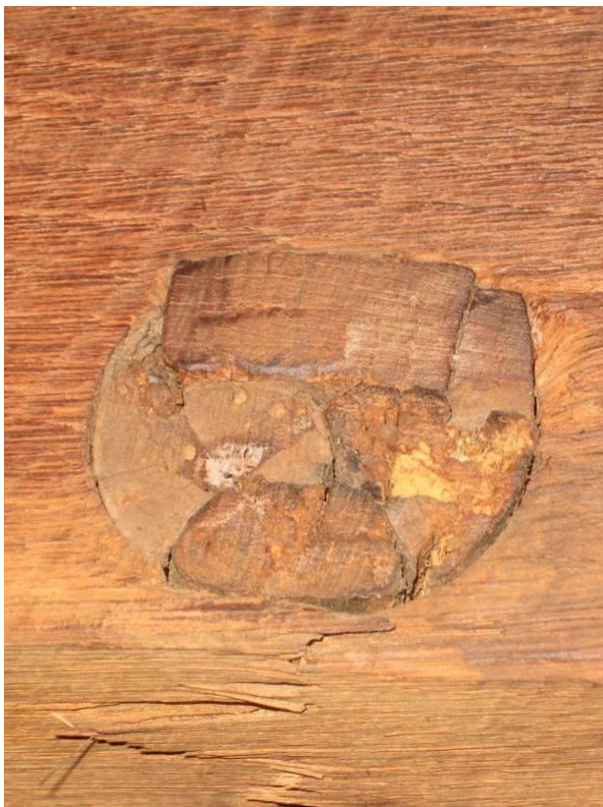
Vlotgat met plug in dekbalk
