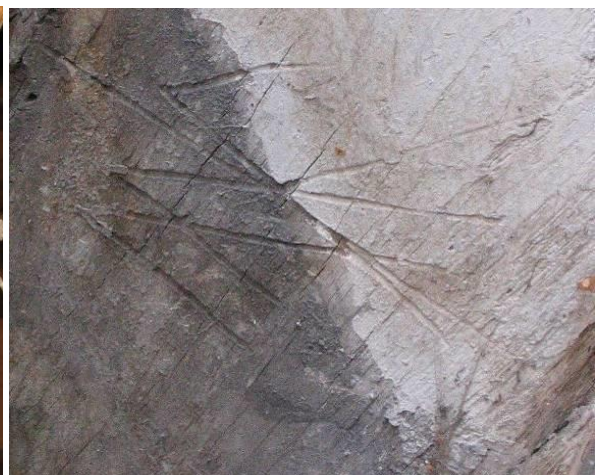
Doorgehaald 'handels'-merk op spantbeen
