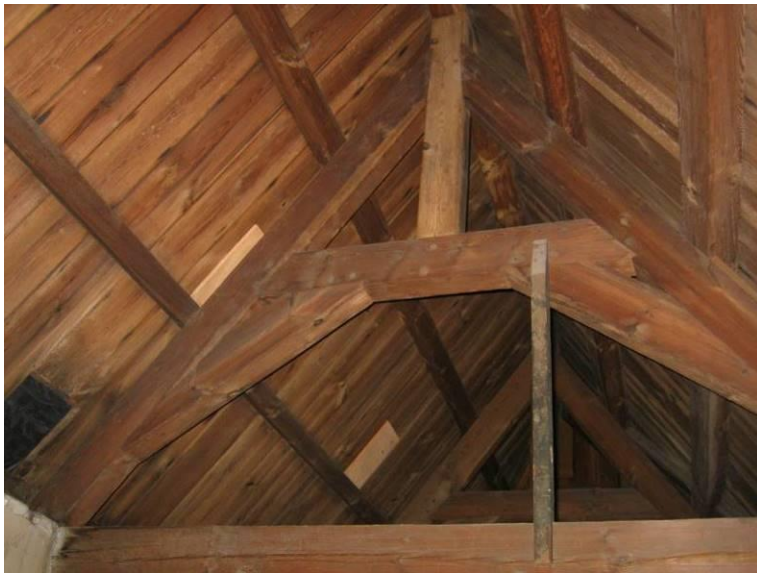
Overzicht spantconstructie met extra korbeels
