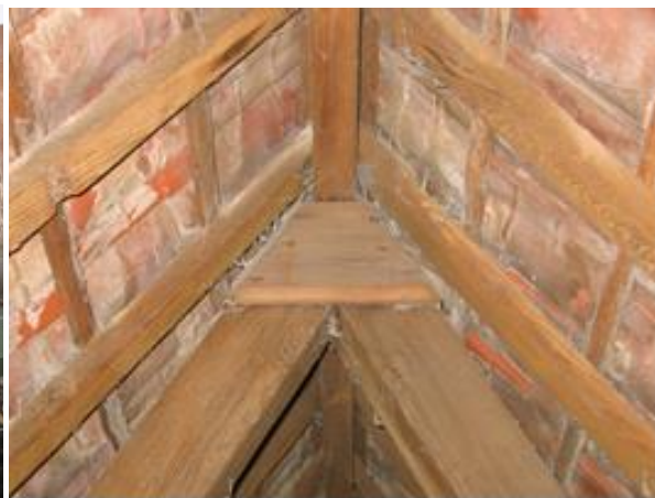
Nokconstructie met schetsplaat
