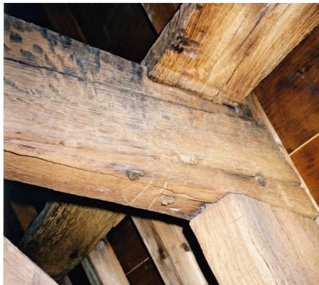
Bovenste spant, telmerk II met visje
