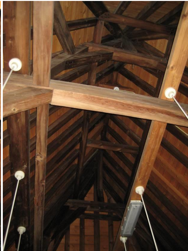
Bovenste spantconstructie
