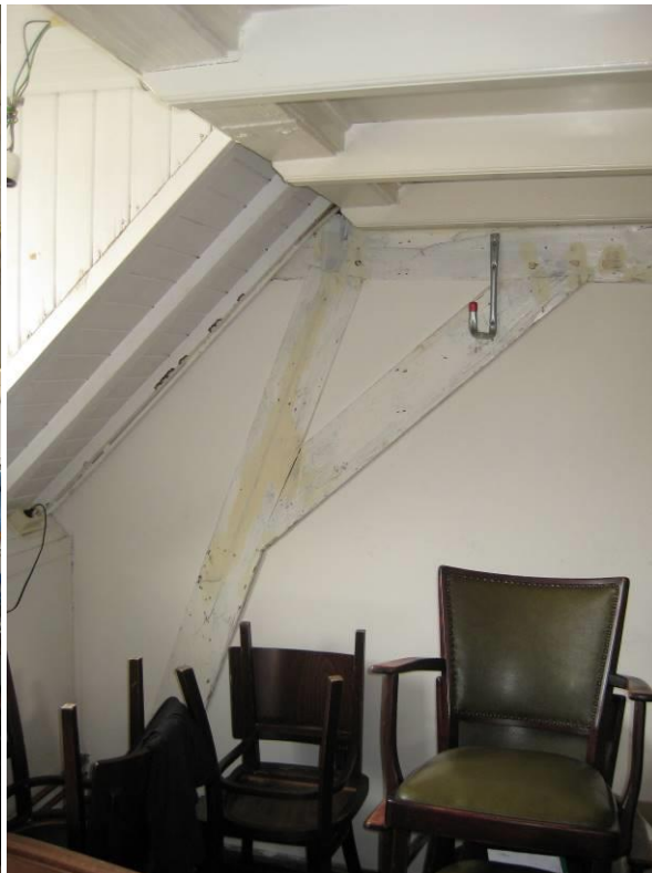
Spantconstructie onderste spant
