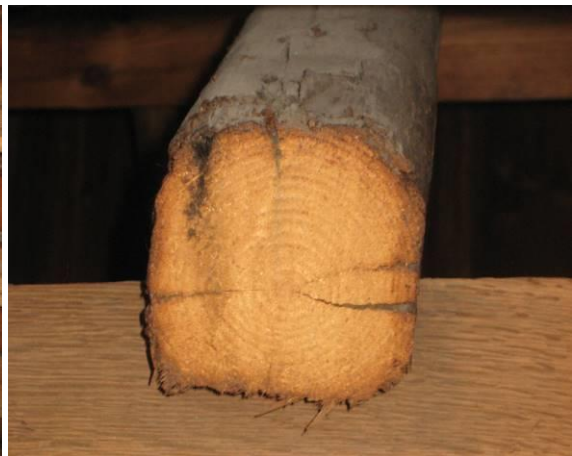
Doorsnede vuren spoor met jaarringen
