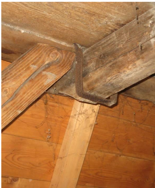
Hangbalk in ijzeren strop
