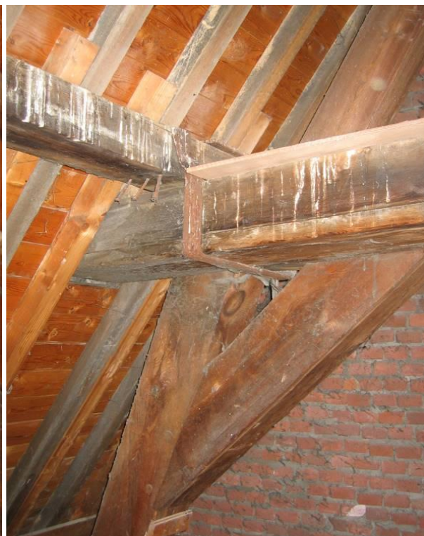
Keulse goot parallel aan spant
