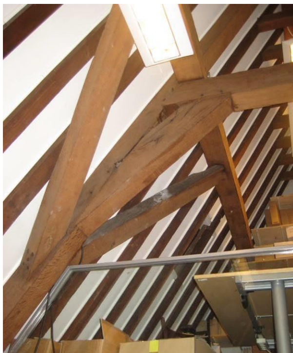
Overzicht constructie boven
