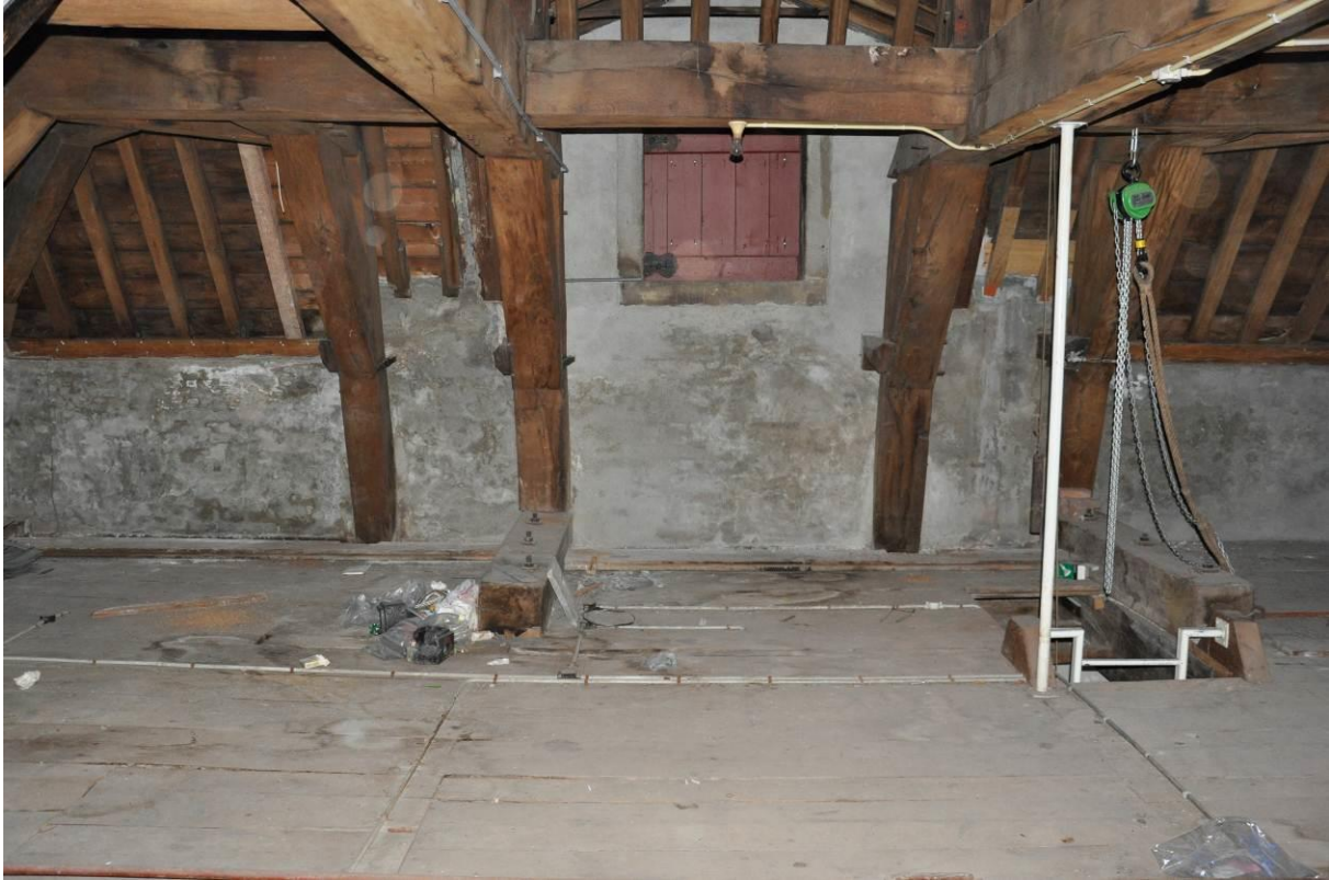
Overzicht onderste spantconstructie
