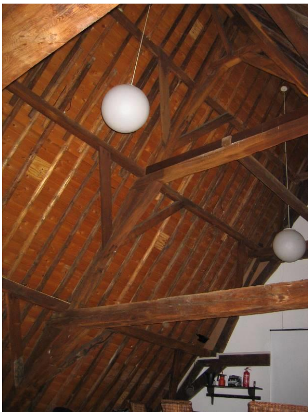
Tweede en derde (bovenste) spantconstructie
