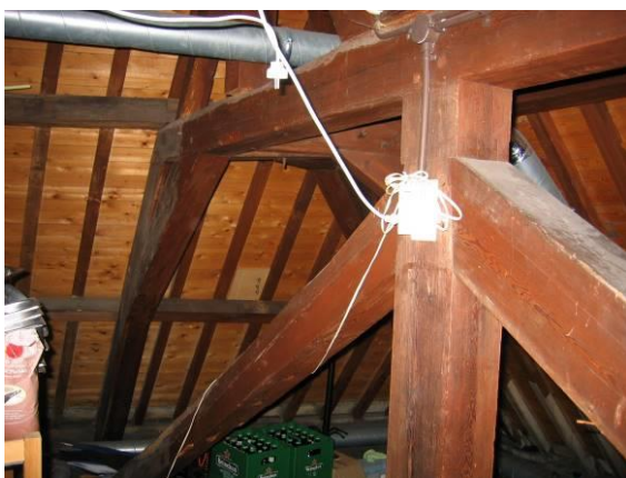
Overzicht onderste spantconstructie met hangwerk
