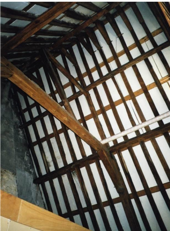
Tweede en bovenste spantconstructie
