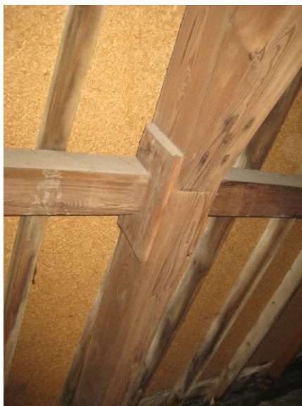
Spantbeen met gording en schetsplaat
