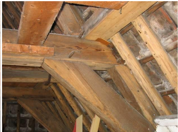
Zelfde dekbalk met vlakke aansluiting op spantbeen
