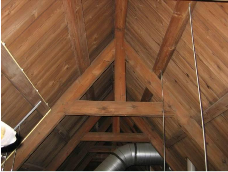
Overzicht spantconstructie
