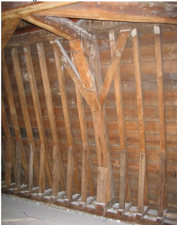
Overzicht constructie onder
