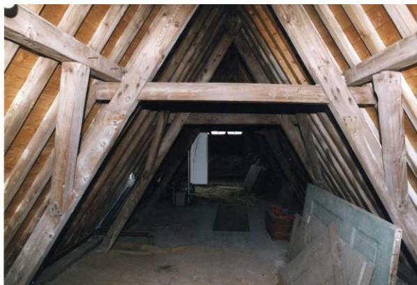
Bovenste spantconstructie
