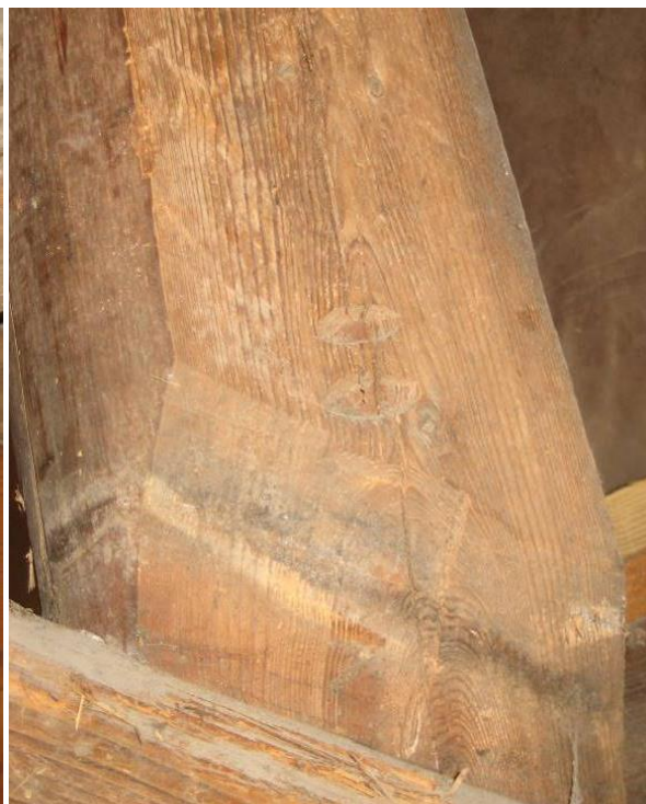
Gezaagde constructiezijde spantbeen met telmerk 00
