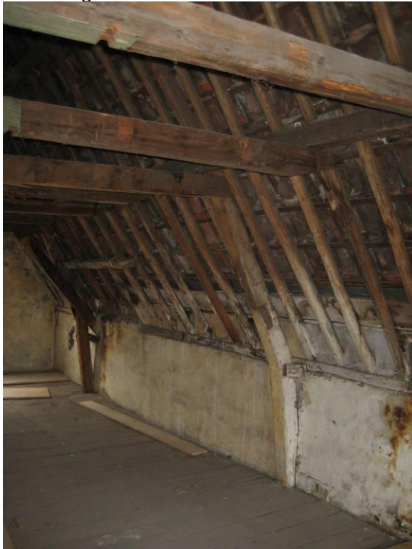
Dekbalkspantconstructie Oude Singel 116
