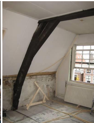
Onderste spantconstructie
