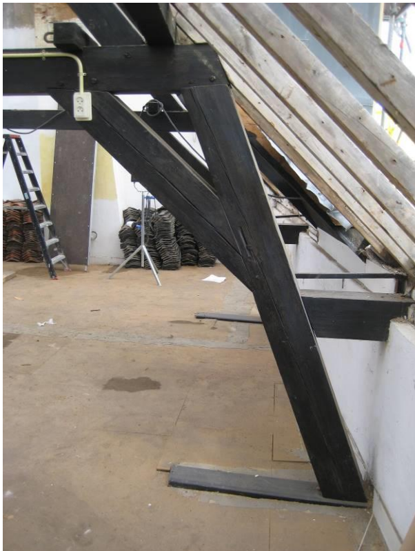
Spantconstructie onderste spant, voorgevel
