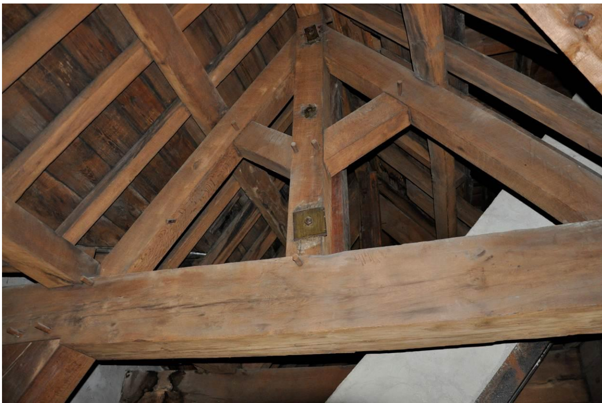
Overzicht bovenste spantconstructie
