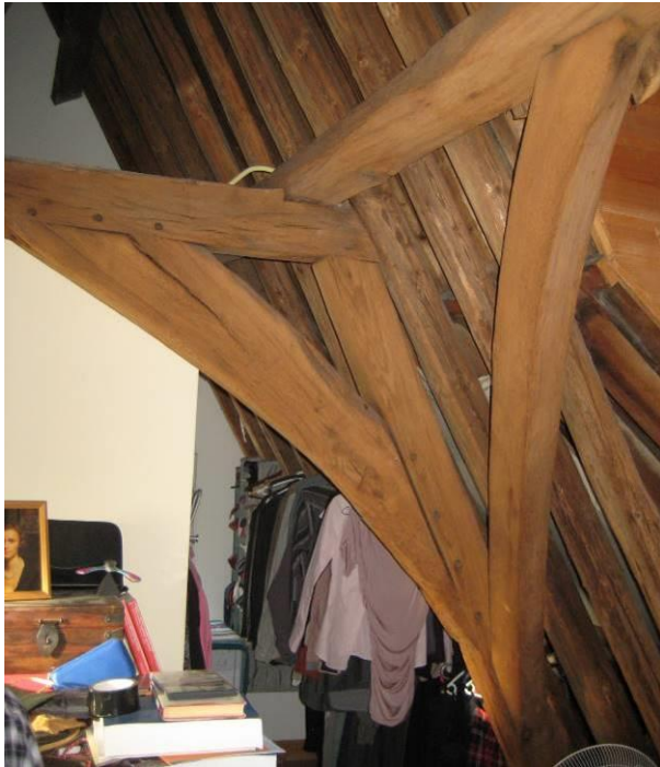
Constructie bovenste spant
