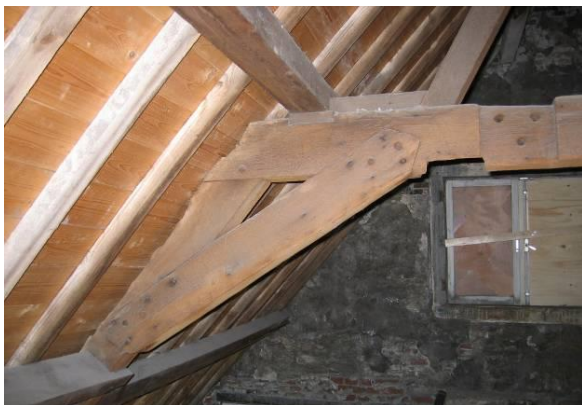
Constructie bovenste spant
