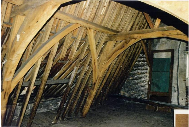
Constructie bovenste spant
