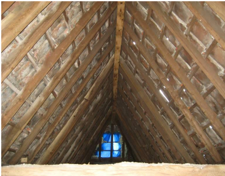
Bovenste spantconstructie
