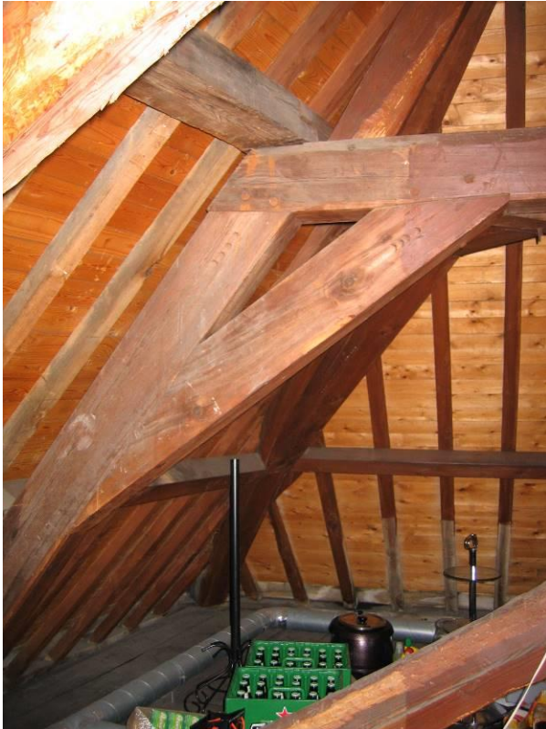
Overzicht onderste spantconstructie
