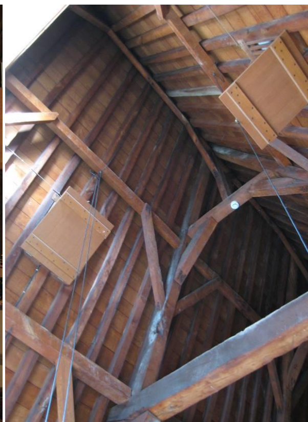
Derde (bovenste) spantconstructie
