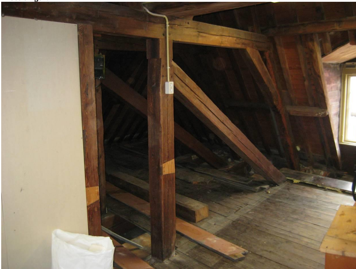
Overzicht onderste spantconstructie
