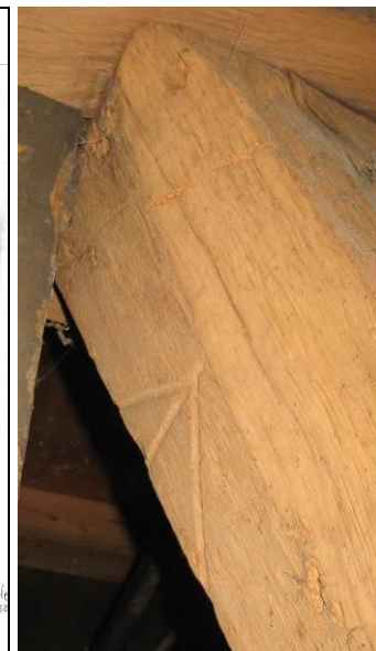
binnenzijde spantbeen rechtsachter
