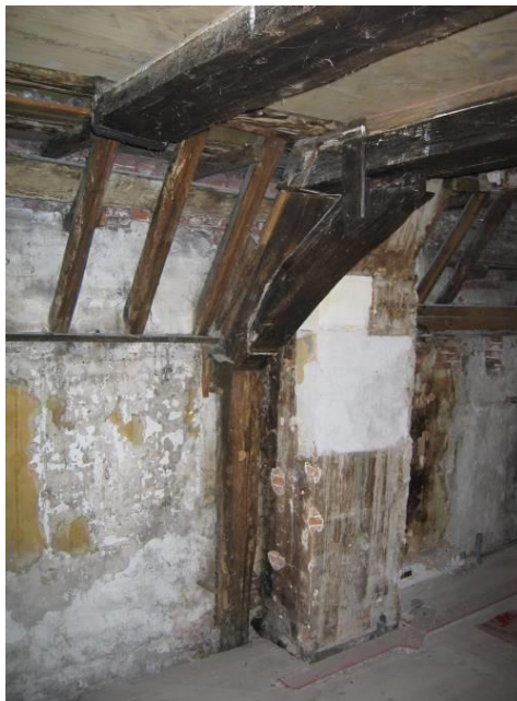
Spantconstructie
