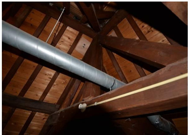
Overzicht bovenste spant met variant met makelaar
