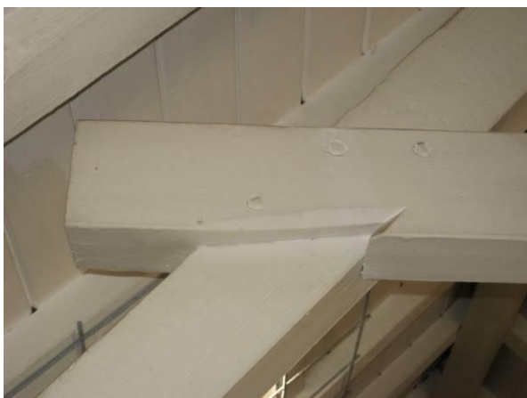
Spantbalk en spantbeen bovenste spant
