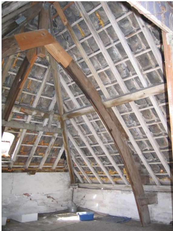
Spantconstructie
