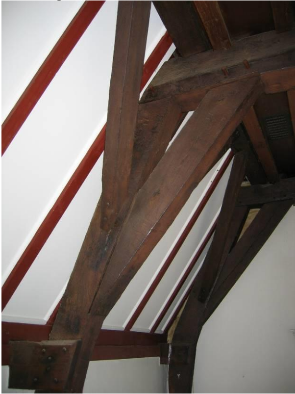
Onderste spantconstructie
