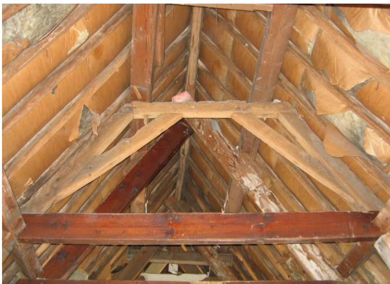
Constructie bovenste spant
