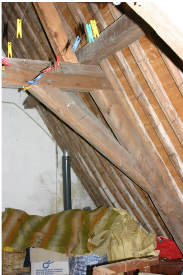
Onderste spantconstructie
