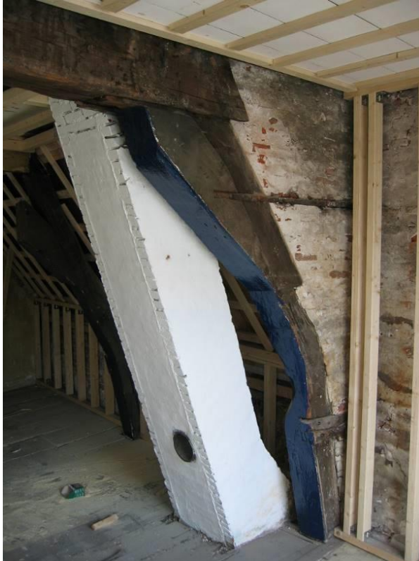
Onderste spantconstructie
