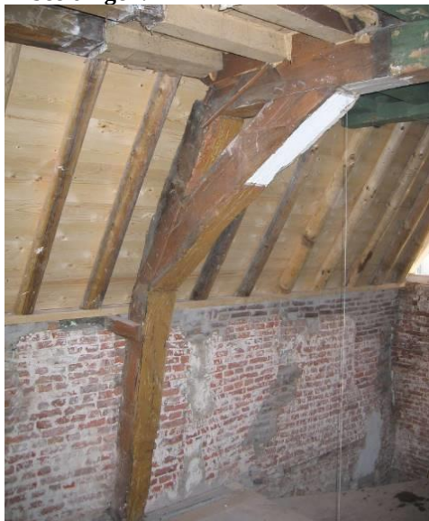
Spantconstructie
