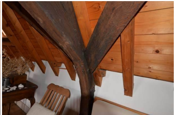
Windschore geperd in spantbeen
