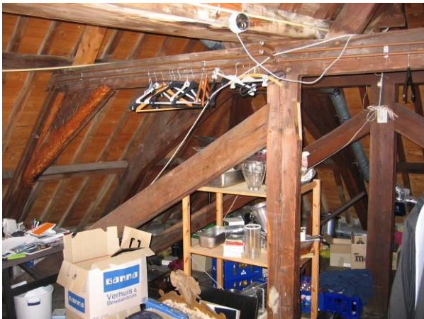
Overzicht onderste spantconstructie met hangwerk
