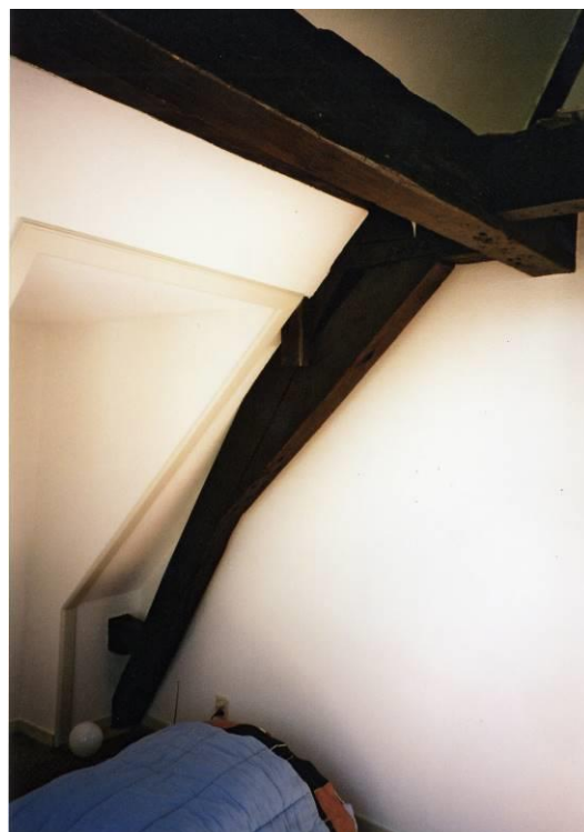
Overzicht onderste spantconstructie achter
