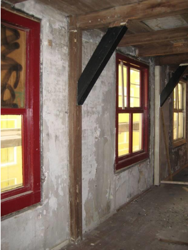
Houtconstructie tegen voorgevel
