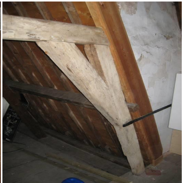
Spantconstructie bovenste spant
