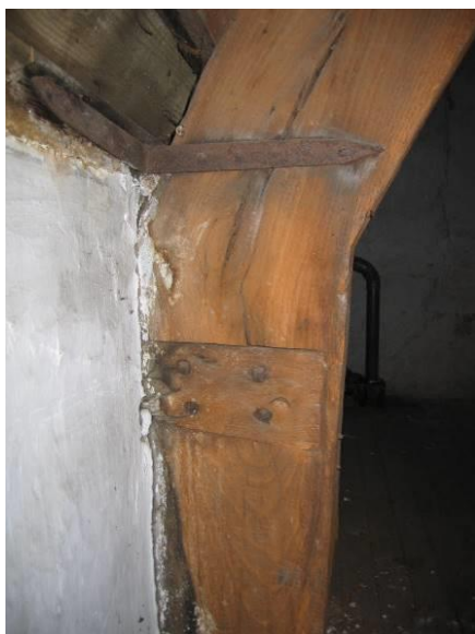
Spantbeen met gelijp blokkeel
