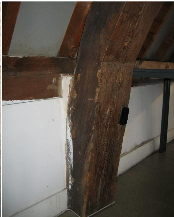
Spantbeen met twee nagels van gepend blokkeel
