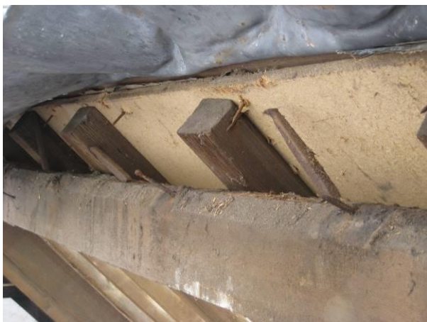
Nokconstructie met resten nokruiterbokjes
