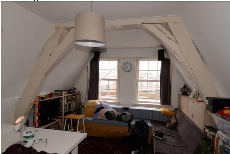
Onderste spantconstructie
