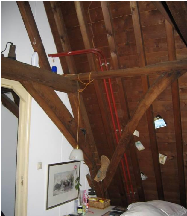
Constructie bovenste spant
