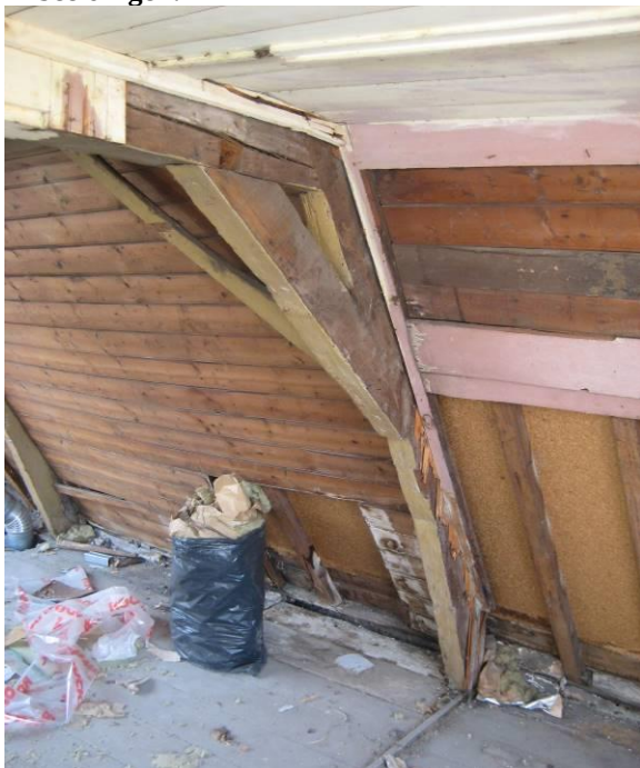
Onderste spantconstructie
