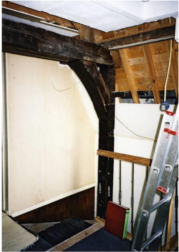
Onderste spantconstructie met verticale stijl/trapspil
