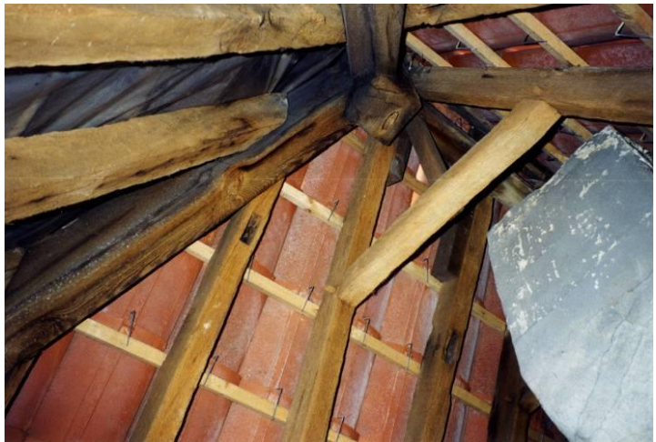
Sporen, haanhout en toegevoegde makelaar met hoekkepers
