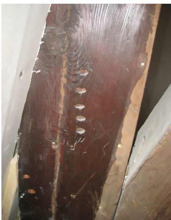
Spantbeen met telmerk
