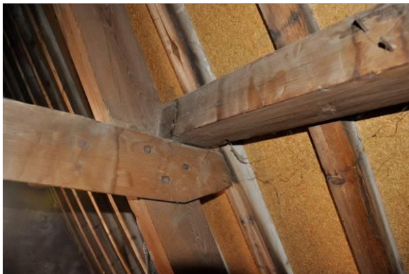
Spantbalk en fliering bovenste spant
