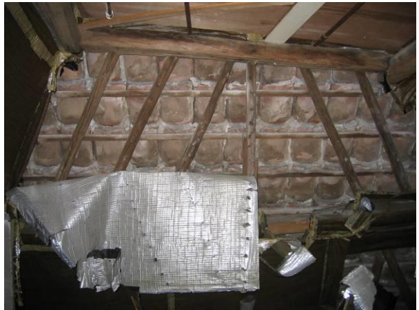
Voorste dakschild met schuin geplaatste daksporen
