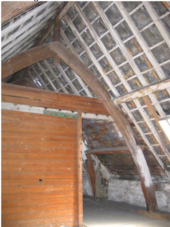
Spantconstructie
