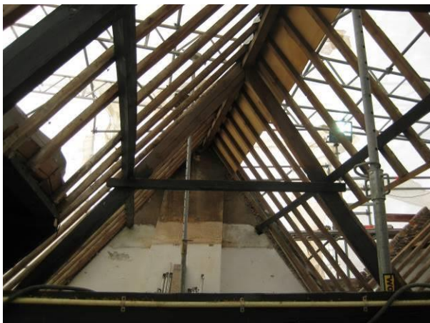
Spantconstructie bovenste spant voorzijde
