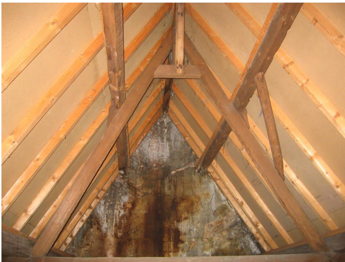
Bovenste spantconstructie
