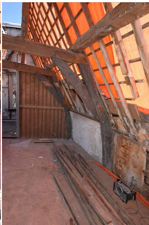
Onderste spantconstructie
