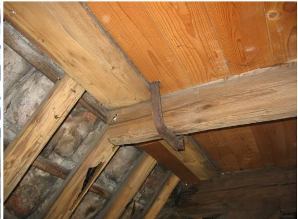
Hangbalk in smeedijzeren strop
