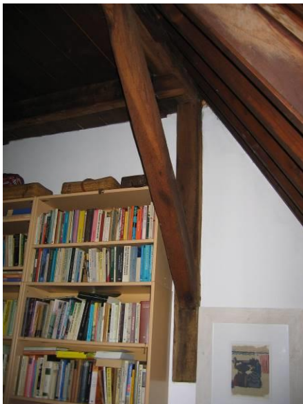
Muurstijl onder fliering
