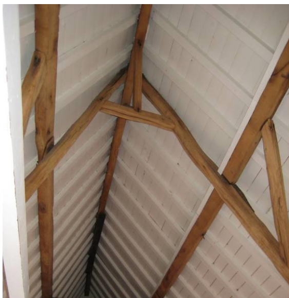
Bovenste spantconstructie
