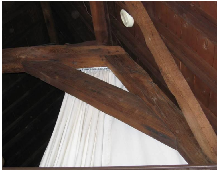
Constructie bovenste spant
