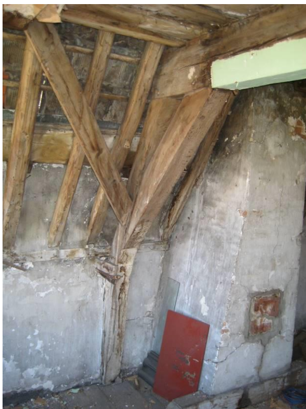
Onderste spantconstructie
