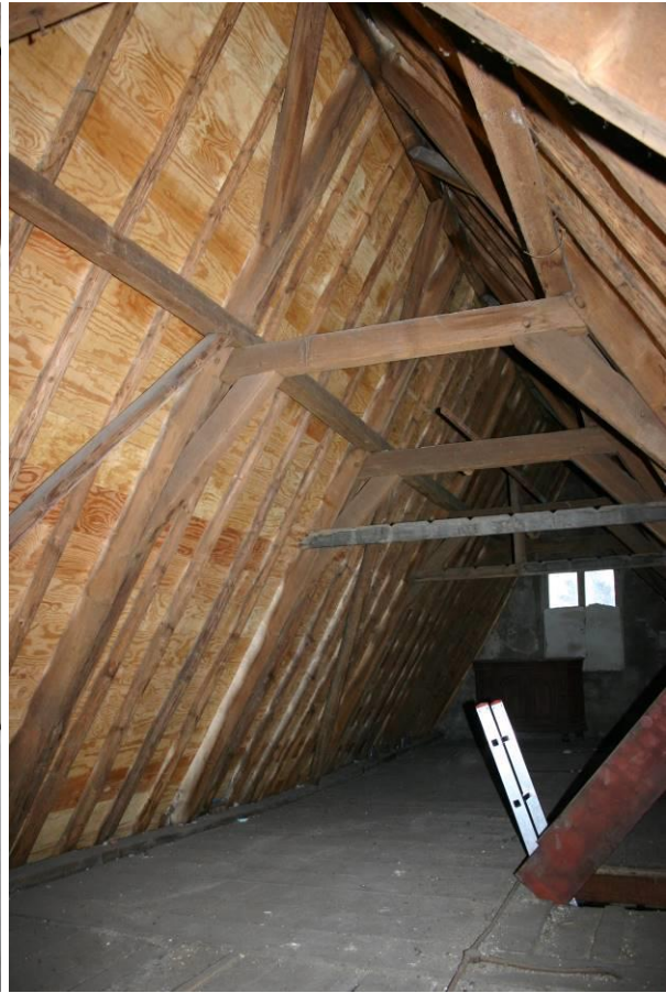
Spantconstructie vliering
