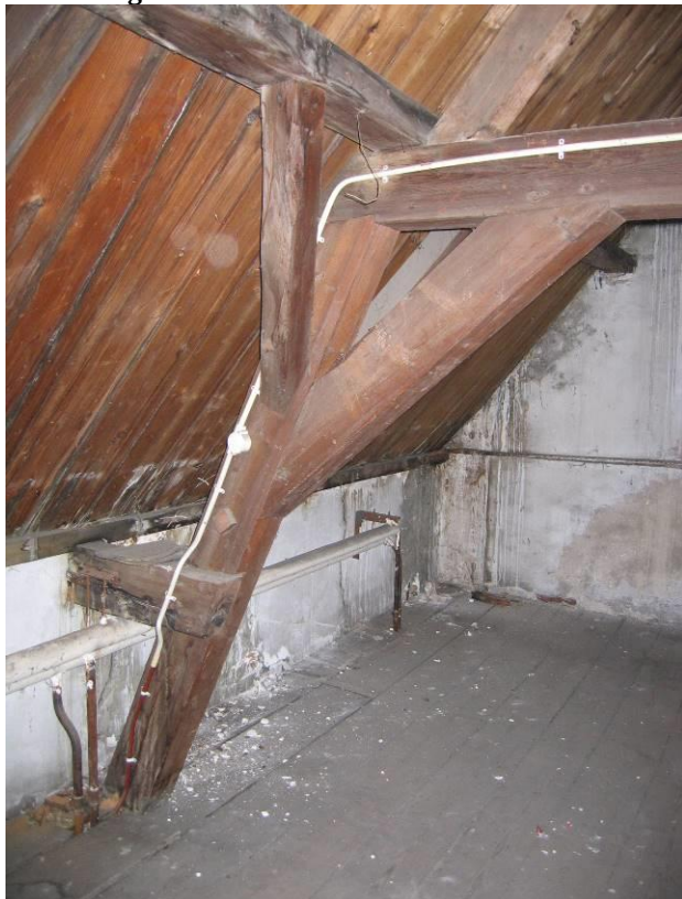
Spantconstructie onderste spant, voorgevel
