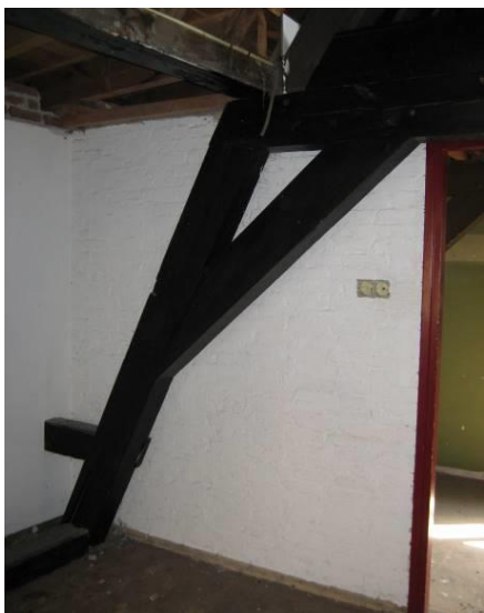
Spantconstructie onderste spant, rechts
