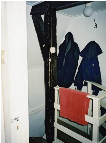
Onderste spantconstructie met verticale stijl/trapspil
