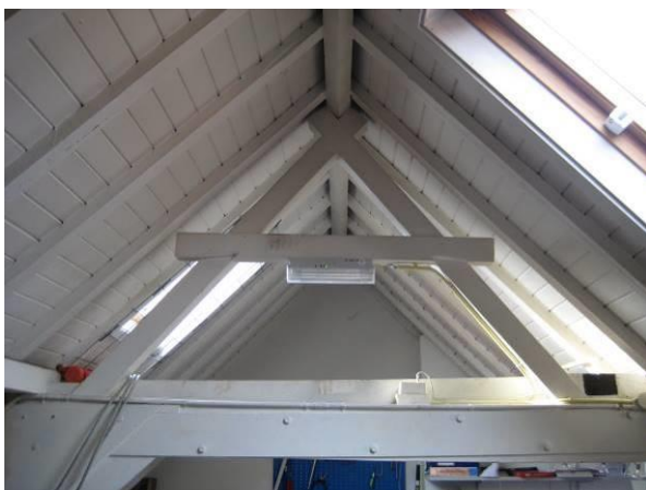
Spantconstructie bovenste spant
