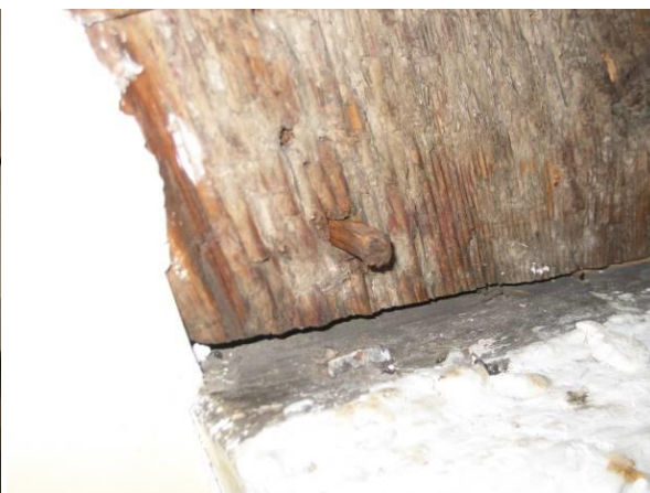
Spantbeen onderste spant met wigje
