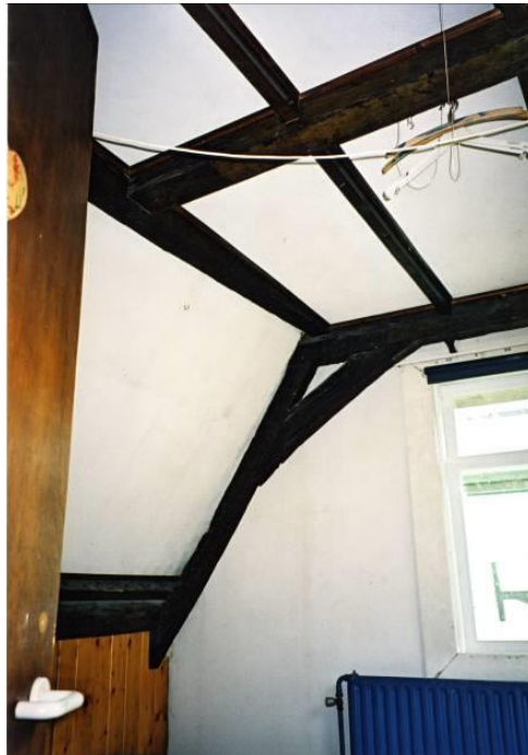
Spantconstructie strijkspant
