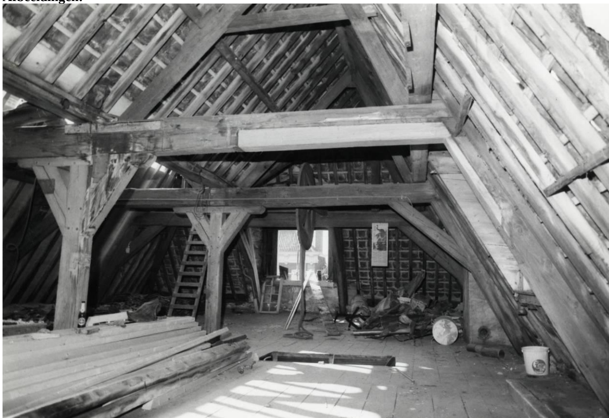
Overzicht spantconstructie
