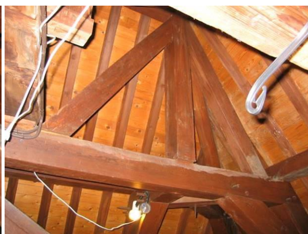
Overzicht bovenste spant met variant met makelaar
