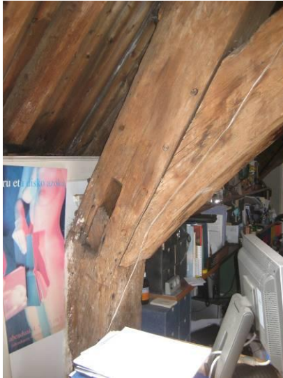
Spantbeen onderste spant
