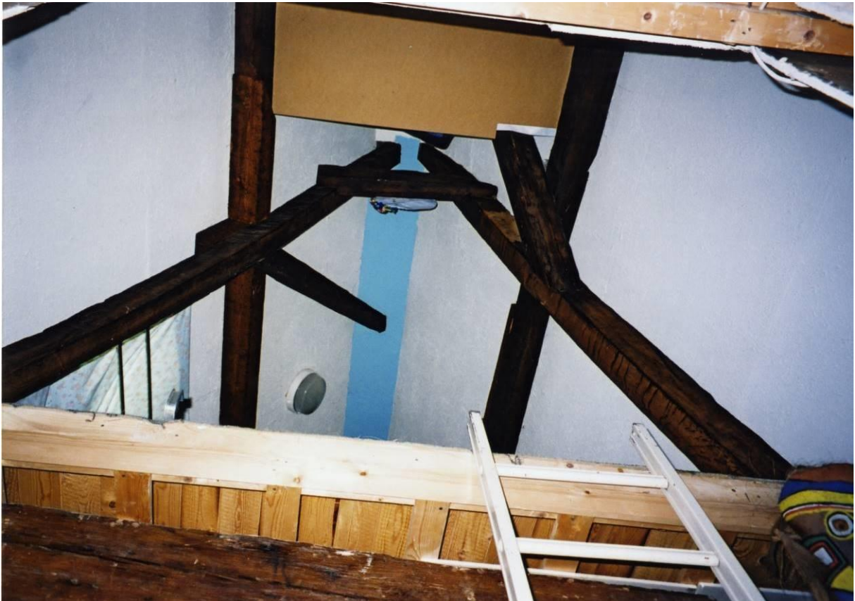
Tweede en bovenste spantconstructie
