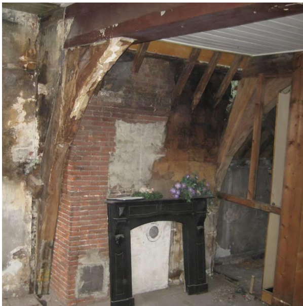
Spantconstructie onderste spant
