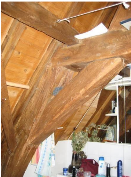
Spantconstructie
