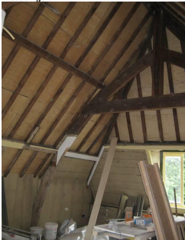
Spantconstructie
