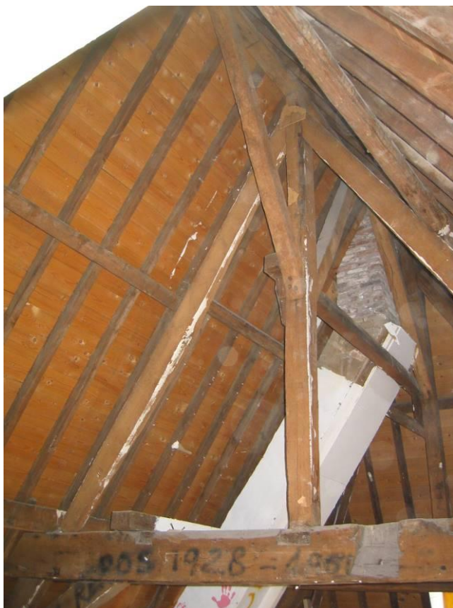
Derde (bovenste) spantconstructie
