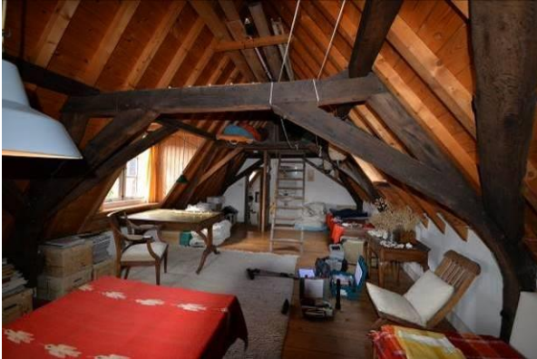
Constructie spant
