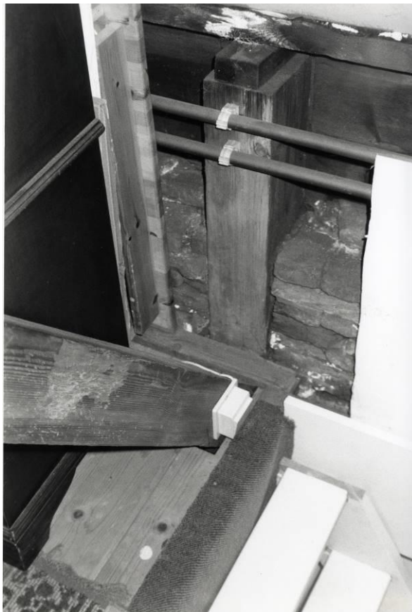
Borstwering deels van baksteen, deels van hout
