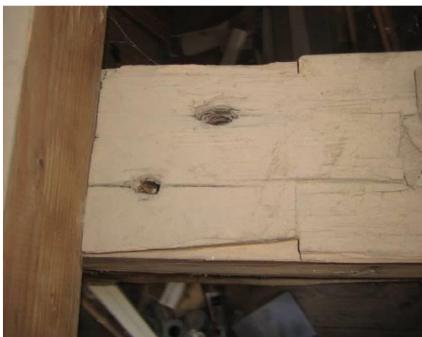
Voerloef voor fliering in dekbalk
