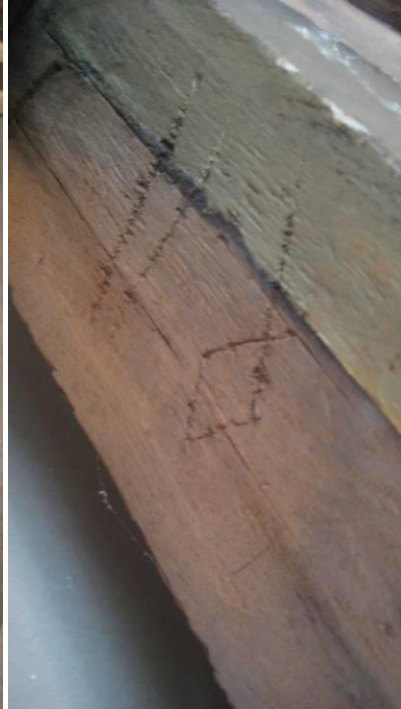
Telmerk II en richtingsteken visje
