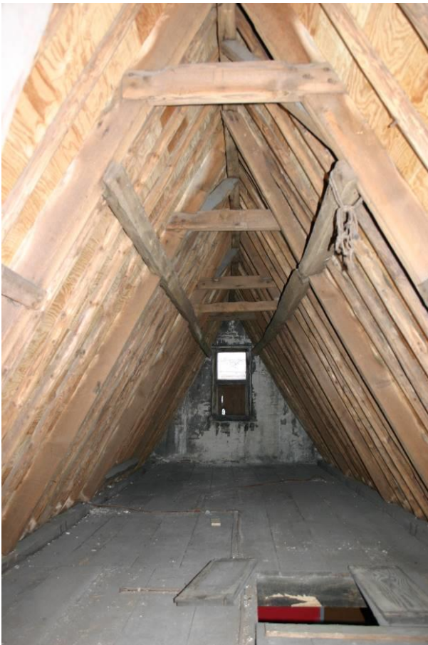
Spantconstructie vlieringzolder
