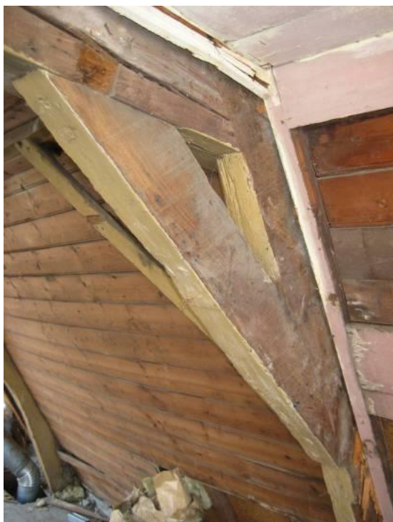
gelipt spantbeen en vernageld korbeel
