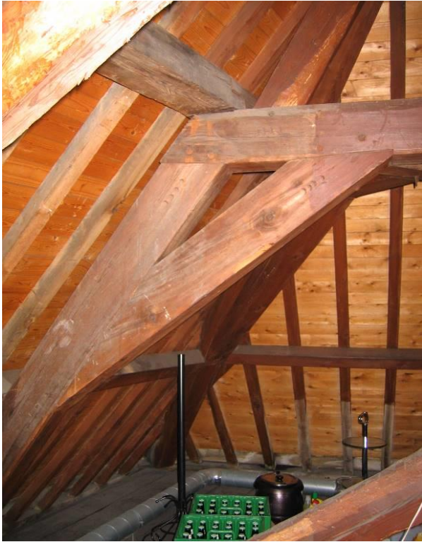
Overzicht onderste spantconstructie
