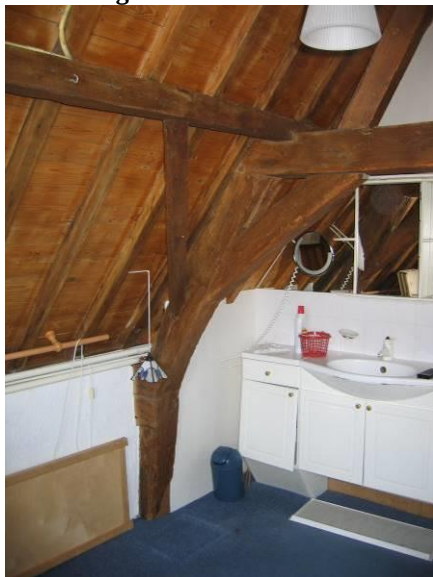
Spantconstructie
