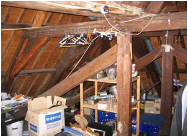
Overzicht onderste spantconstructie met hangwerk
