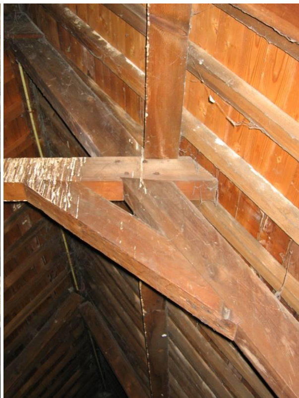
Bovenste spantconstructie met spantbeen met borst
