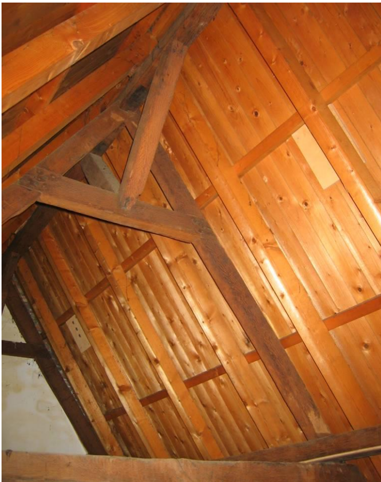
Bovenste spantconstructie
