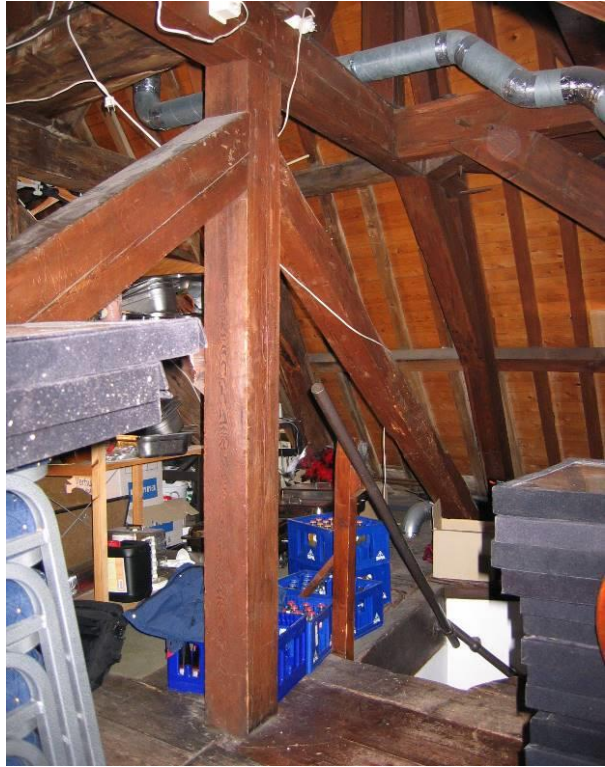
Overzicht onderste spantconstructie met hangwerk
