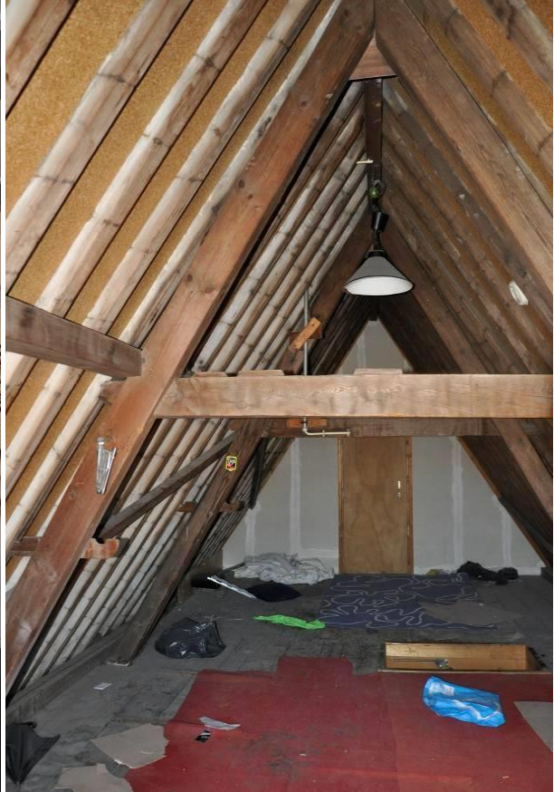
Bovenste spantconstructie
