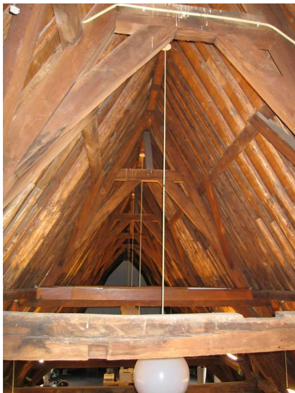
Derde (bovenste) spantconstructie
