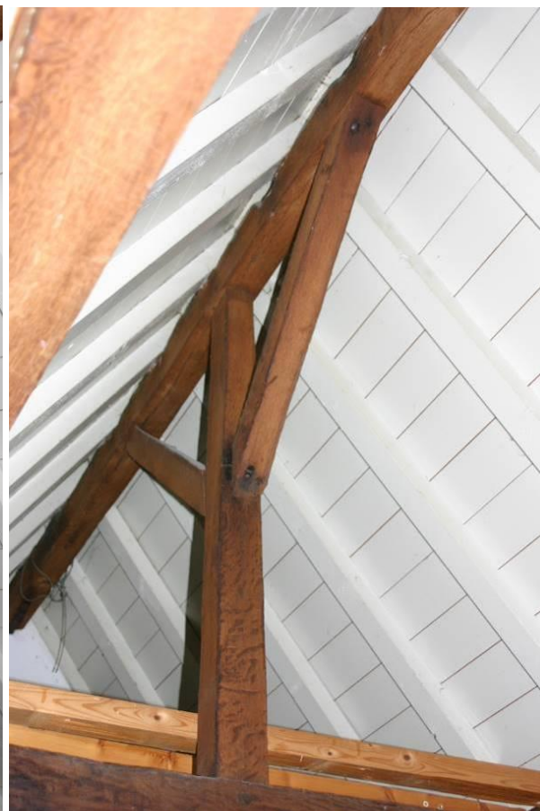
Derde (bovenste) spantconstructie
