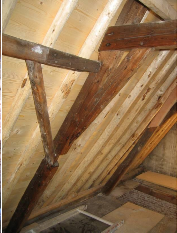
Bovenste spantconstructie
