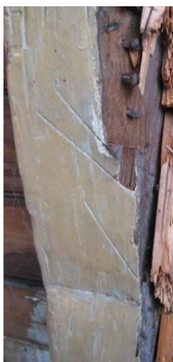
Doorgezaagd handelsmerk II, spant rechtsvoor
