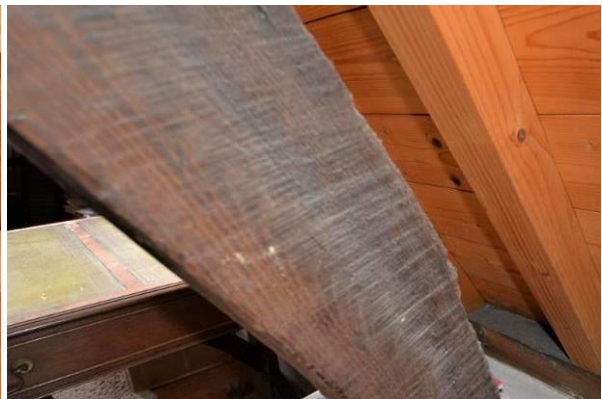
Zaagsporen op spantbeen
