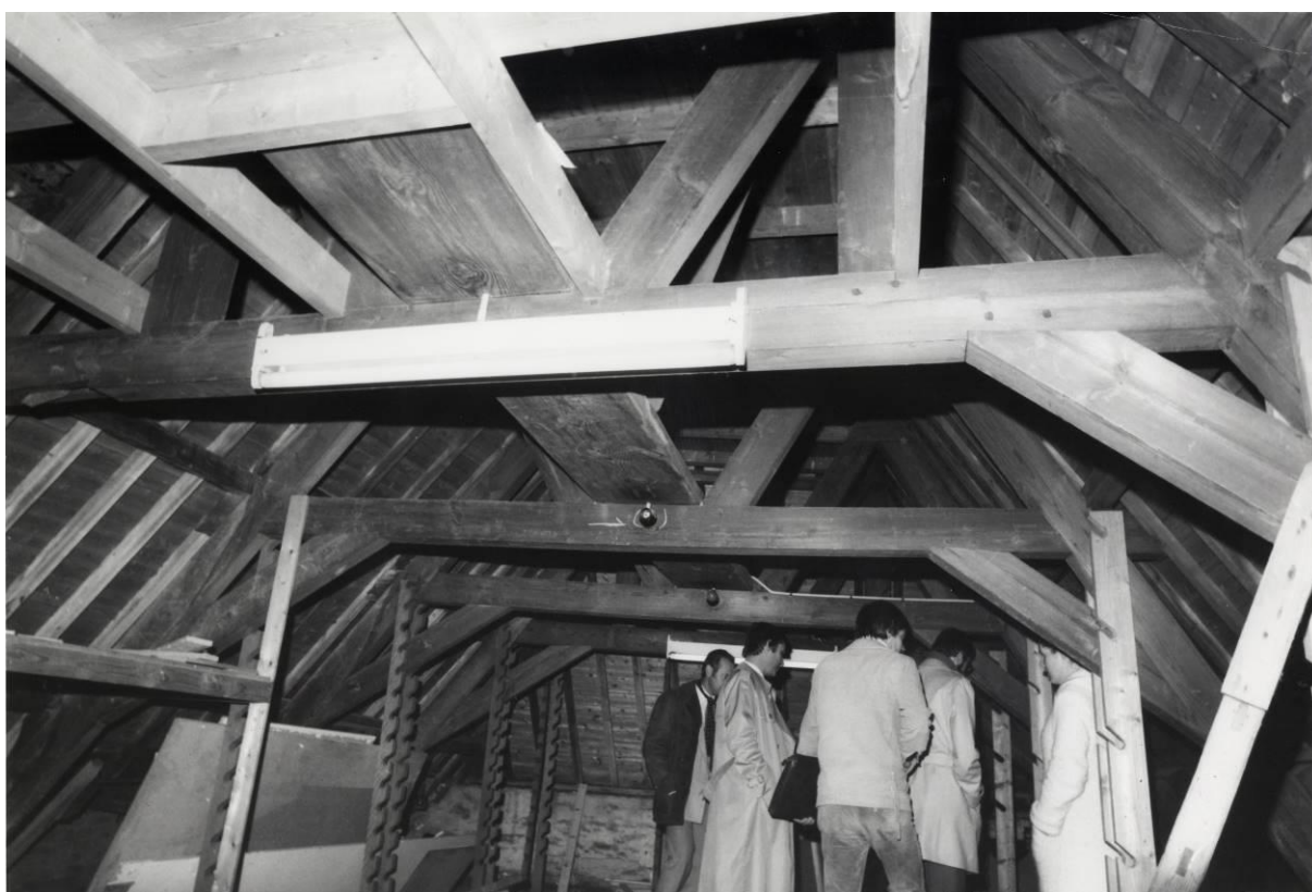
Overzicht spantconstructie met in het voorste spant extra stijlen ter ondersteuning nok en hoekkepers
