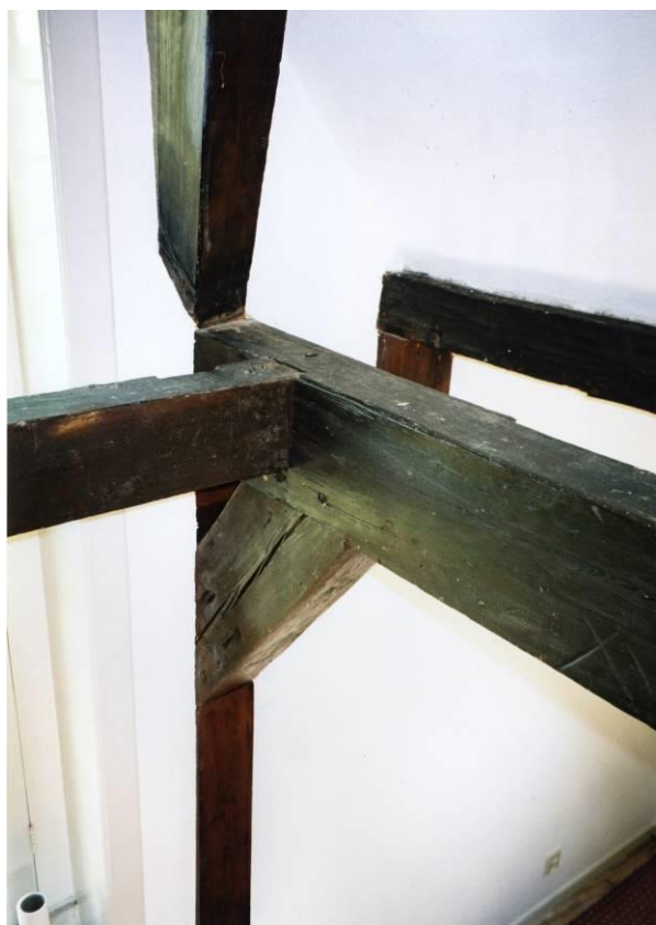
Onderste spantconstructie voor, op dekbalk merk
