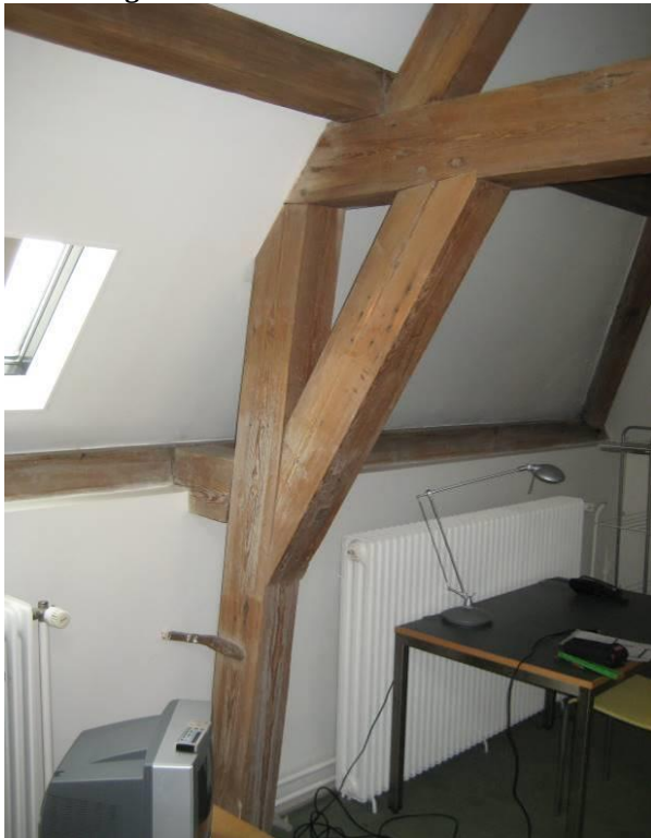
Overzicht onderste spantconstructie, voor
