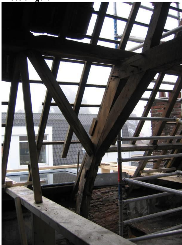
Onderste spantconstructie
