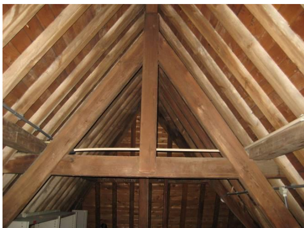
Bovenste spantconstructie
