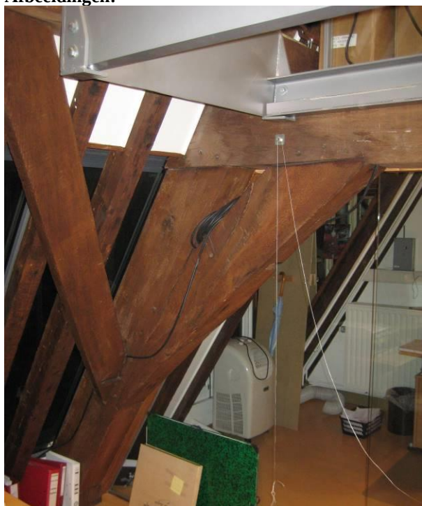
Overzicht constructie onder
