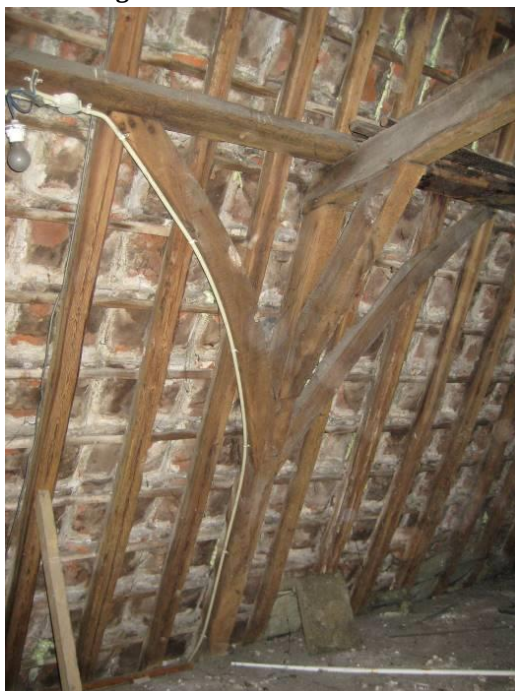
Spantconstructie bovenste spant
