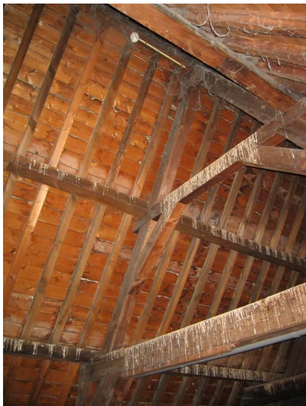
Overzicht bovenste spantconstructie
