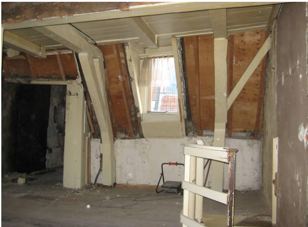
Onderste spantconstructie
