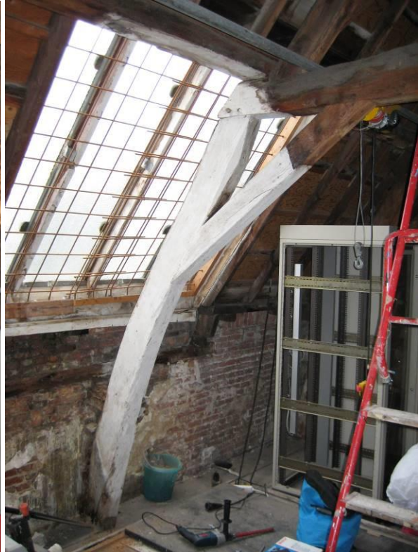
Onderste spantconstructie
