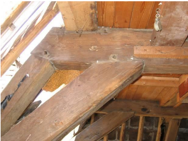
Onderste dekbalk met schuine aansluiting op spantbeen
