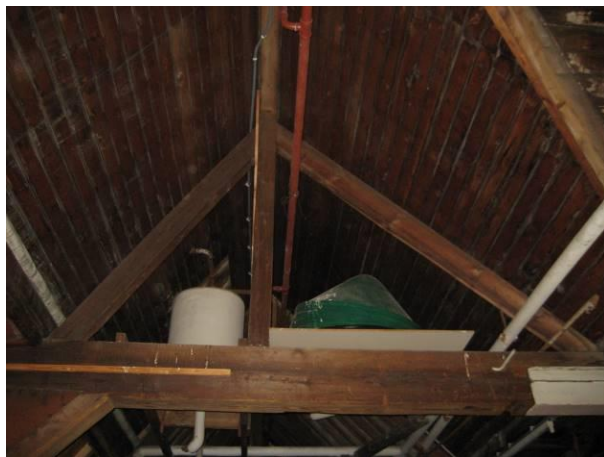
Overzicht bovenste spantconstructie
