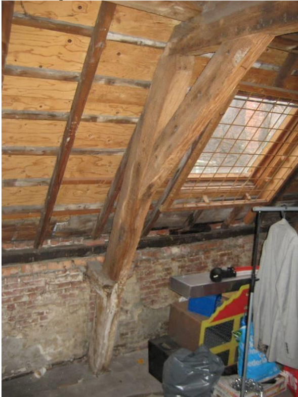
Onderste spantconstructie
