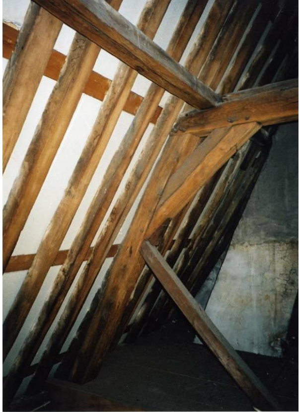
Tweede spantconstructie
