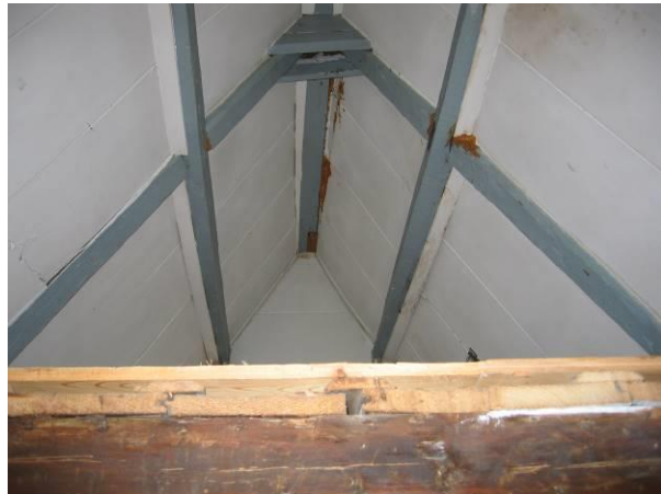
Overzicht spantconstructie, nok
