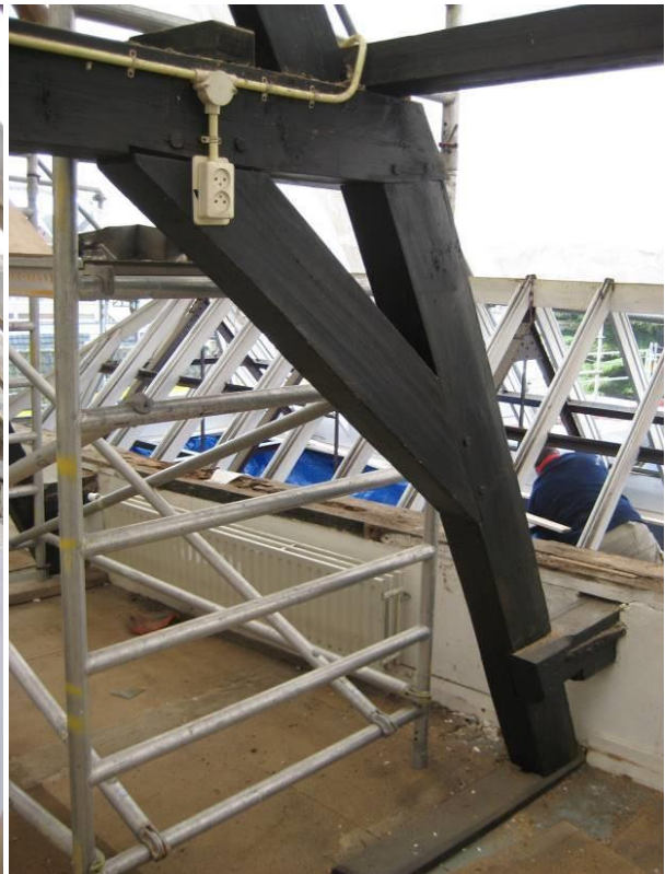
Spantconstructie onderste spant, achtergevel
