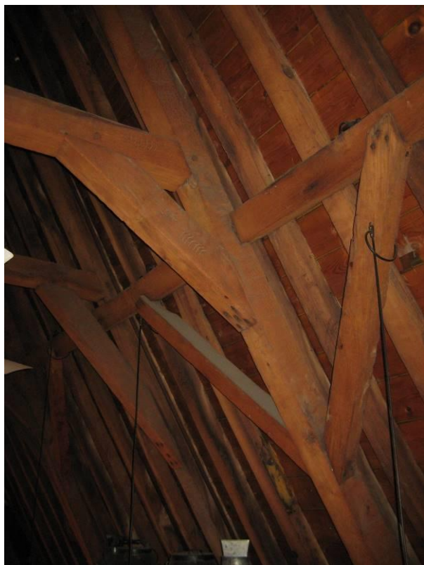
Derde (bovenste) spantconstructie
