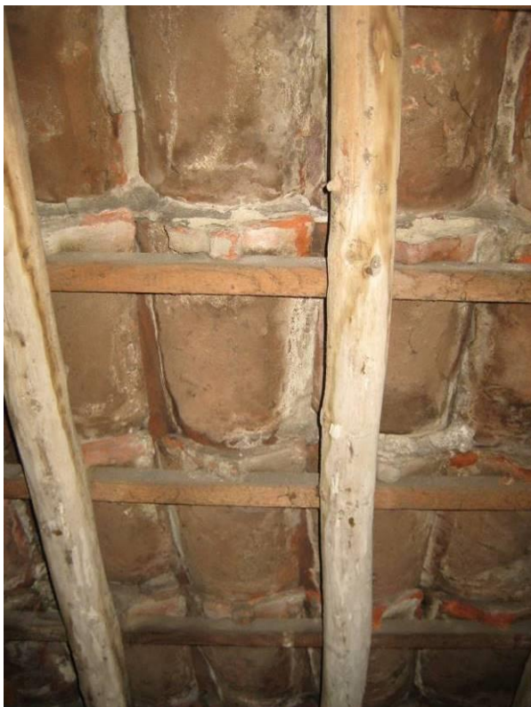
Dakschild; aangesmeerde enkel- en dubbelnokspannen
