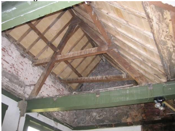
Overzicht spantconstructie voorzijde
