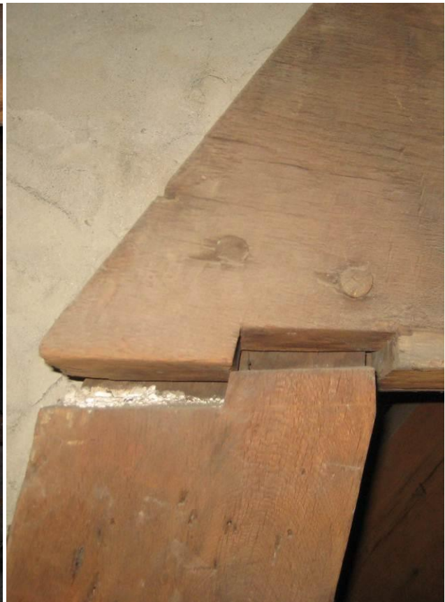
Verbinding spantbeen en dekbalk
