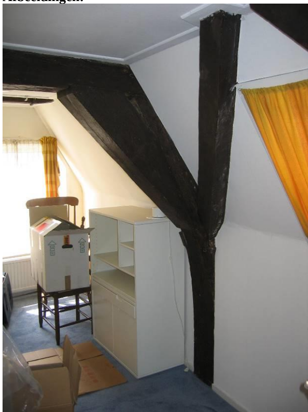
Onderste spantconstructie
