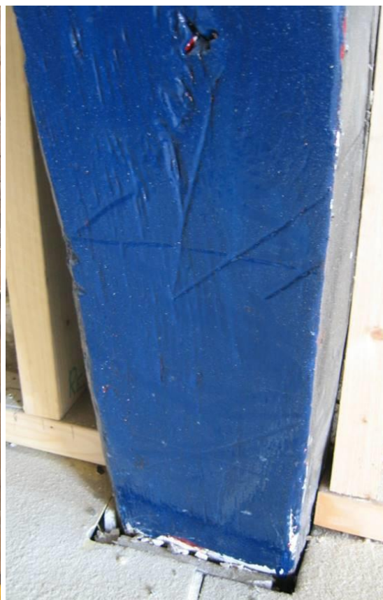
Eigendoms- of timmermansmerk' op spantbeen
