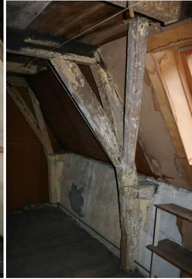
Spantconstructie met krommer
