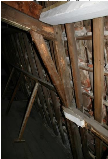
Onderste spantconstructie
