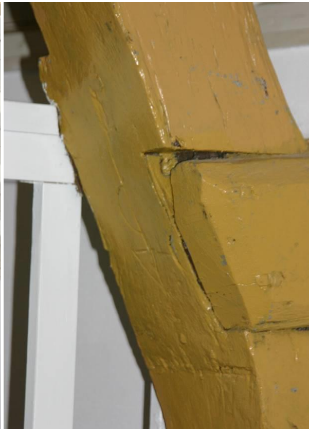
‘Eigendoms of timmermanmerk’ op gekromd spantbeen
