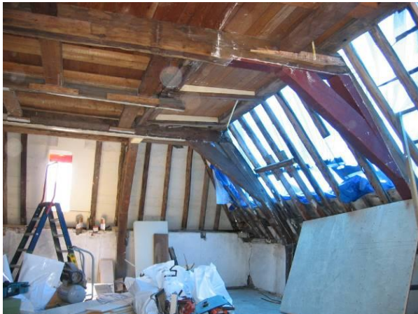
Onderste spantconstructie met zij- en voorschild
