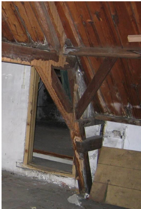
Spantconstructie onderste spant, zakgoot
