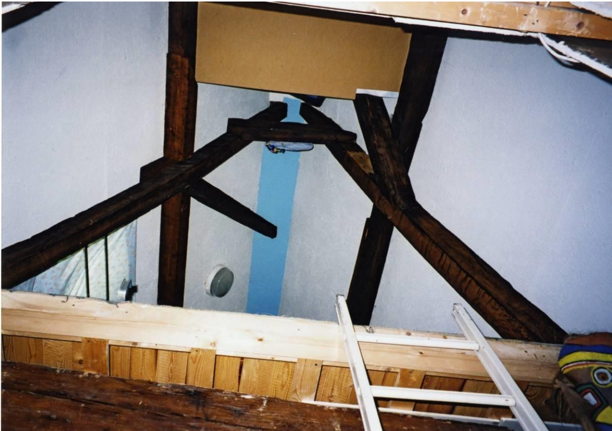
Tweede en bovenste spantconstructie
