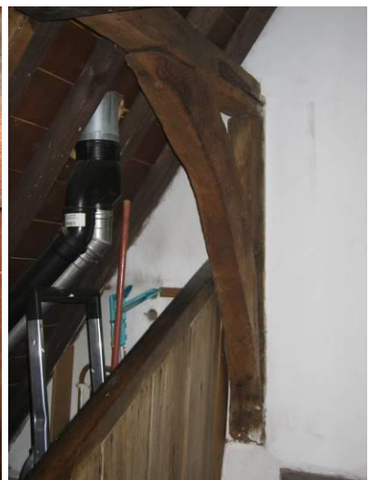
Muurstijl onder fliering
