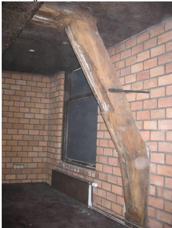
Onderste spantconstructie
