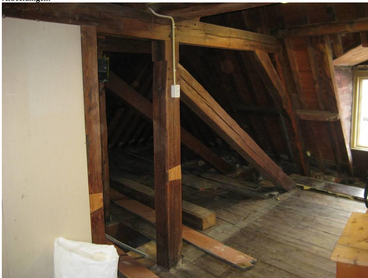
Overzicht onderste spantconstructie
