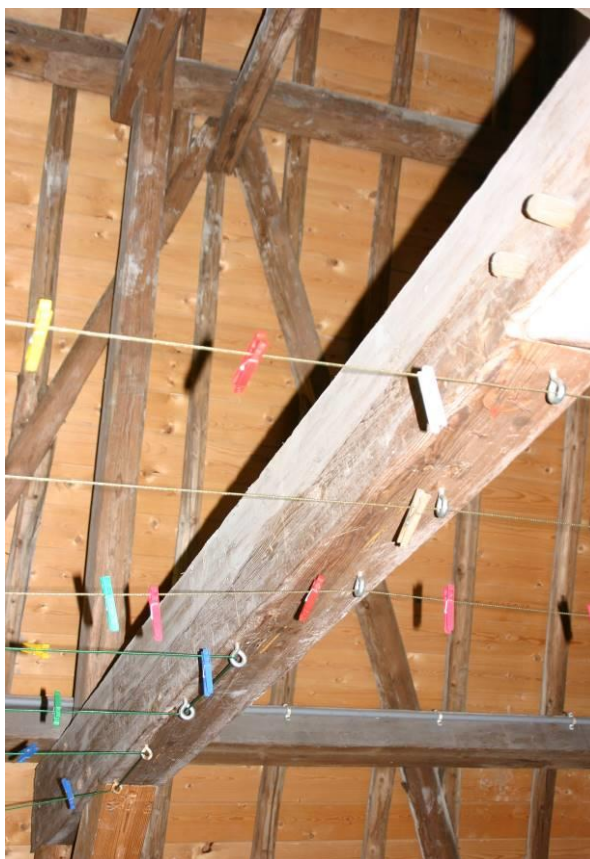
Hoekkepers en nokgording van (verdwenen) aankapping
