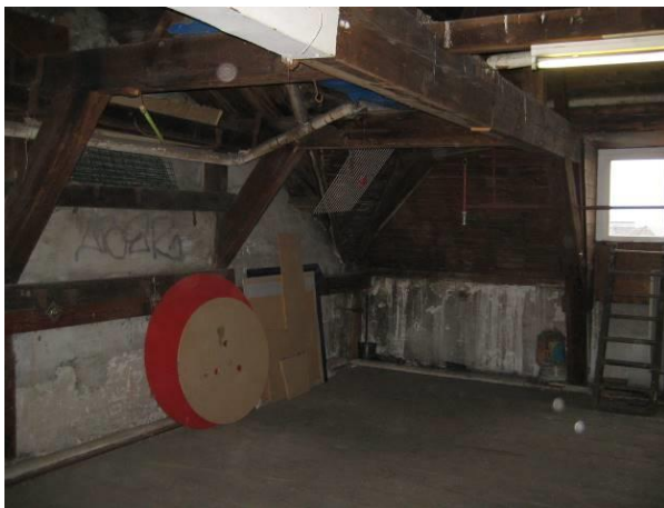
Overzicht halfspanten langs voorgevel
