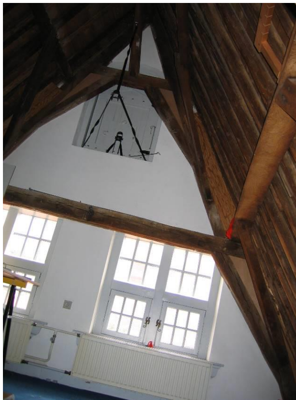
Strijkspantconstructie
