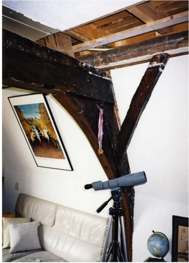
Onderste spantconstructie
