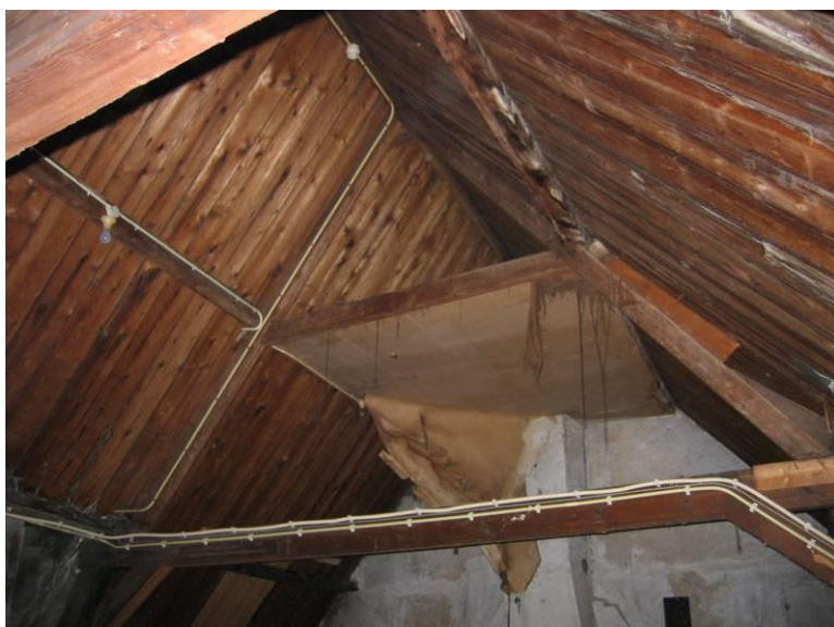
Spantconstructie bovenste spant
