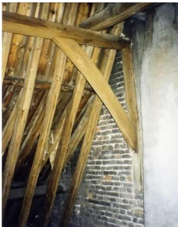
Muurstijl onder fliering
