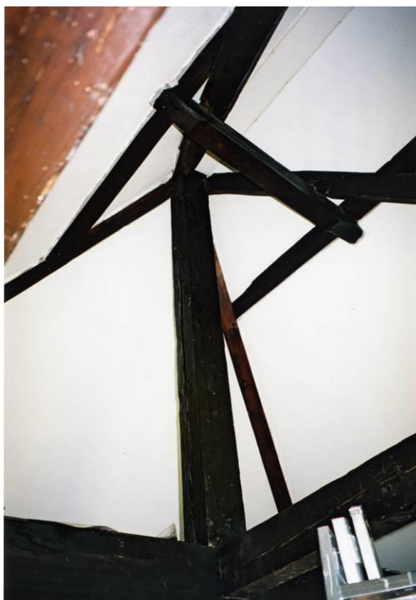
Overzicht bovenste spantconstructie
