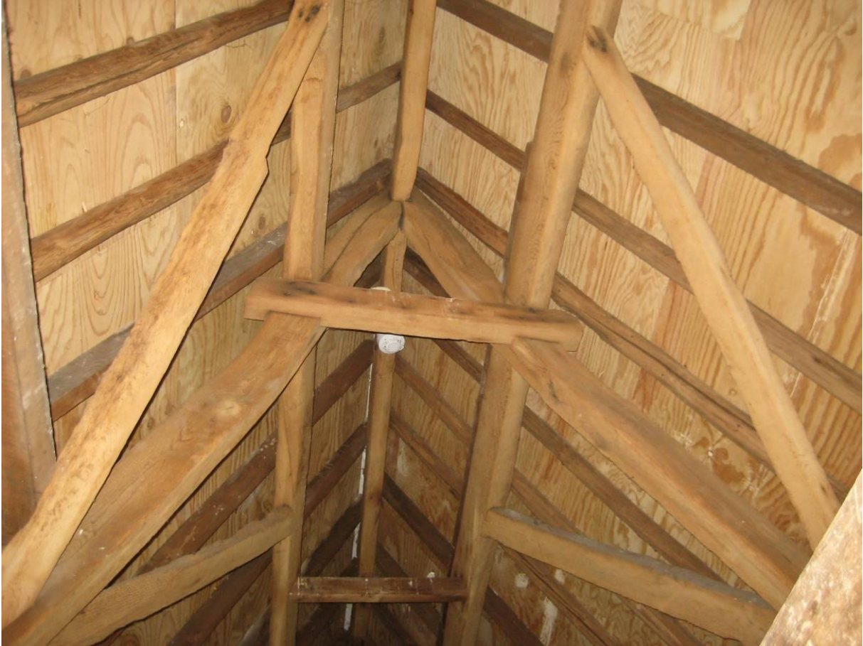
Bovenste spantconstructie
