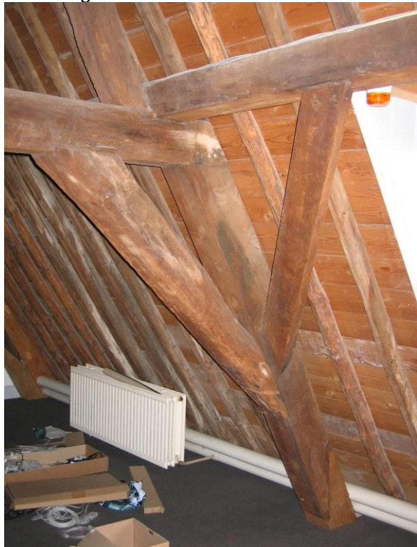
Onderste spantconstructie
