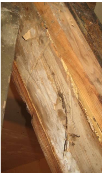
Doorgezaagd merk, binnenzijde spantbeen linksachter
