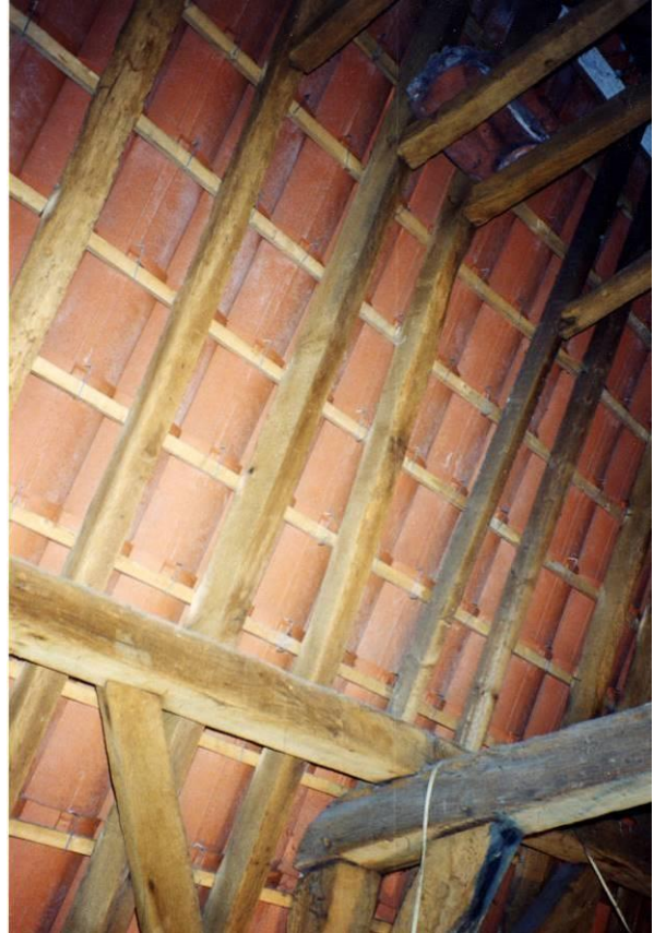
Bovenste spant en sporen
