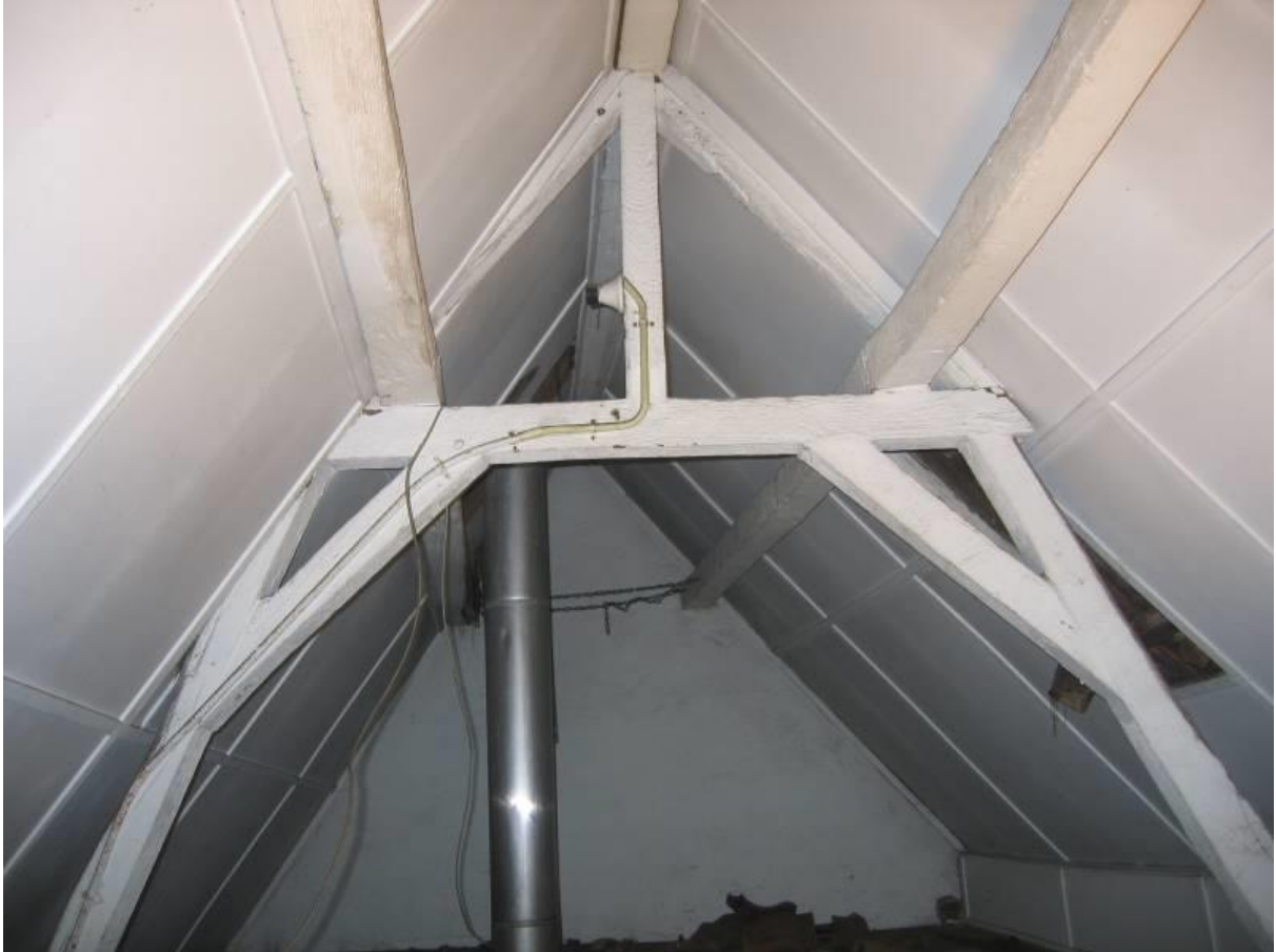
Derde en bovenste spantconstructie
