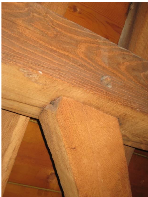
Tweede spantconstructie, windschoor gepend in fliering
