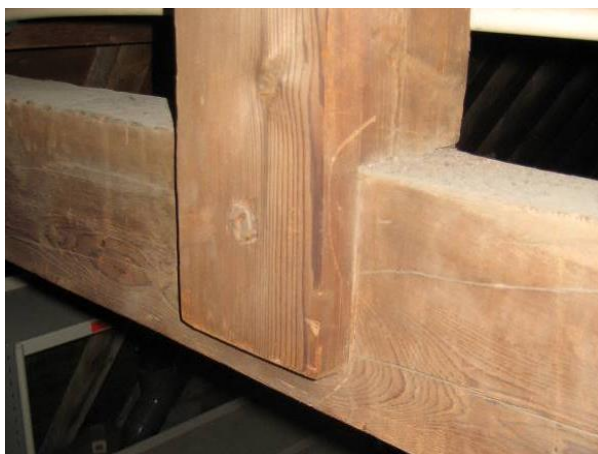
Nokstijl gelipt en gepend in spantbalk
