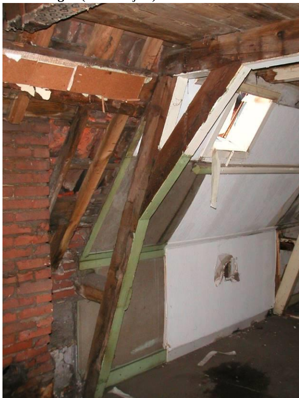
Onderste spantconstructie
