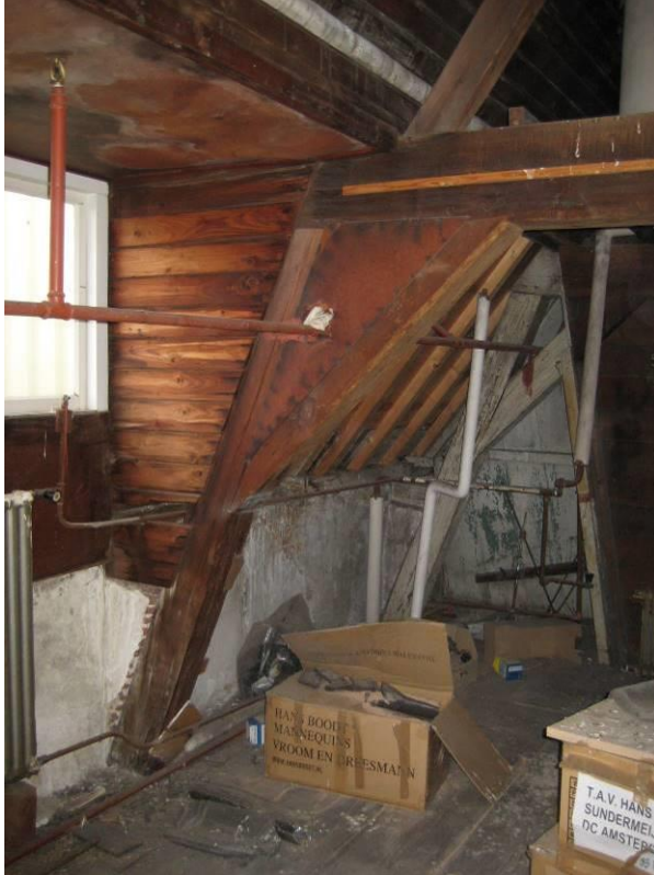
Overzicht onderste spantconstructie
