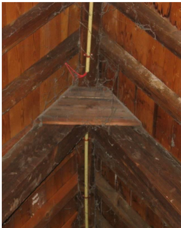
Nokconstructie met schetsplaat
