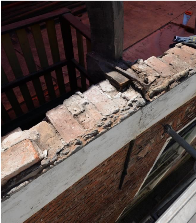
292 Nieuwsteeg 17, 1592, borstwering, blokkeel en anker
