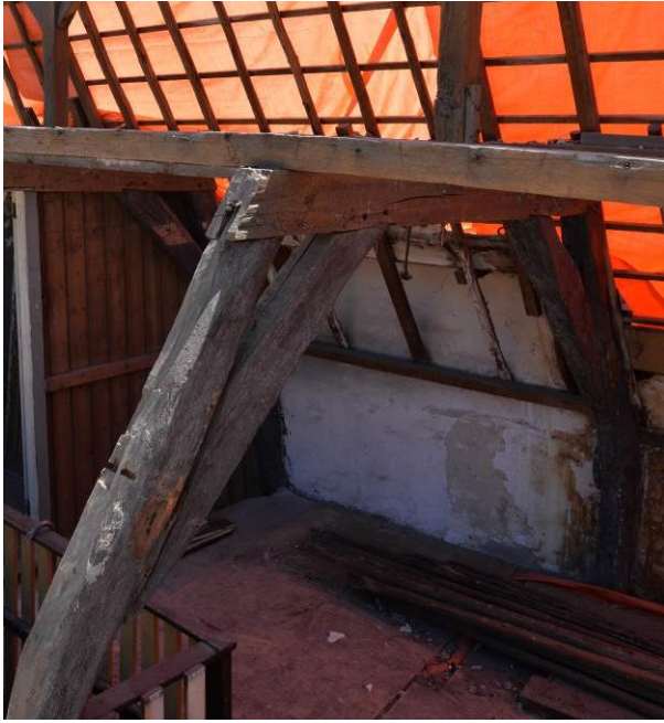
100 Behakt constructiehout, Nieuwsteeg 17, 1592
