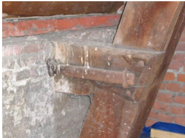
74 Houten en ijzeren blokkeelanker Hooglandsekerkgracht 11-21, 1774
