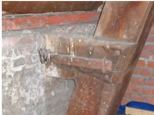
74 Houten en ijzeren blokkeelanker Hooglandsekerkgracht 11-21, 1774
