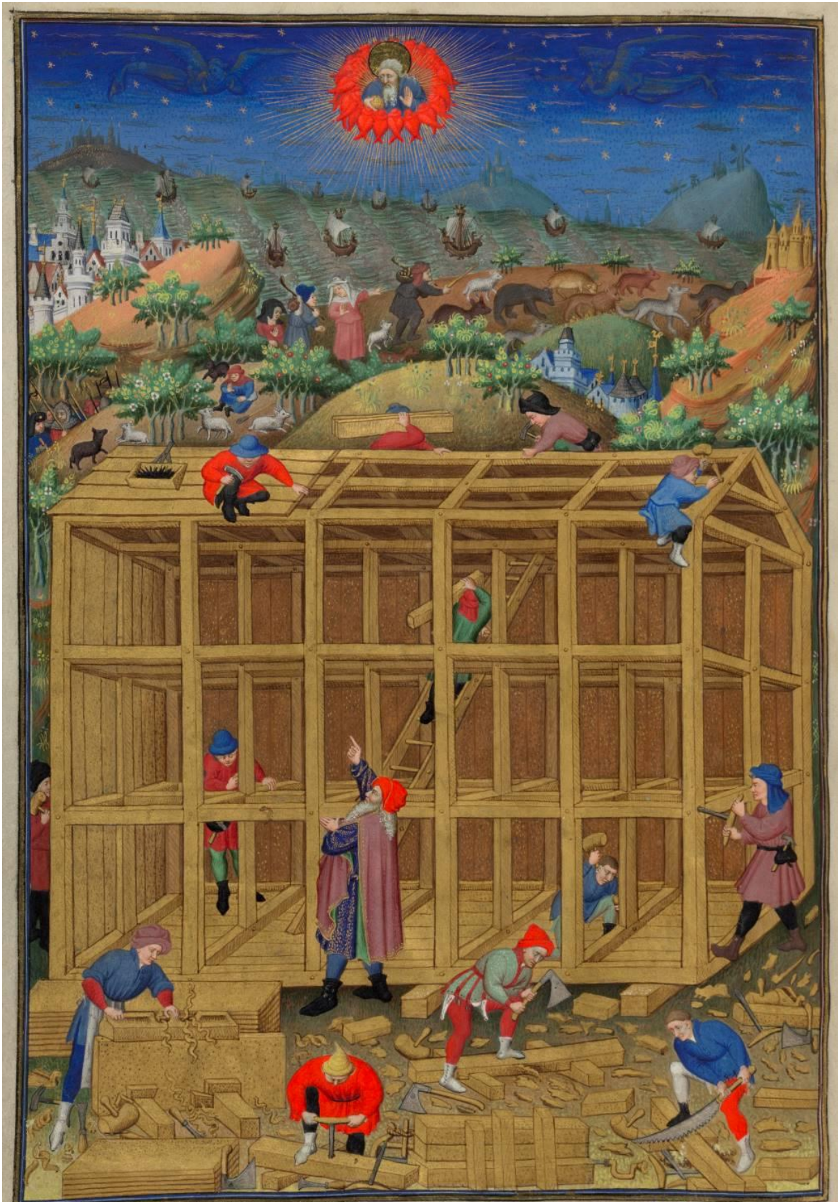
1 Bouwen van een houten gebouw in het begin van de 15 de eeuw (Bedford Hours 1423)
