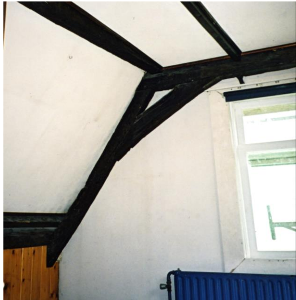
291 Langebrug 55, 1400 ± 6 jr, strijkspant
