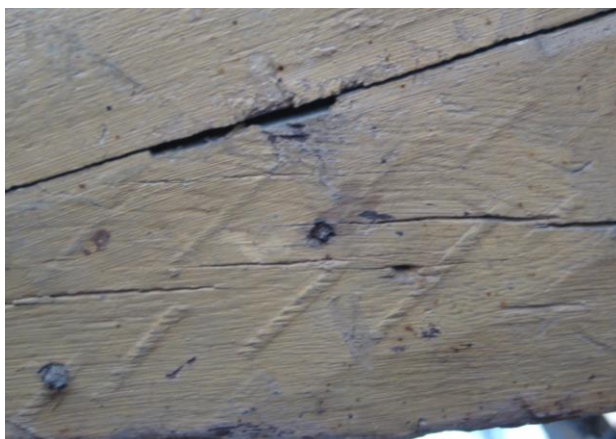
91 Sporen beschadigde bijl, Rapenburg 14, 1594
