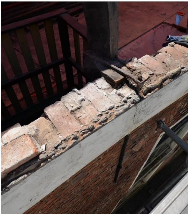
292 Nieuwsteeg 17, 1592, borstwering, blokkeel en anker
