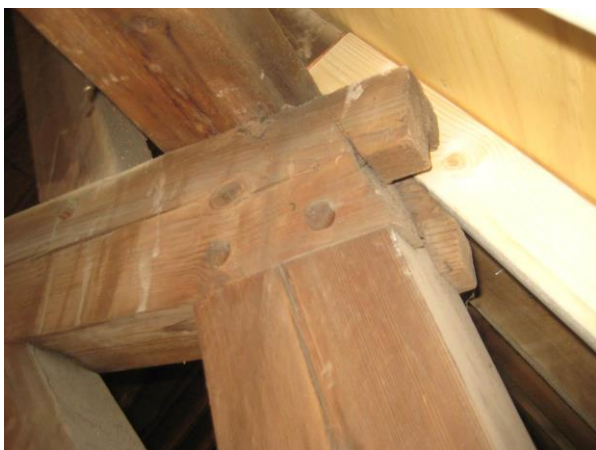
170 Rapenburg 12, 1724, deels bijgezaagde dekbalk
