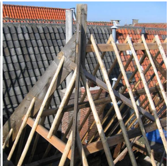
359 Nieuwe Rijn 105, direct na 1659, afvolving ca. 1900 (tijdens verbouw, o.a. vervanging sporen)
