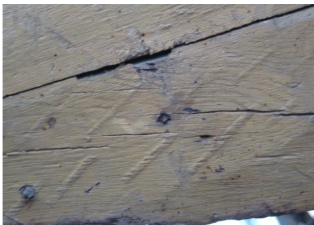
91 Sporen beschadigde bijl, Rapenburg 14, 1594
