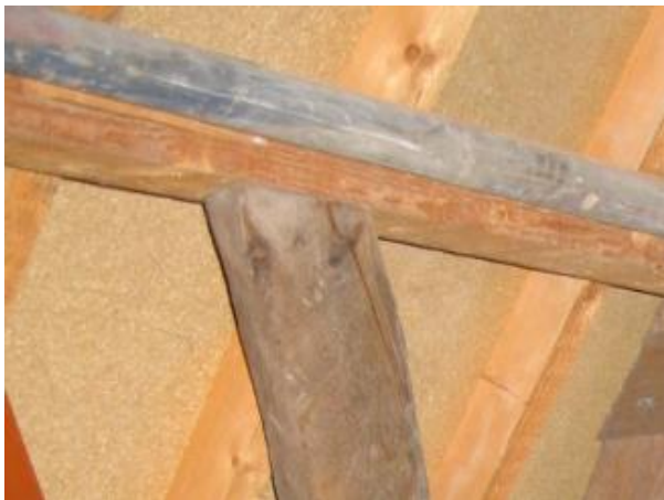
302 Steenshuur 11, 1460-1466, afgesnoten hoek
