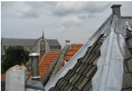
223 De drie parallelle schiddaken van Rapenburg 106, met op de zichtbare dakvlakken grijze pannen en op de minder zichtbare dakvlakken rode pannen
