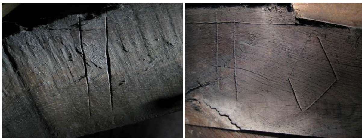
148 en 149 Telmerken // en // met zogenaamd visje, ◇, als richtingsteken; Breestraat 95, 1405-1411
