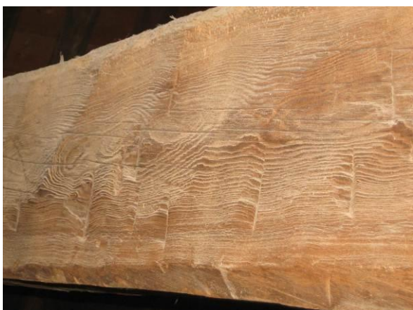
90 Afscheursporen Lammermarkt 57, na 1611
