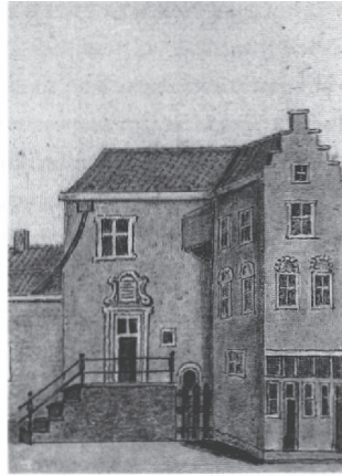
Baaihal, St. Pancras Achtergracht, Leiden (afgebroken).
