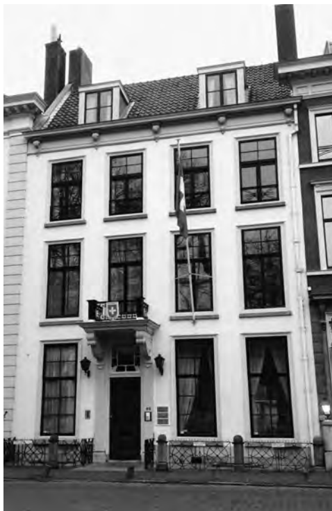
Lange Voorhout 42, Donkers woonhuis vanaf 1825. Tegenwoordig is de Zwitserse ambassade hier gevestigd
