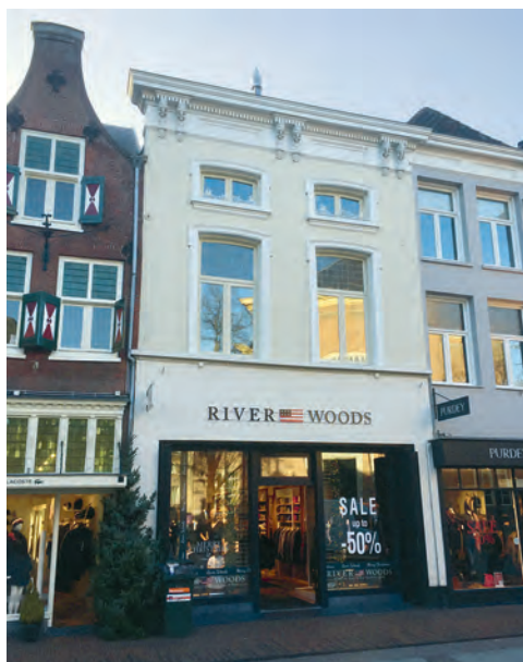
Het geboortehuis van Dirk Donker Curtius aan de Kerkstraat in Den Bosch. Momenteel is er een kledingwinkel gevestigd
