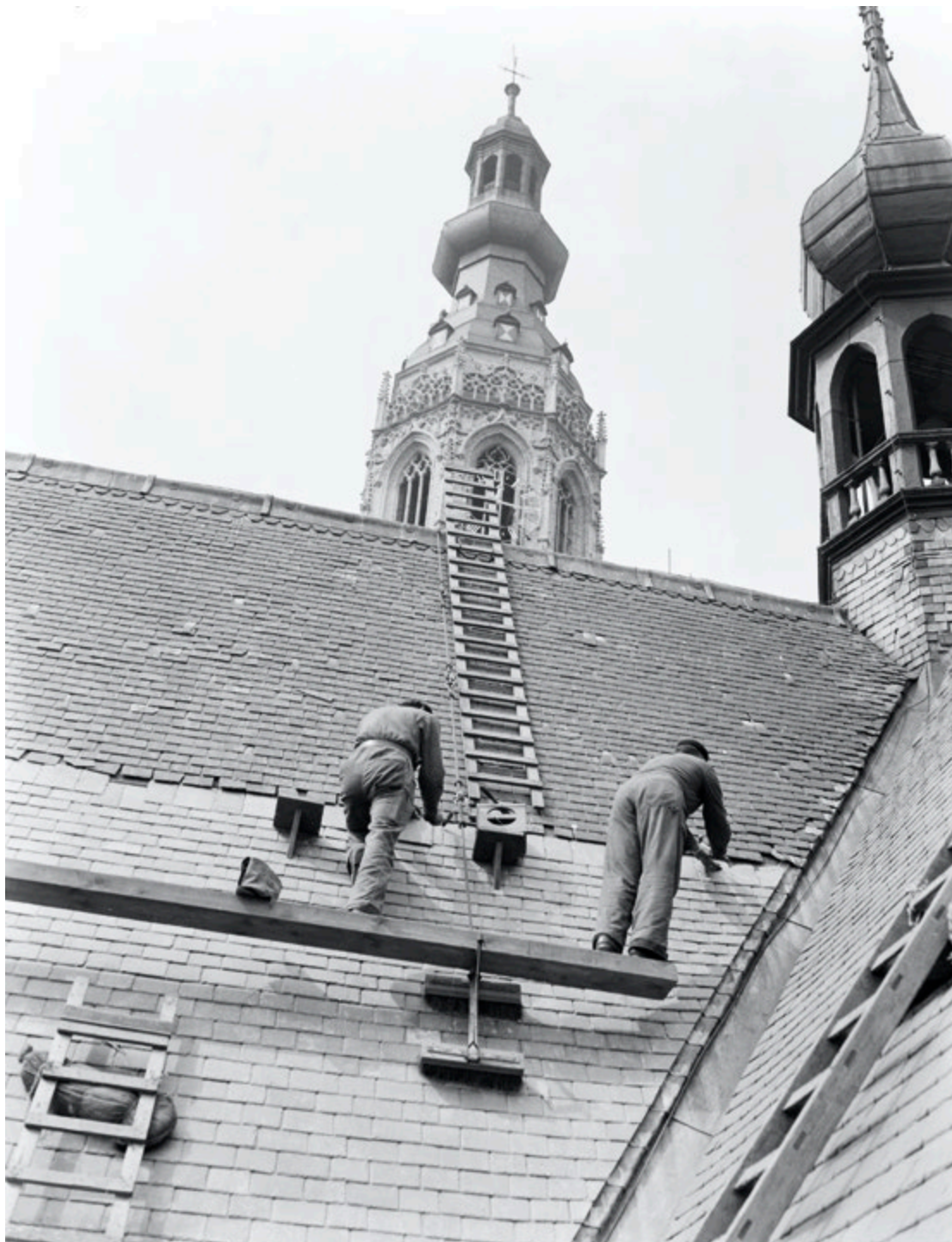
▲ Afb. 4 Restauratie van het dak van de Grote Kerk in Breda, 2 mei 1956. Wim van Rossem, Anefo.
