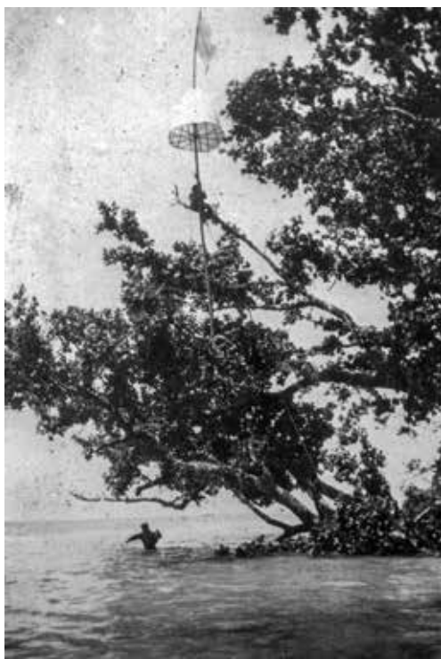
Opzetten van een baken voor een hydrografische opname in Nederlands-Indië. (NIMH)
