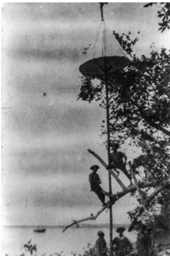
Opzetten van een baken hoog in de boom. (NIMH)
