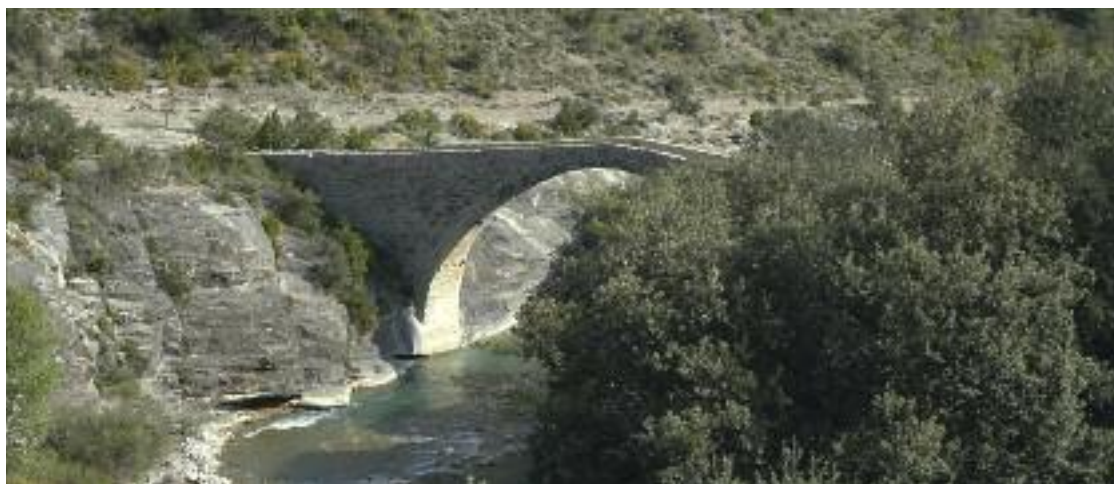
6 Romaanse brug (niet gedateerd) bij Roda de Isábena in Noord-Spanje. FOTO: DE AUTEUR
