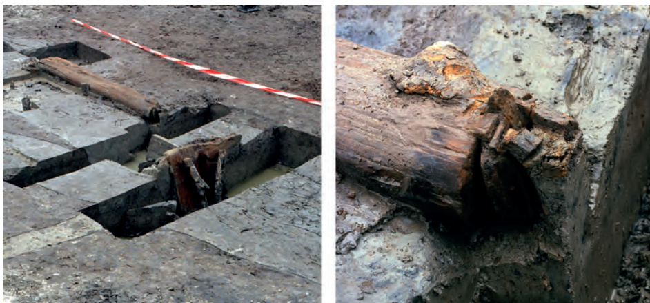
Fig. 5.28. Uitwateringsduiker in Valkenburg-Marktveld. Zichtbaar is ook de klep die zich aan de zijde van het buitenwater bevond. Foto's Rijksdienst voor het Cultureel Erfgoed / E.J. Bult.
