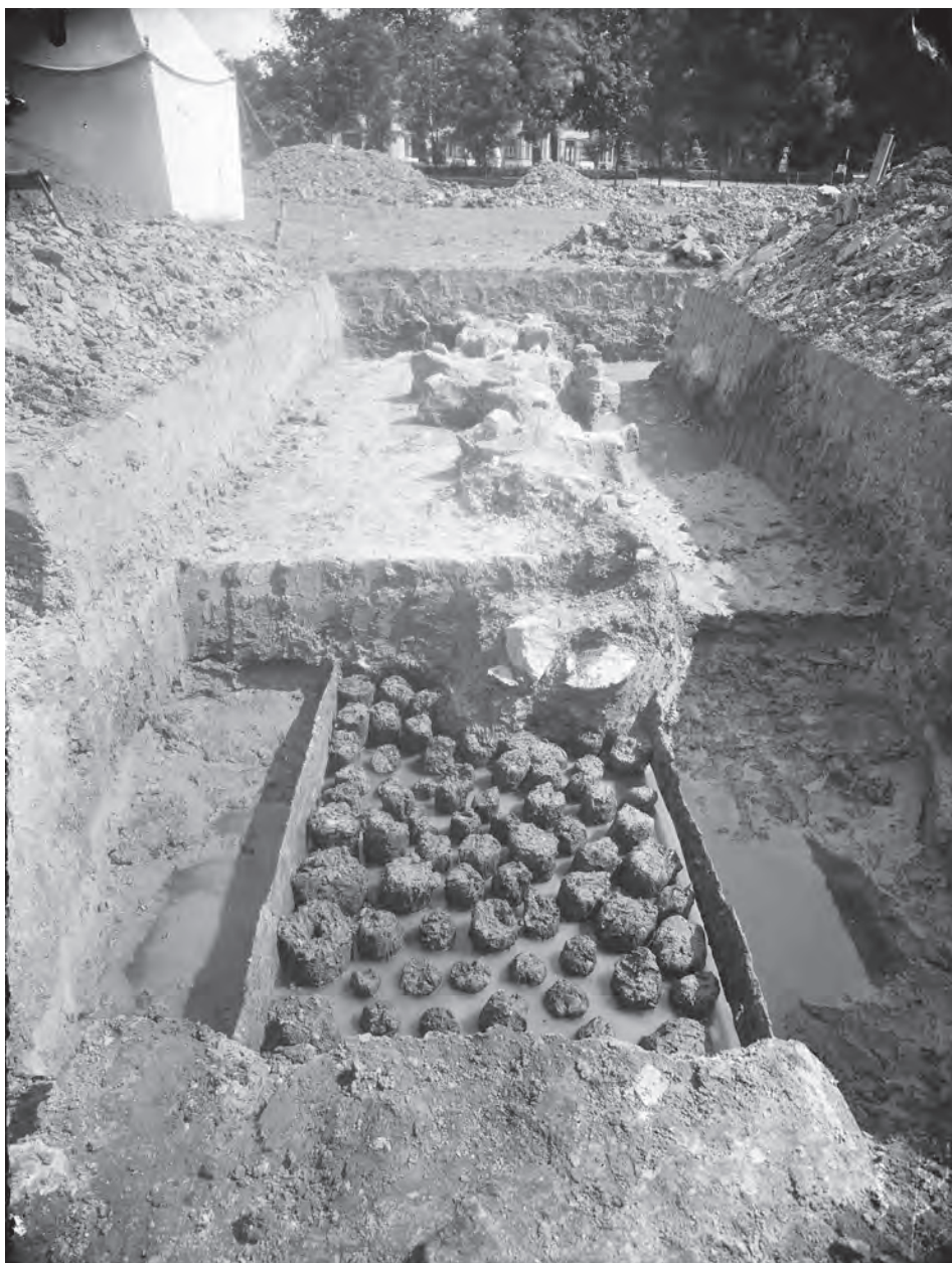
Fig. 4.5. Houten paalfundering onder de stadsmuur in Voorburg. Foto Rijksmuseum van Oudheden, Leiden/Holwerda 1923, 10.
