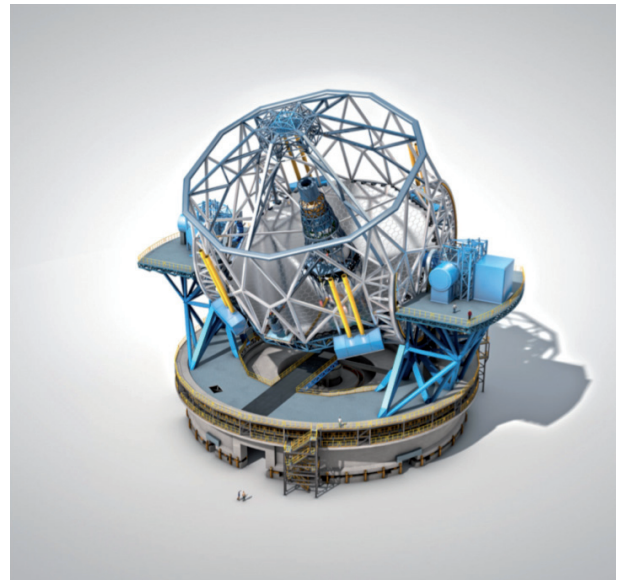
Artiestieke impressie van de European Extremely Large Telescope (E-ELT) met een spiegel-diameter van 39 meter. Let op de kleine mensjes vooraan om een idee van de omvang te krijgen (Credit: European Southern Observatory).
