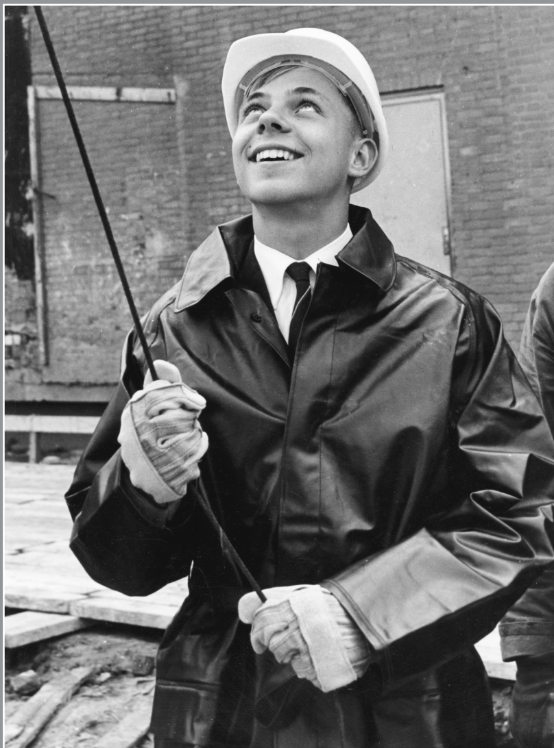
De zoon van Pluygers slaat in 1968 de eerste paal van de nieuwbouw aan de Westblaak.
