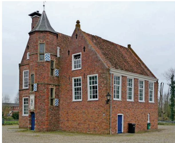
Figuur 357 Wedde vanuit het zuidwesten met rechts het restant van de woontoren. Foto auteur
