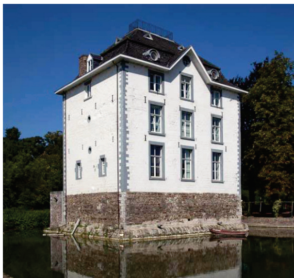
Figuur 64 De Burgh te Heer vanuit het zuidoosten met kelder en begane grond van de woontoren. Foto A. Speelman, www.castlephoto.nl
