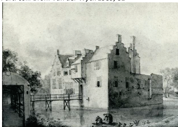
Figuur 154 Hardenbroek vanuit het westen met op de achtergrond de woontoren (met uitgebouwd rookkanaal). Tekening R. Roghman 1646/47. Part. coll. Bron: Van der Wyck 1989, 82
