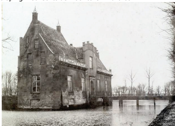
Figuur 191 Lellens vanuit het oosten met op de achtergrond de woontoren. RCE, inv.nr. OF-01319
