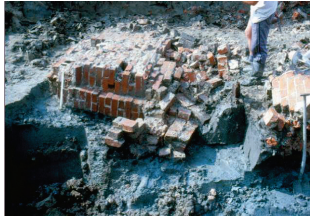
Figuur 391 Detail van de in de gracht aangetroffen omgetrokken zuidgevel van het steenhuis met de zijkant van een venster. Bron: Kortekaas 2000, 22
