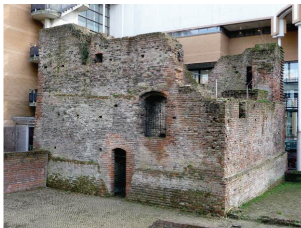
Figuur 295 Het Huis te Riviere uit het noordwesten. Foto auteur
