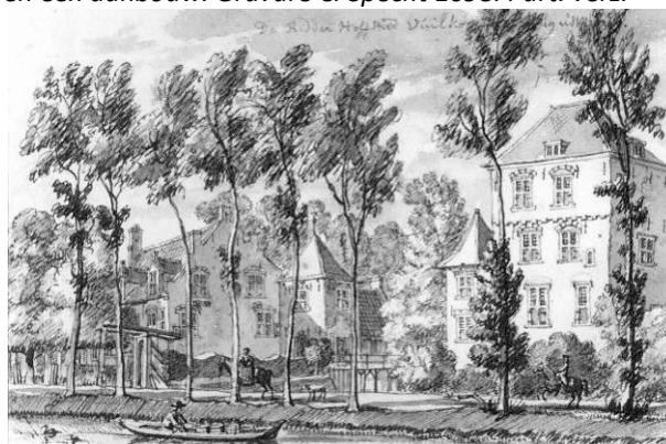
Figuur 341 Vuylcoop vanuit het noordoosten met in de voorgevel duidelijk de tandlijst. Tekening J. de Beijer 1749. KHA, inv.nr. MCS 827
