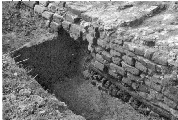
Figuur 137 Detail van de fundering van de oostzijde van de woontoren. Een duidelijk metselverband is niet waarneembaar. RCE, inv.nr. K00-075-01, foto 1
