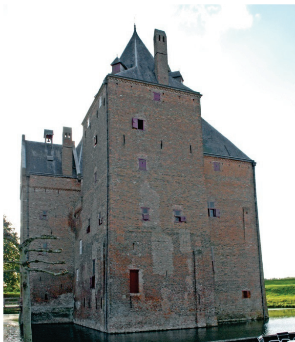
Figuur 206 De noordzijde van Loevestein met op de voorgrond de riddertoren. Het onderste, donkere deel is de oudste fase, de woontoren. Foto auteur
