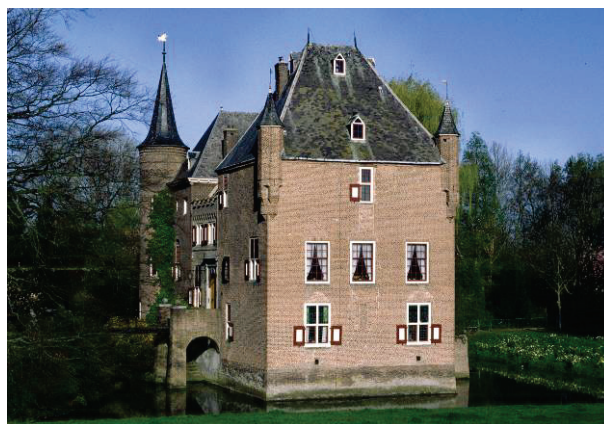
Figuur 372 De oostzijde van kasteel Well met op de voorgrond de woontoren. Foto auteur
