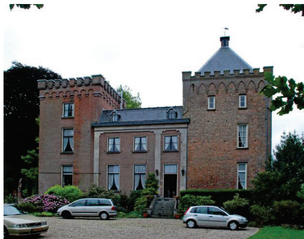
Figuur 283 Rhijnestein vanuit het noordwesten met rechts de woontoren. Foto auteur
