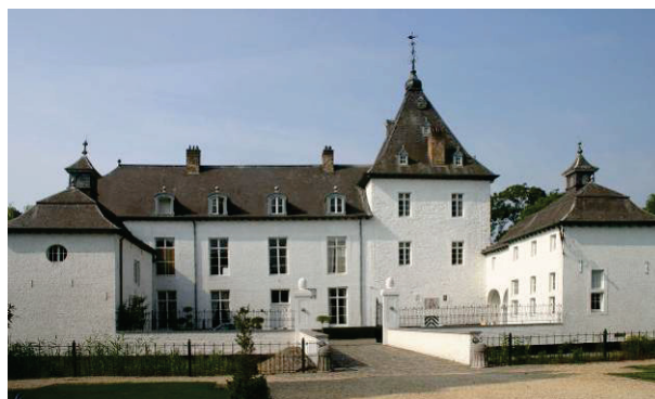
Figuur 119 Rijckholt vanuit het noordoosten met rechts de woontoren. Foto RCE, inv.nr. 359.109
