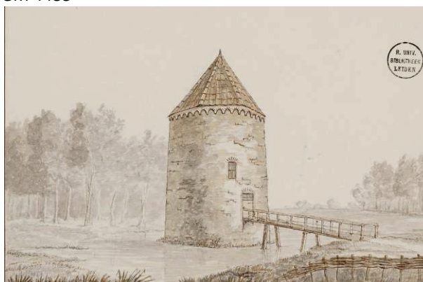
Figuur 95 Drakenburg door F.N.M. Eyck van Zuylichem niet gedateerd. Het onderschrift luidt 'De Blaauwen toren bij Herwijnen afgebroken 1823'. UBL, inv.nr. P306 1N026a
