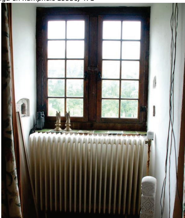
Figuur 355 De oorspronkelijke ingang tot de toren van binnen gezien met links en rechts de sporen van de sluitbalk. Foto auteur
