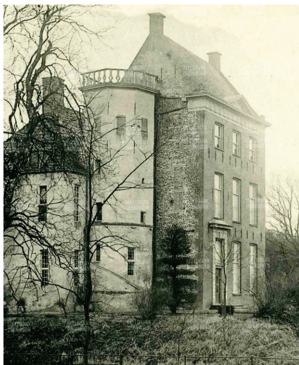
Figuur 86 Het Dijksterhuis vanuit het noordwesten met rechts het steenhuis. De voorgevel is vernieuwd, in de linker zijgevel is nog groot formaat baksteen zichtbaar alsmede dichtgezette kloostervensters. Foto 1902. BG, inv.nr. NL-GnGRA 818 21001
