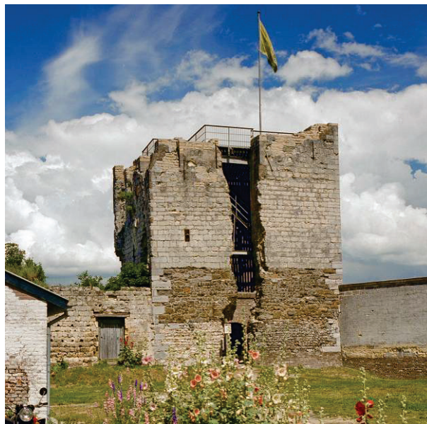
Figuur 201 Lichtenberg vanuit het zuiden. Foto RCE, inv.nr. 320.172
