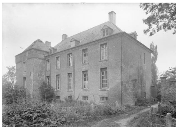
Figuur 59 Kasteel Broekhuizen uit het noordoosten in 1926 met geheel links de voormalige woontoren. Foto RCE, inv.nr. 8.583
