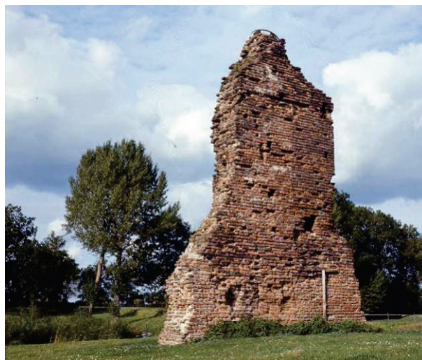
Figuur 150 Te Vliet vanuit het zuiden.
