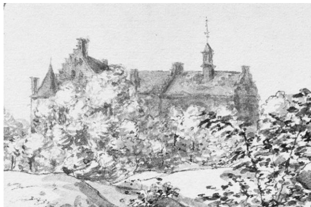
Figuur 205 Lichtenberg in welstand. In de tekening is de toren niet herkenbaar. Tekening V. Klotz ca 1670. Foto RCE
