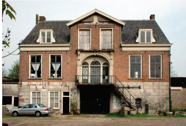
Figuur 11 Te Vliet vanuit het zuidwesten. In het rechter deel bevindt zich het restant van de woontoren. Foto auteur 2009
