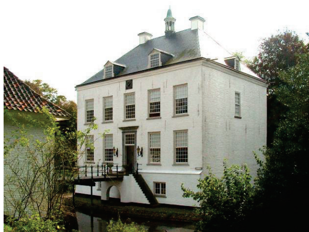
Figuur 8 Loon op Zand vanuit het noordwesten. De oorspronkelijke woontoren bevindt zich in het rechter deel van het huis. Foto auteur 2005
