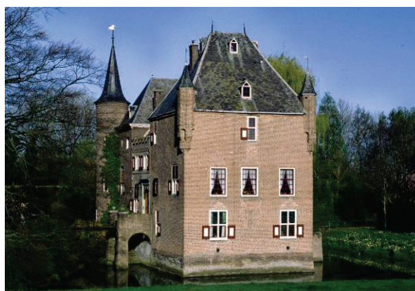
Figuur 16 Well vanuit het zuidoosten. Foto auteur 2005
