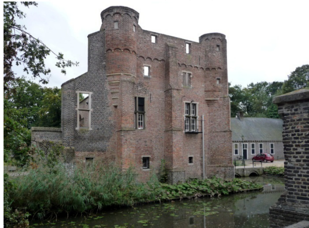
Figuur 4 Groot Deurne vanuit ongeveer dezelfde hoek als figuur 3 met de steunberen onder de arkeltorens. Foto auteur
