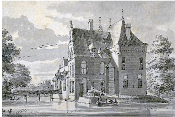
Figuur 2 Kasteel Avestein met een aantal architectuurhistorische details zoals de speklagen in de vleugel links en het rondboogfries en de arkeltorens in de vleugel rechts. BC, inv.nr. D 50.4 820.11 Aves (4)
