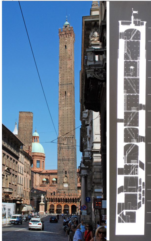
Figuur 11 De Torre Garisenda (links) en de Torre degli Asinelli (rechts) te Bologna. Geheel rechts een doorsnede door de Torre Prendiparte te Bologna. Foto's auteur
