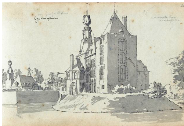
Figuur 1 Kasteel Ooij (Gld.) met op de voorgrond de vermoedelijk 12de-eeuwse toren, volgens het opschrift opgetrokken in 'duifsteen' ofwel tufsteen. Uit deze afbeelding kan niet worden afgeleid of de toren in oorsprong solitair stond op de heuvel of binnen een ringmuur. Tekening van A. de Haen II. RPK, inv.nr. BI-1897-387-B-21
