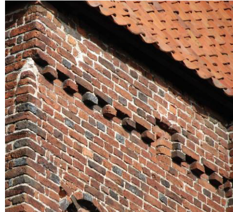
Figuur 7 Detail van de tandlijst langs de bovenzijde van de poorttoren van de voorburch van Tongelaar. Foto auteur 2007
