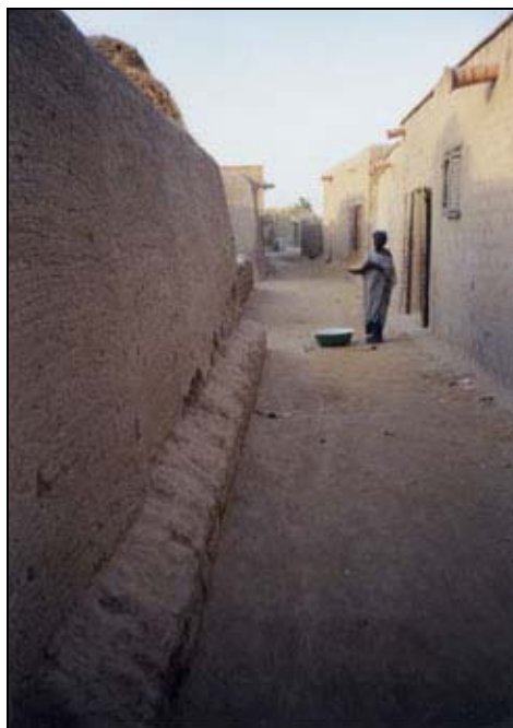
Muur met basement.
