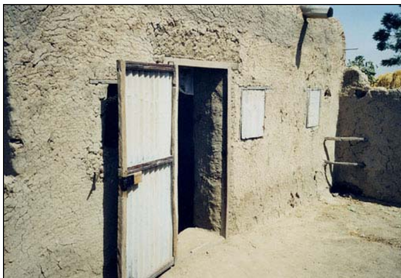
Golfplaten deur en ramen van een kamer.
