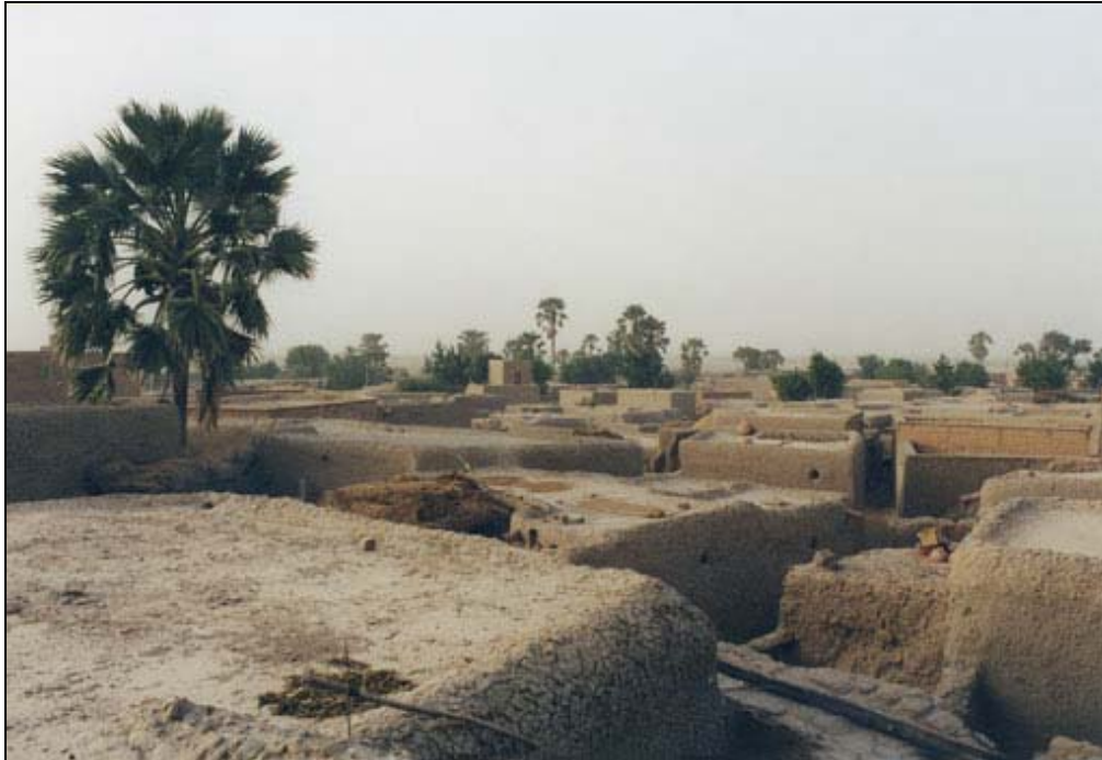
Dia: platte daken met aardewerk spuwers.
