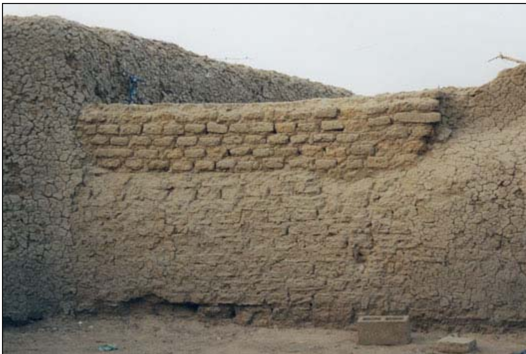
Op een oude muur is een nieuwe verhoging aangebracht.
