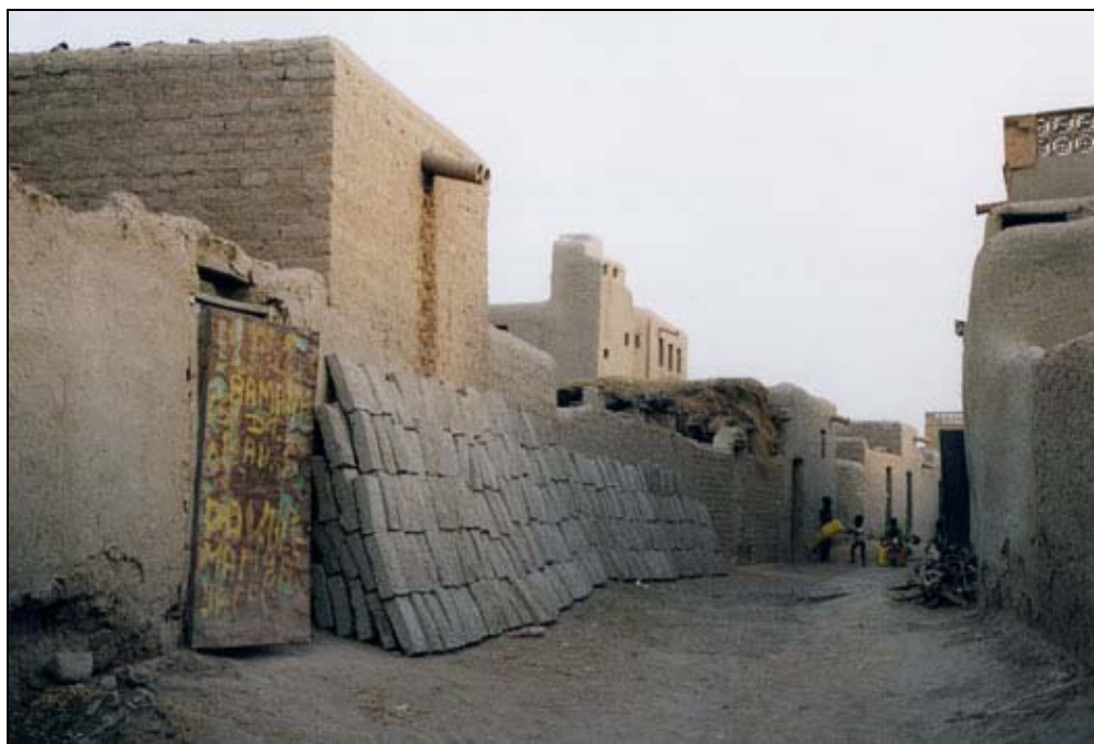
Gestapelde tichels, klaar voor gebruik bij een woning.
