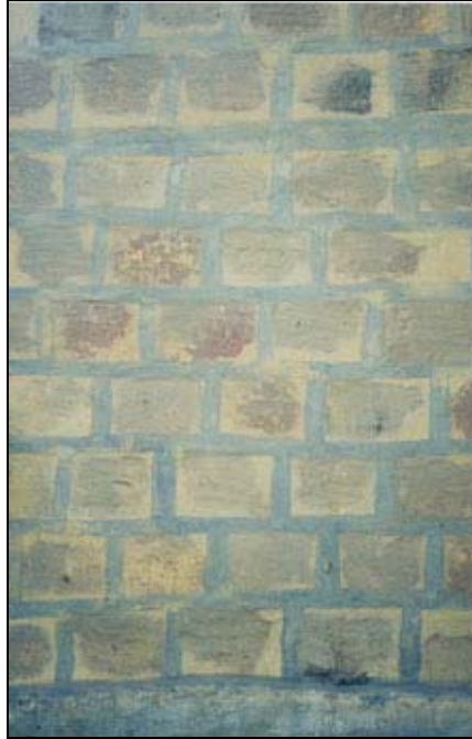
Lemen muur bekleed met metselwerk tegels in cement.
