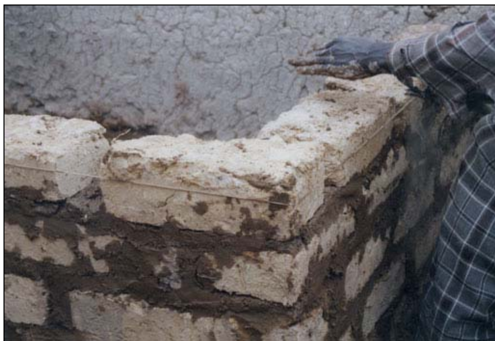
In de zon gedroogde lemen stenen worden vermetseld met leem.
