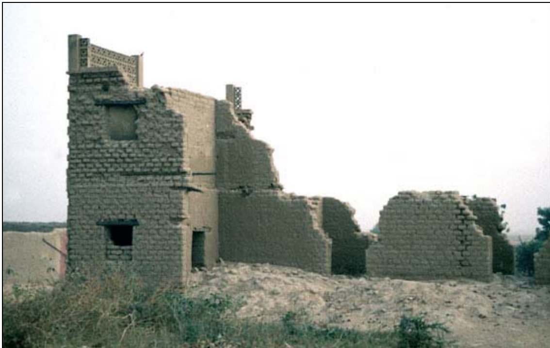
Ruïne met op het dak een borstwering van patioblokken.
