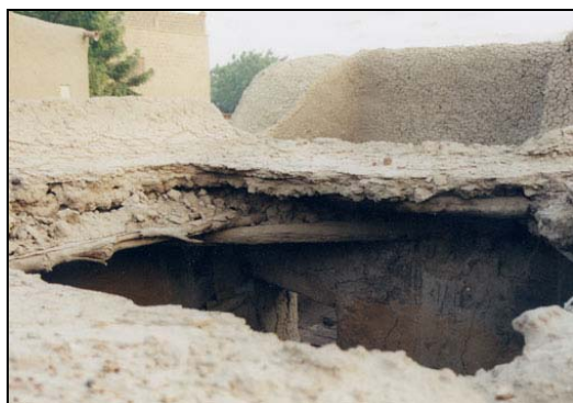
Inkijk op de plafondconstructie.
