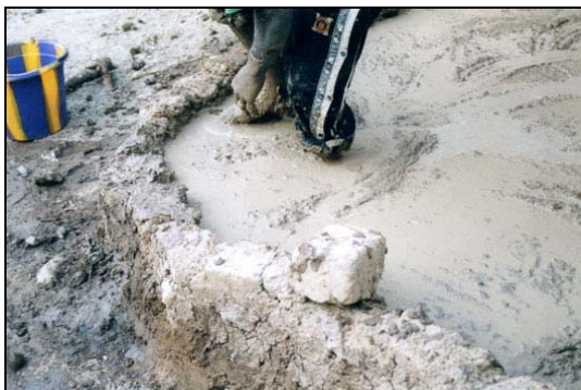
Het mengen van de leempleister.
