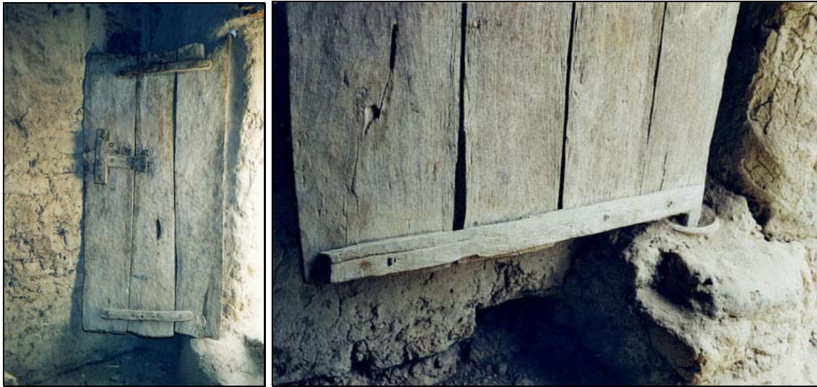
Scharnierpunten van oude deur voorzien van slot.
