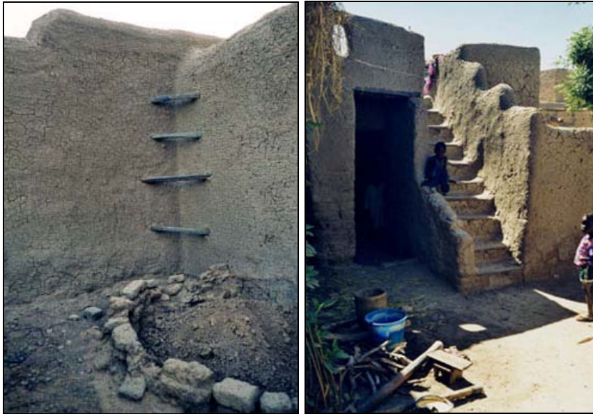
Dia: trappen naar het platte dak.
