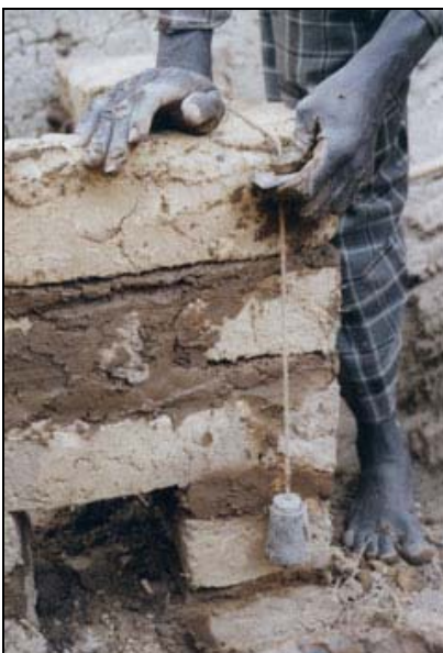
Gebruik van het schietlood.
