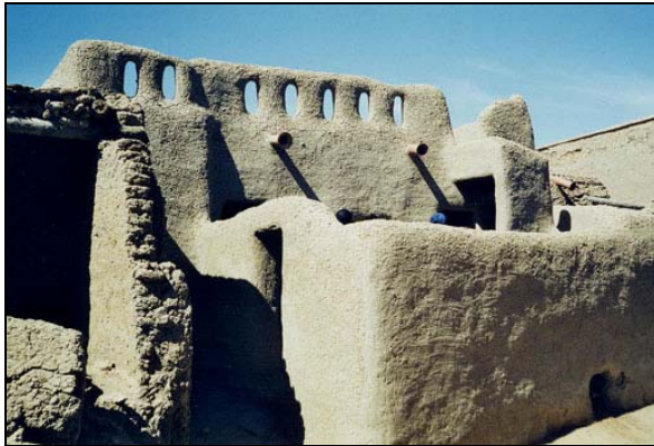
Aardewerk afwateringsbuizen, links door de lemen muur stekend, rechts een los exemplaar (RMV 5746-48).
