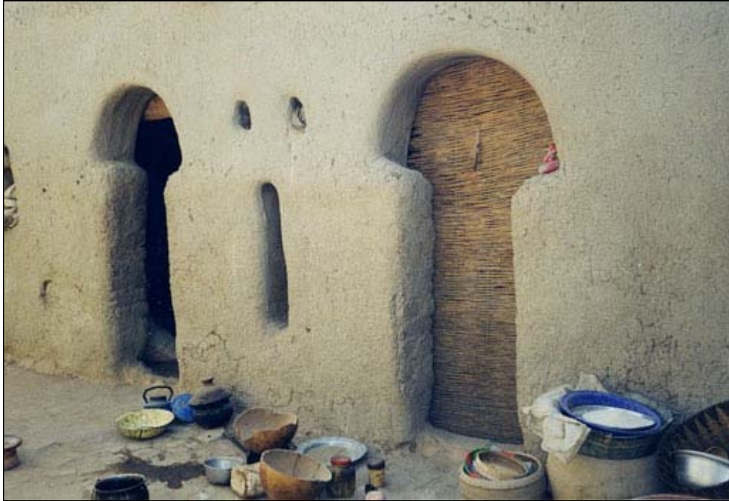
Toegangen van binnenplaats naar veranda.
