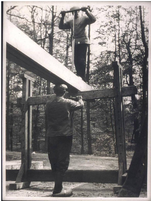
Demonstratie van het zagen met een kraanzaag. Collectie Nederlands Openluchtmuseum, Inv.nr.: AA 11150.
