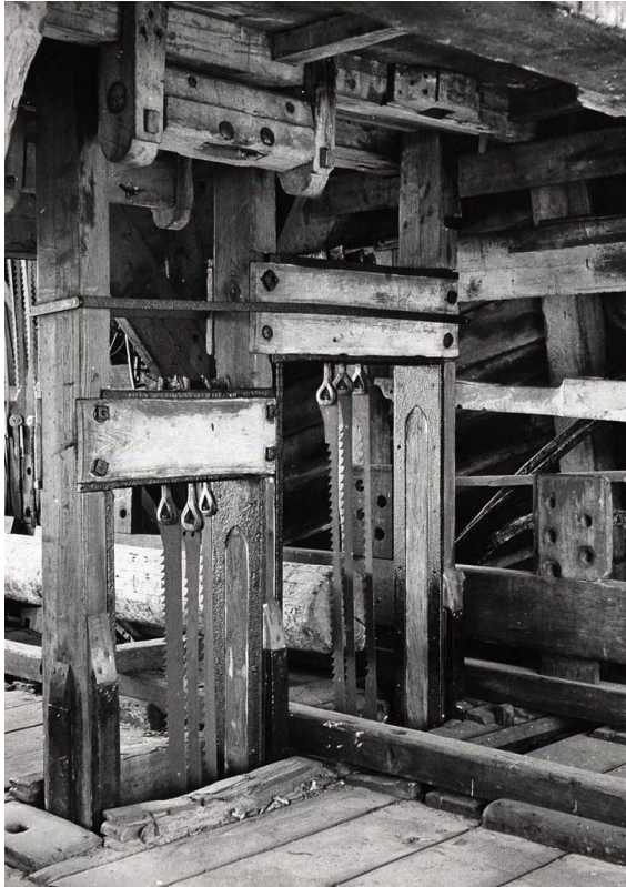
Interieur met de zaagramen van een paltrok windhoutzaagmolen uit Numansdorp. Collectie Nederlands Openluchtmuseum, Inv.nr.: AA 8075.
