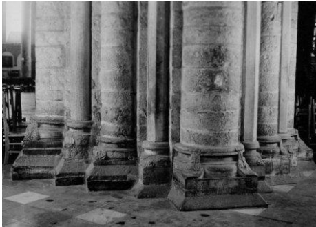
I.3.11A links: zuidwestelijke vieringpijler, tussen het schip (rechts) en de viering (links) (foto: KIK-IRPA).
