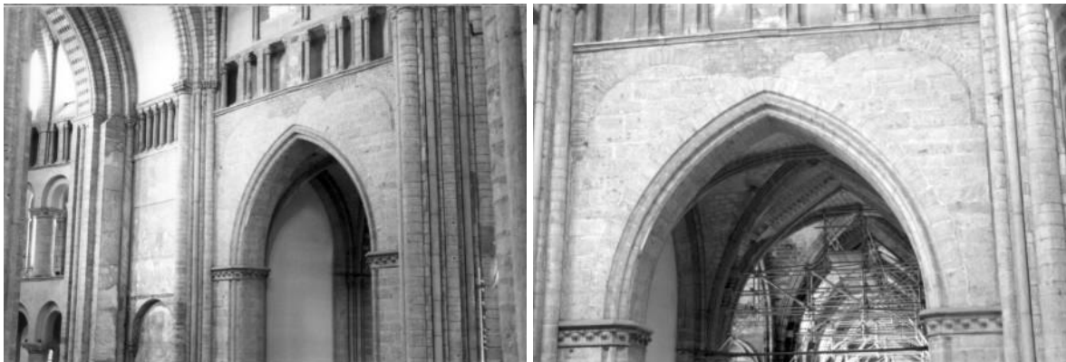
I.5.2.28A links: noordelijke transeptarm, oostwand (foto: JW).
