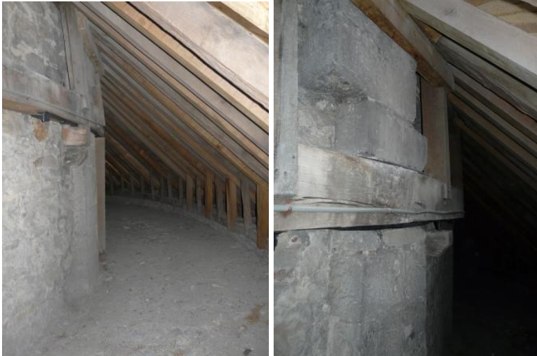
I.5.6.10.3A links: Zuidelijke transeptarm, apsis, lessenaarsdak van de galerij met achterwand van het triforium (links).
