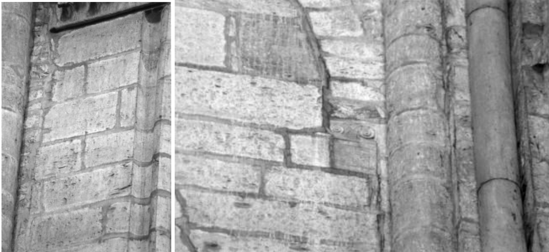
I.5.3.36A links: zuidelijke transeptarm, dubbeltravee, oostzijde, bouwnaad naast de vieringpijler onder het kapiteelfries van de 13 de -eeuwse pijler (foto: JW).
