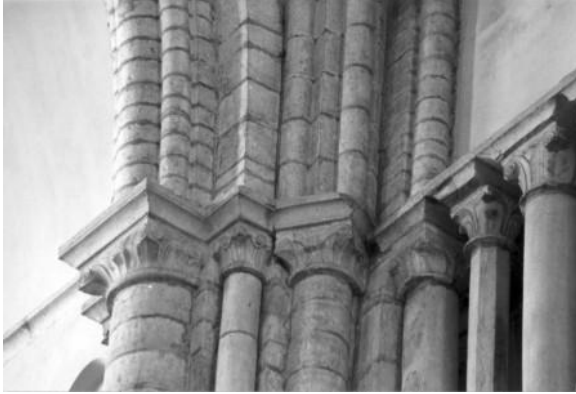
I.5.3.3A links: zuidelijke transeptarm, westzijde, dubbeltravee, pijler op de grens met de travee tussen de torens (JW).
