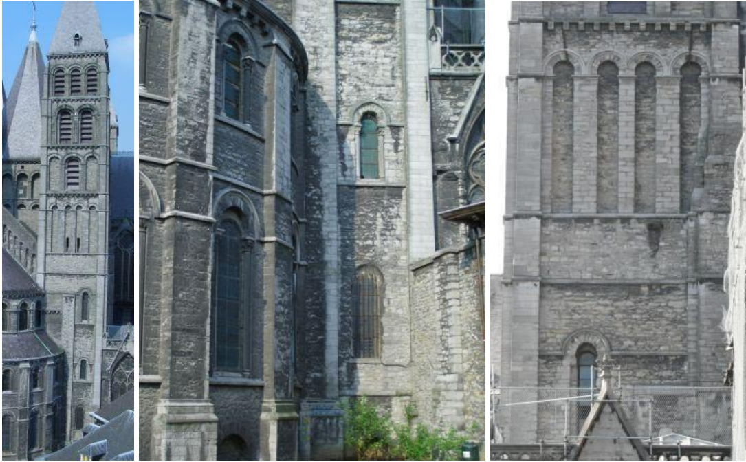
I.5.3.50A links: zuidelijke transeptarm, Mariatoren (foto: JW).
