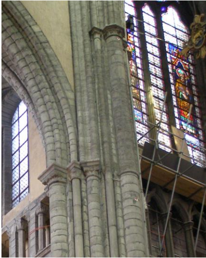
I.5.6.13.1A links: noordoostelijke vieringpijler met de astragaal van de oorspronkelijke diafragmahoog naar het koor (foto: JW).
