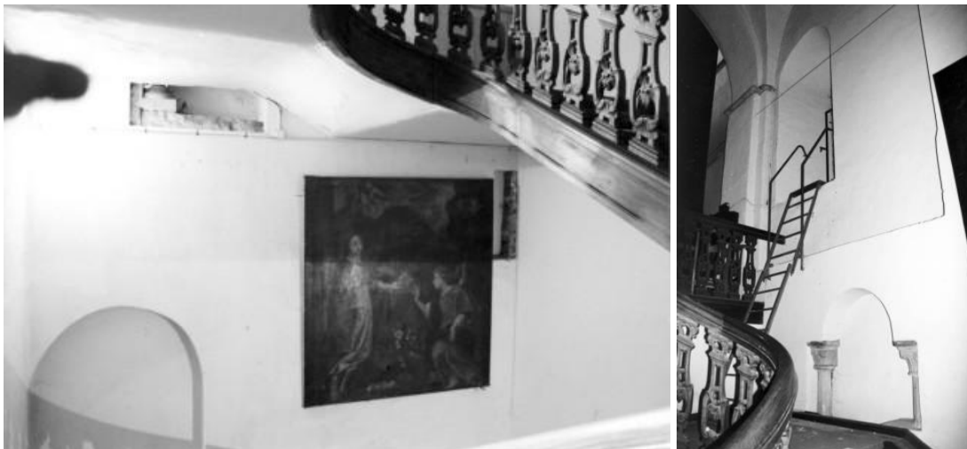
I.2.17A links: westpartij, trappenhuis in de noordelijke zijruimte, westwand met links onder de dichtgezette boogopening van de doorgang door de westmuur, rechts naast het schilderij een fragment van het begin van de wenteltrap in de noordwesthoek en boven de sokkel van de linker colonnet van de blinde rondboognis (foto: JW).
