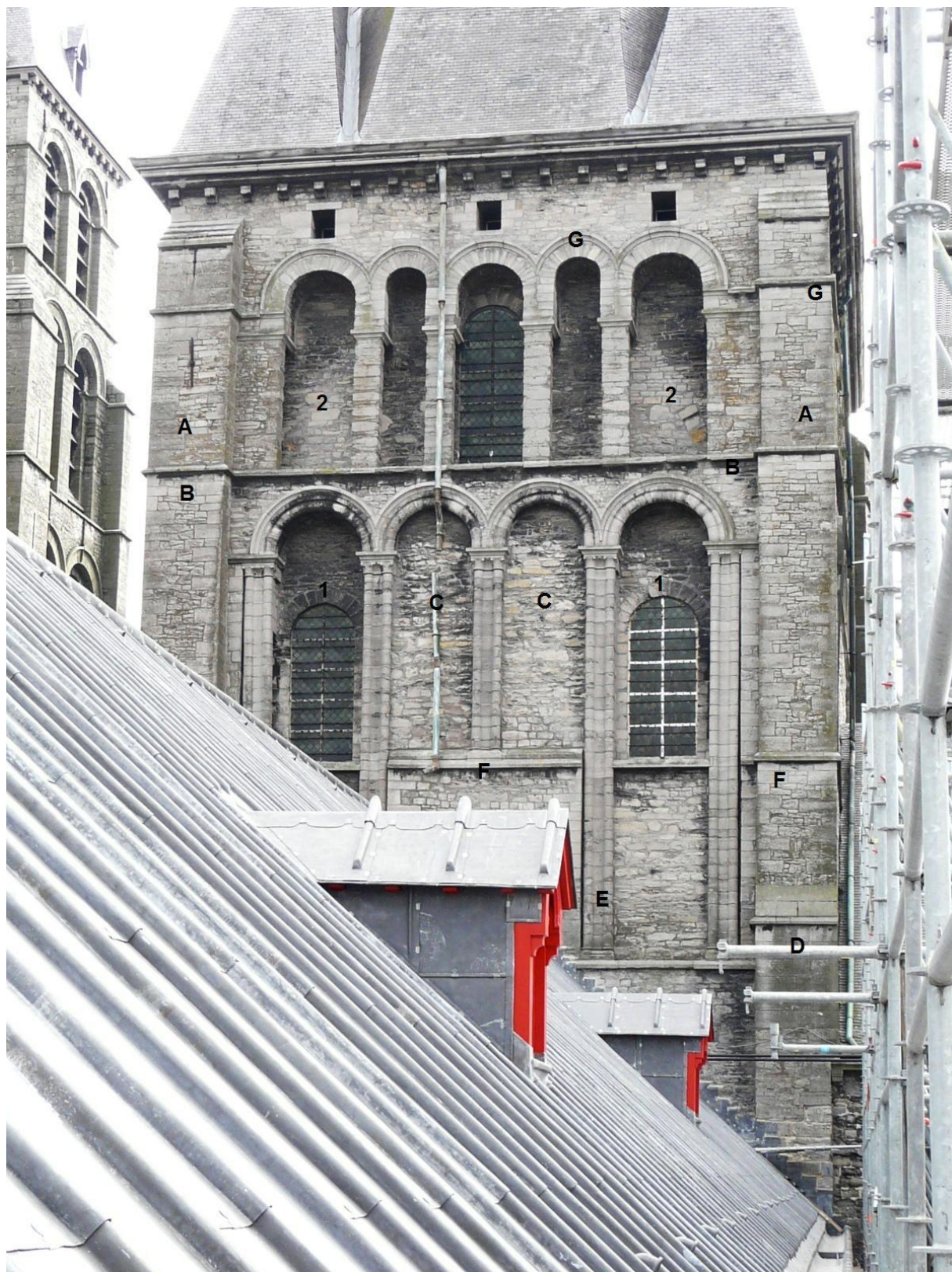
I.5.4.1A: Vieringtoren, westzijde, gezien vanaf de zuidzijde van het schip. (1) Niveau 1, (2) Niveau 2, (A) steunberen, (B) waterlijst, (C) blinde delen van de arcade, (D) verzwaaarde steunbeer, (E) verlengde rechtstanden van de buitenste bogen, (F) waterlijst, (G) steunberen (foto: JW).
