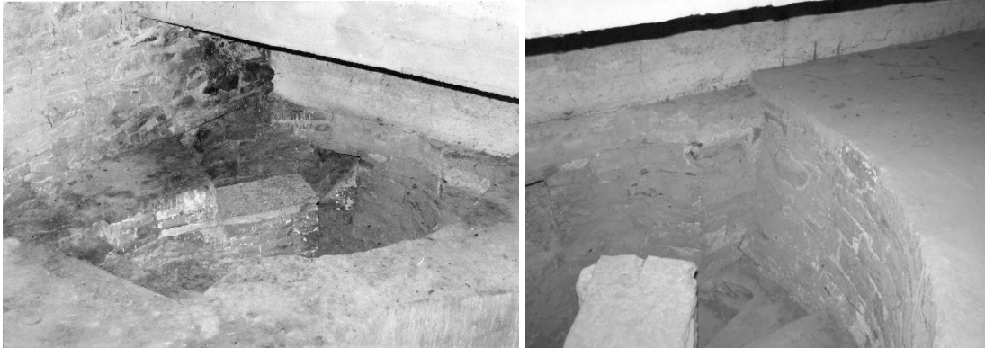
I.2.29A links: westpartij, zolder van de noordelijke galerij, aankomst van de wenteltrap (foto: JW).
