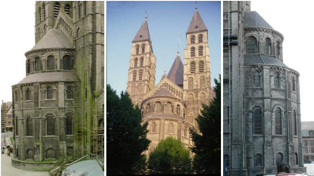
I.5.2.21A links: noordelijke transeptarm, apsis, gezien van het westen (foto: JW).
