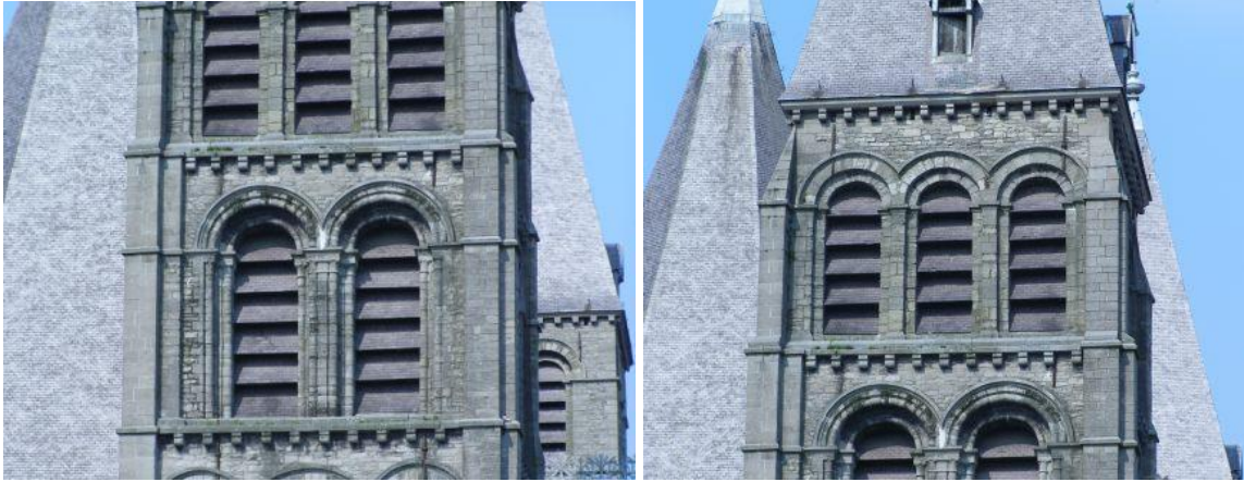
I.5.3.55A links: Mariatoren, zuidzijde, voorlaatste bouwlaag (niveau 8) (foto: JW).
