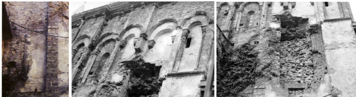
I.2.13A links: westpartij, noordgevel, benedenzone, muurwerk rechts naast de oostmuur van de voormalige kapittelzaal (foto: JW).
