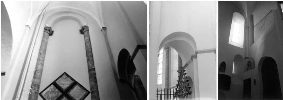
I.5.2.25A links: Sint-Janstoren, zaal op de begane grond, westmuur (richting middenbeuk) (foto: JW).
