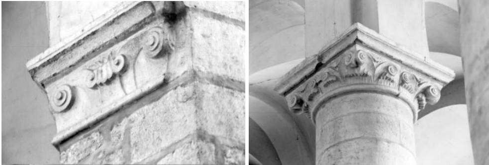
I.5.3.21A links: zuidelijke transeptarm, scheiboog van de apsis, kapiteel tegen de pijler op de hoek van de Parochietoren (foto: JW).
