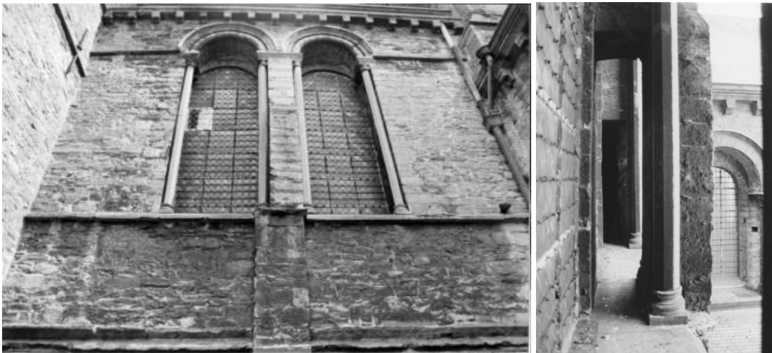
I.5.2.10A links: noordelijke transeptarm, westzijde, lichtbeuk van de dubbeltravee (foto: JW).
