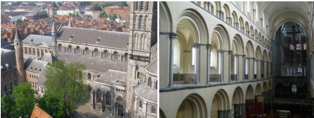
I.3.1A links: schip, gezien vanaf het belfort (foto: JW).
