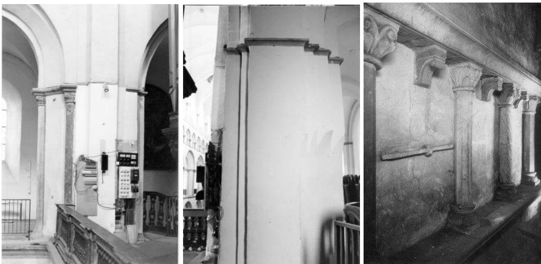
I.2.27A links: westpartij, zuidelijke vrijstaande pijler op de overgang van westpartij en schip: noordzijde (links het schip, rechts de galerij van de westpartij) (foto: JW).
