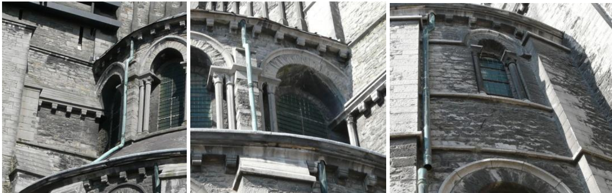
I.5.6.10.2A links: zuidelijke transeptarm, aansluiting van de lichtbeuk van de apsis tegen de Parochietoren (foto: JW).
