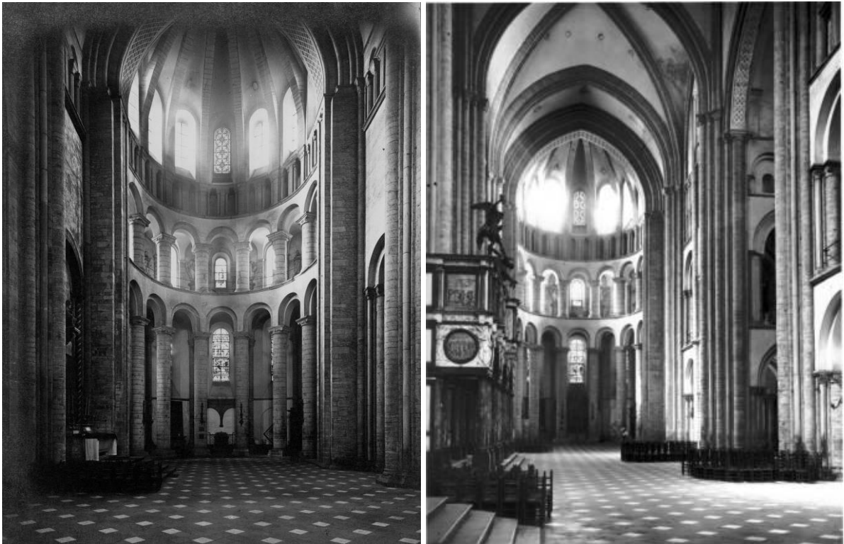
I.5.3.18A links: zuidelijke transeptarm, de apsis vanuit het noorden (foto: KIK-IRPA)
