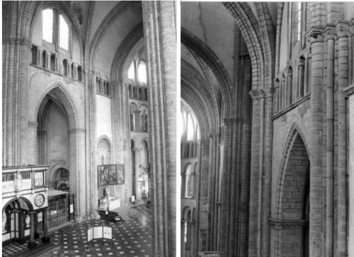
I.5.3.34A links: zuidelijke transeptarm, oostzijde, gezien vanuit de noordgalerij van het schip (foto: JW).
