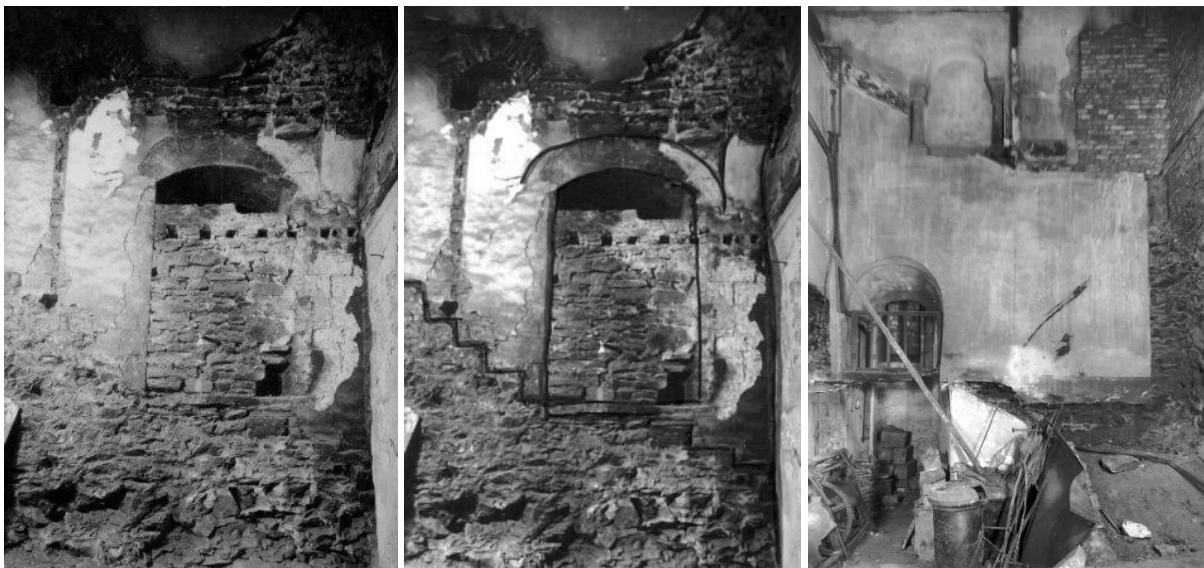
I.2.39A links en midden: westpartij, noordelijke zijruimte, noordwand in 1944 (foto: Commissariat général à la Restauration du pays. © KIK-IRPA, Brussel, A58931).
