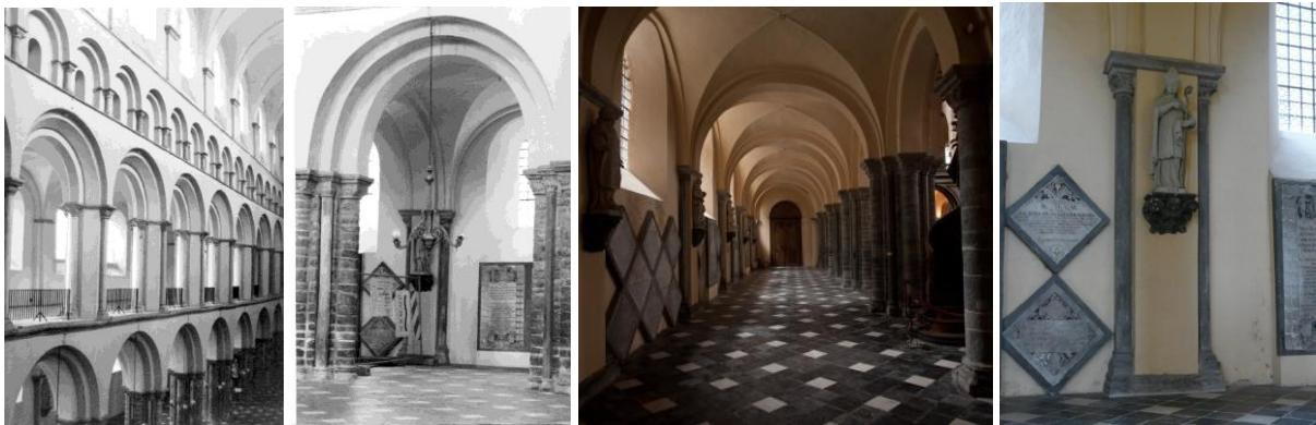
I.3.8A links: schip, opstand van de noordzijde (foto: JW).
