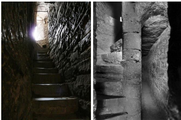
I.5.2.41A links: Brunintoren, trap in de dikte van de westmuur (foto: JW).
