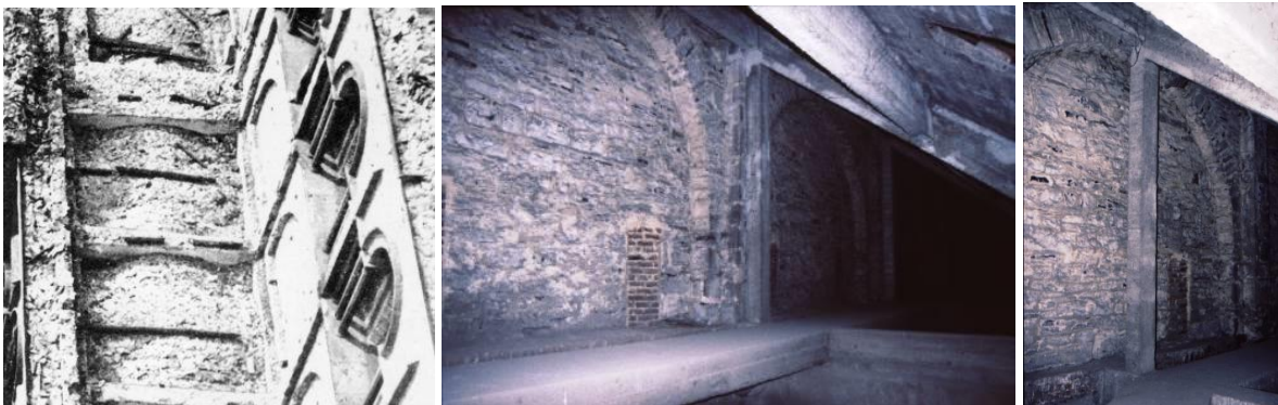
I.3.10A links: zicht op de galerijen, de achterwand van het triforium en de lichtbeuk, 1940 (foto: Kanunnik Paul Dewinter).
